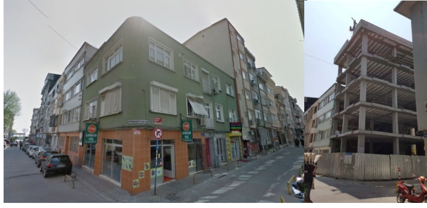
Şekil 3.11 : Lamibey Sokak bina örneği.
