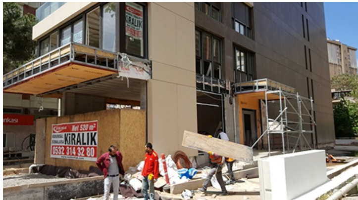
Şekil 3.25 :Örnek B Apartmanı'nın yapım süreci örneği.
