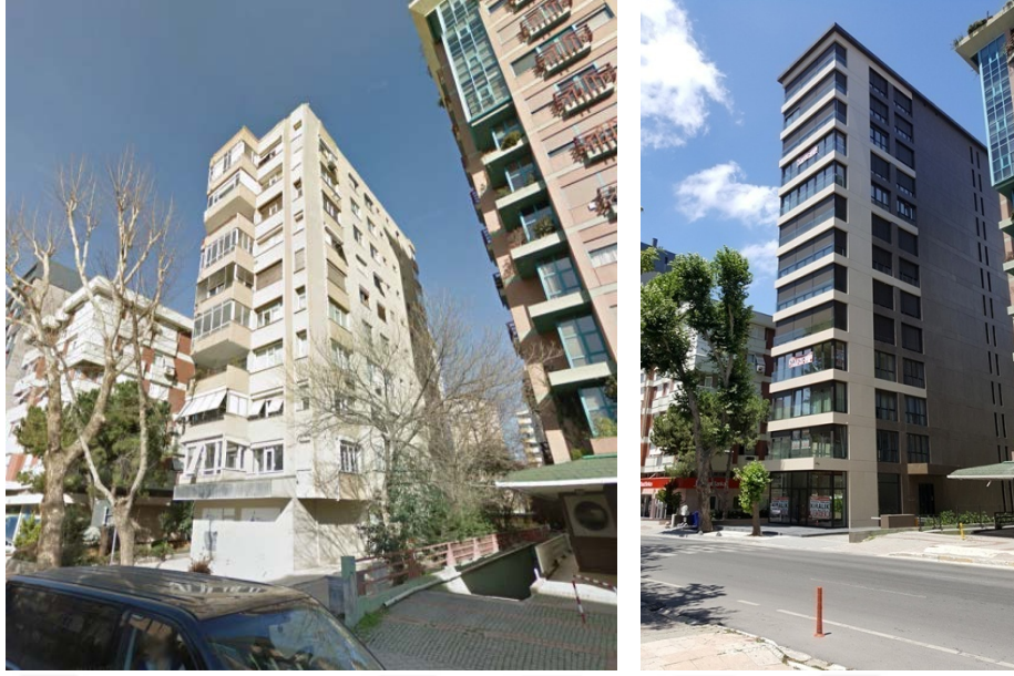
Şekil 3.24 :Örnek B Apartmanı'nın yenileme süreci örneği.
