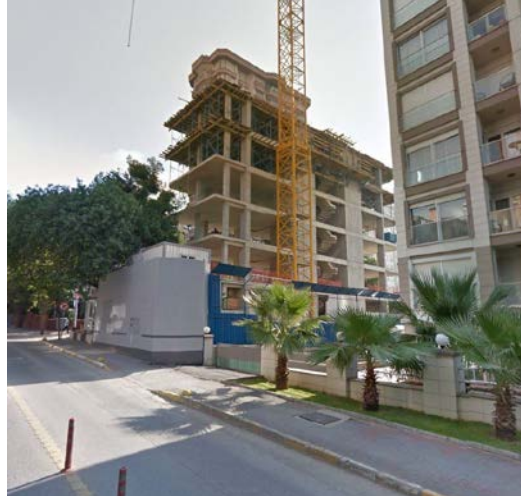
Şekil 3.23 : Örnek A Apartmanı'nın yapım süreci örneği.
