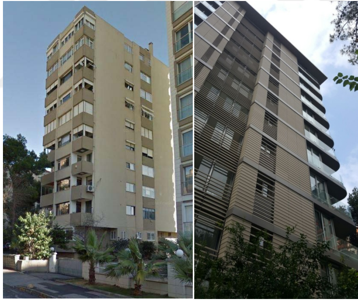
Şekil 3.22 :Örnek A Apartmanı'nın yenileme süreci örneği.
