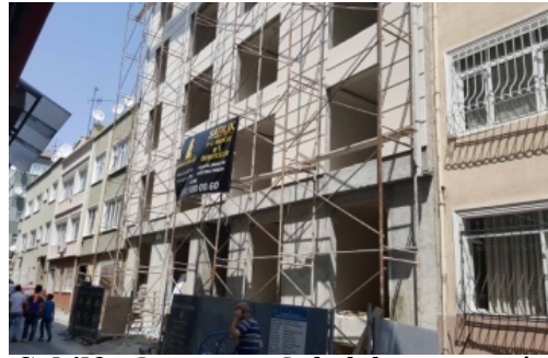
Şekil3.13 :Pancar Sokak bina örneği.
