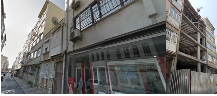
Şekil 3.14 : Ömer Naci Sokak bina örneği.
