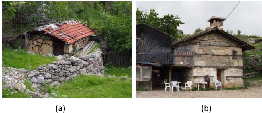
Şekil 3. 10 (a), (b) Geleneksel kırsal yapılarda devşirme malzeme kullanımı
