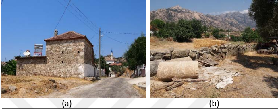
Şekil 3. 104 (a) Yapı köşelerinde antik taş kullanımı (b) Sınır duvarında devşirme taş kullanımı
