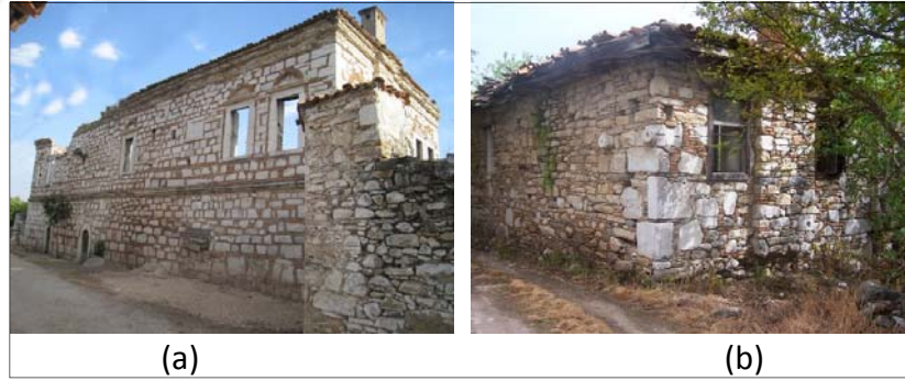
Şekil 3. 82 (a) Devşirme taşlardan inşa edilmiş Ağa Evi [186]. (b) Tek yapı ölçeğinde katmanlaşma [190].
