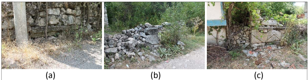
Şekil 3. 62 (a), (b), (c) Arkeolojik fragmanların bahçe duvarlarının inşasında kullanımı
