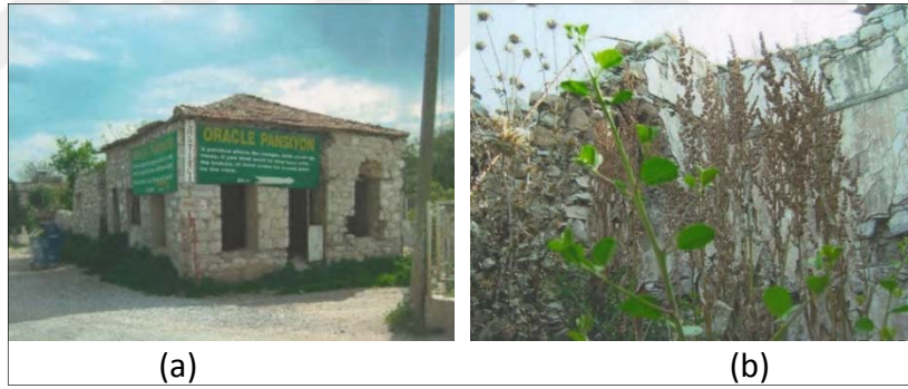
 ekil 4. 12 Yıkım kararı verilen (a) 1852 parsel sayılı yapı (b) 1915 parsel sayılı yapı kalıntısı [253].
