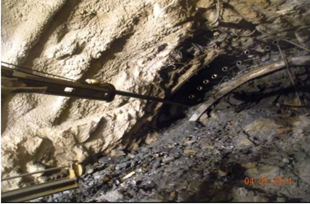
Şekil 4.26. T2 tüneline şemsiye kazığı montajı
