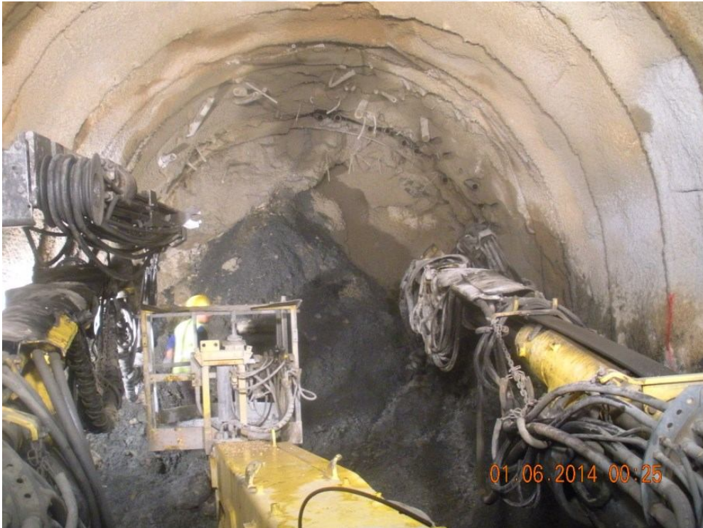
Şekil 4.18. T2 tüneline şemsiye kazık uygulaması
