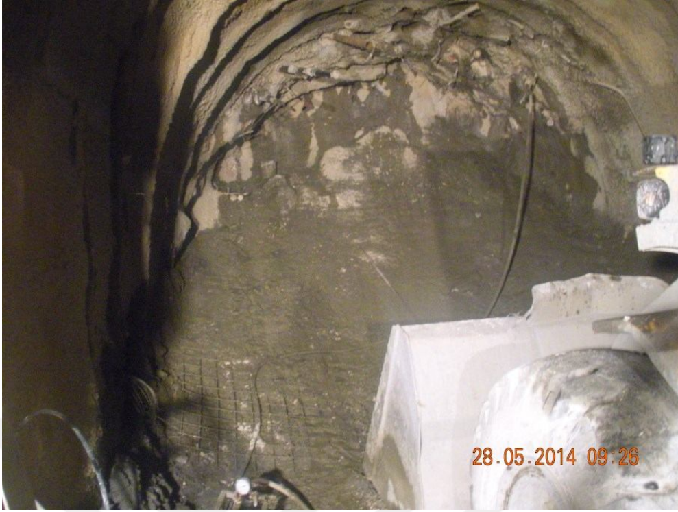
Şekil 4.17. T2 tüneline göçük alanına yapılan enjeksiyon uygulaması
