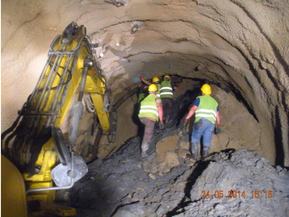
Şekil 4.22. T2 tüneli göçük bölgesinde parçalı iksa montajı
