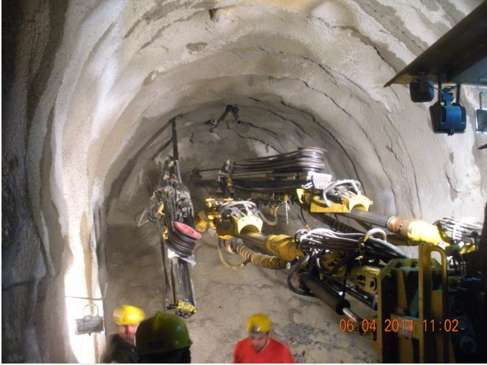
Şekil 4.25. T2 tüneline dolgu beton öncesi çelik boru montajı
