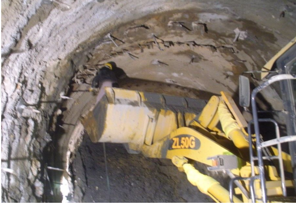
Şekil 4.31. T2 tüneline km: 1+280-1+270 arasında enjeksiyon uygulaması
