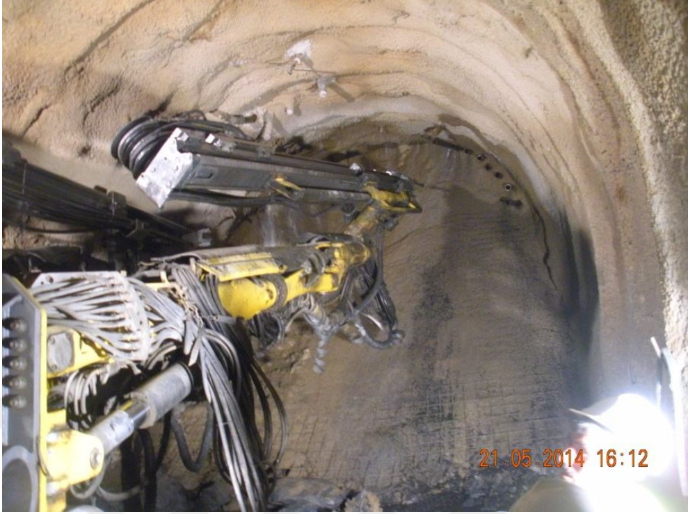
Şekil 4.21. T2 tüneli aynasında şemsiye kazığı montajı
