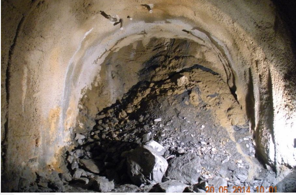
Şekil 4.19. T2 tüneline göçük sonrası kazı aynası ve göçük malzemesinin görünümü
