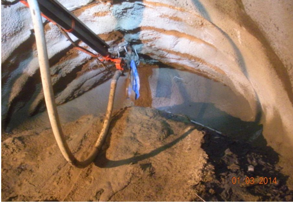
Şekil 4.29. T2 tüneline ayna üzerine dolgu betonu uygulaması
