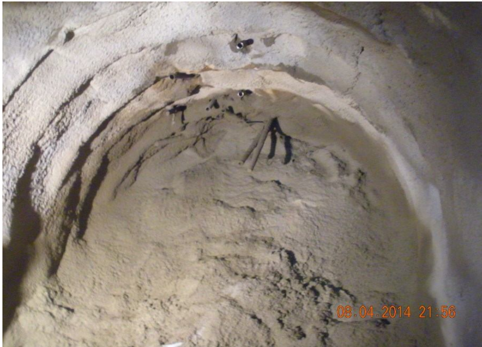
Şekil 4.14. T2 tüneline göçük bölgesine dolgu beton ve şemsiye kazığı uygulaması
