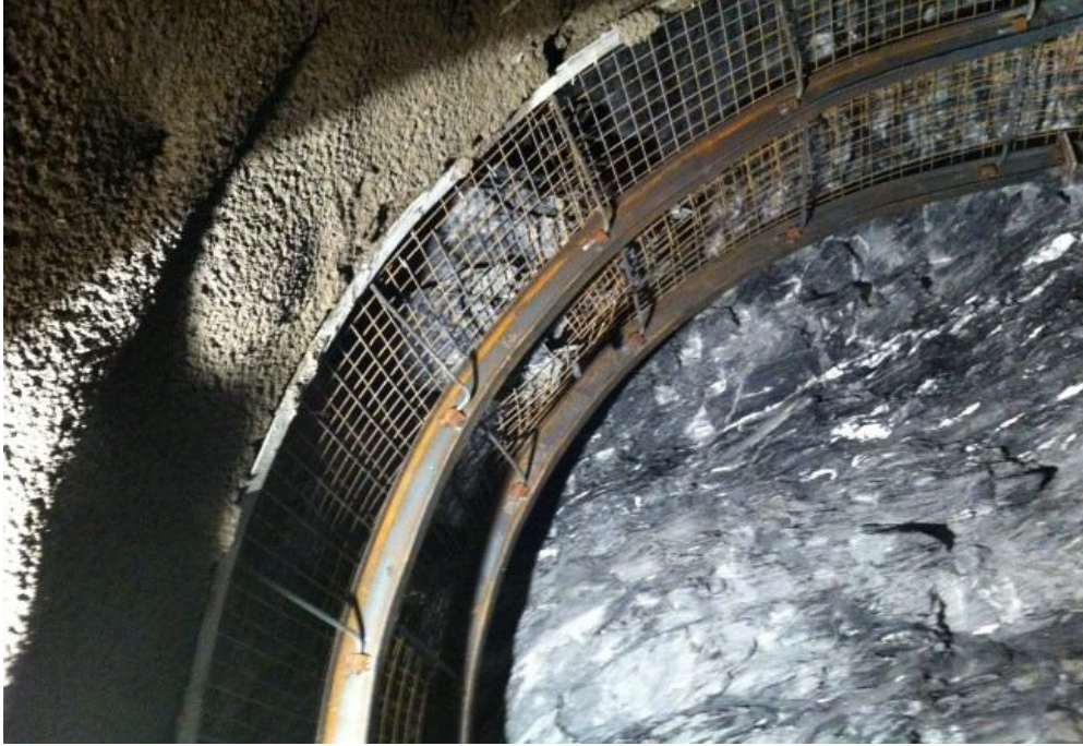
Şekil. 4.28. T2 tüneline IPN 160'lık çelik iksa uygulaması
