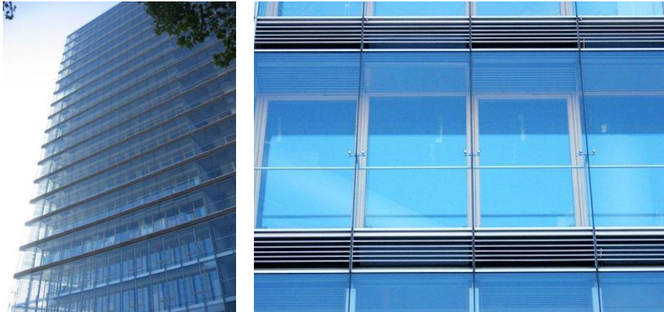
Şekil 3.85 Kat yüksekliğinde çift tabakalı cephe sisteminin yakın görünüşü [246]
