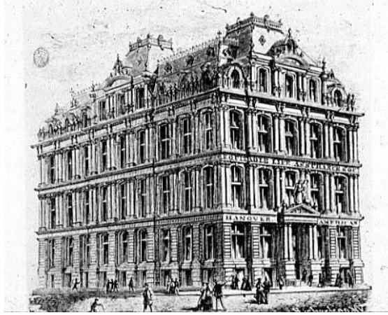
Şekil 2.7 Equitable Life Insurance Company Binası (New York)
