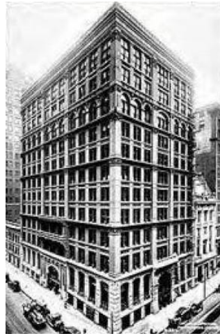
Şekil 2.8 Home Insurance Binası, Chicago
