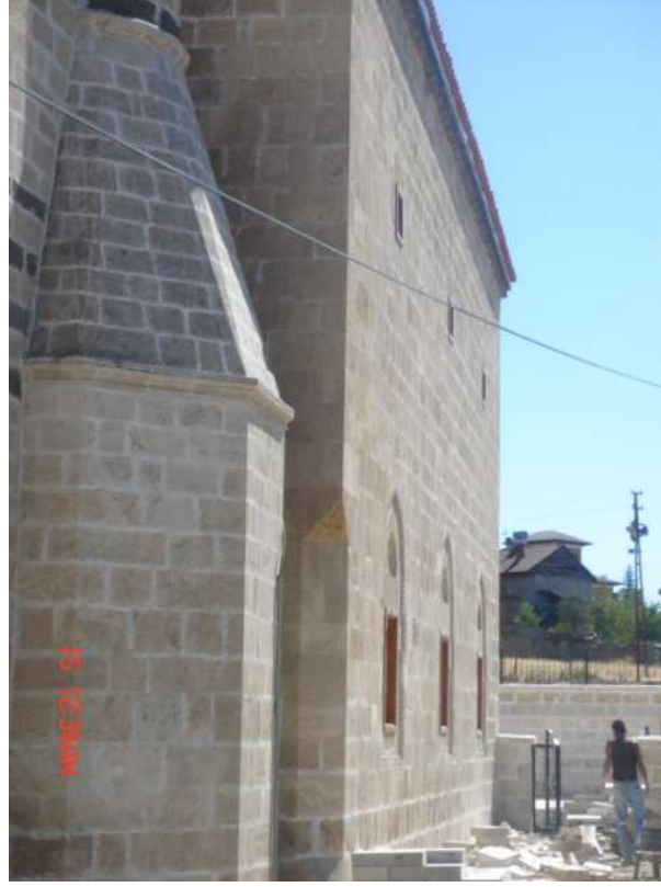
Fotoğraf 27: Cedit Paşa Camii Batı Cephe
