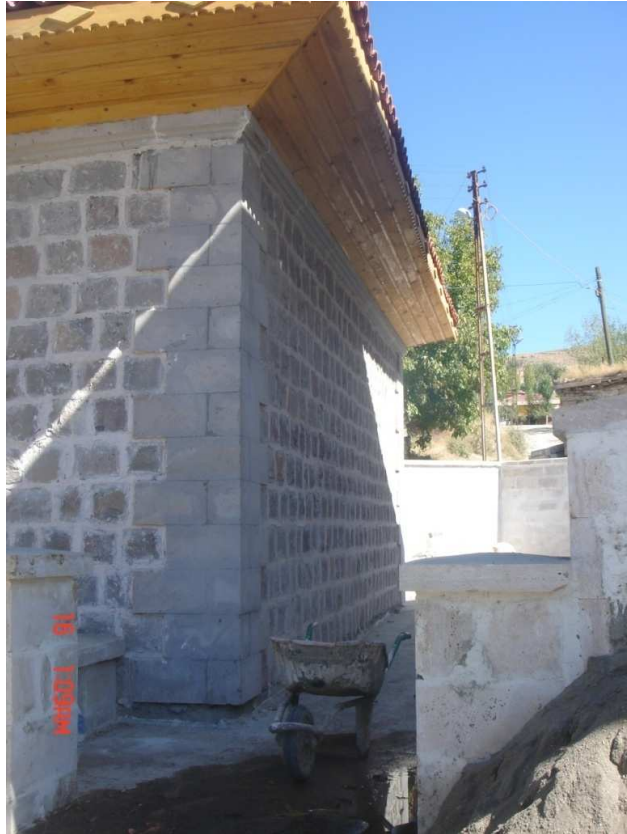
Fotoğraf 162: Turabali Mescidi Güney Cephesi
