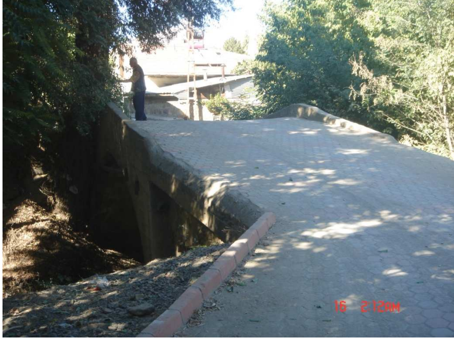
Fotoğraf 271:Kara Yusuf Mahallesi Köprüsü
