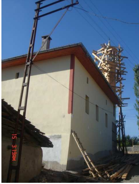
Fotoğraf 135: Süleyman Ağa Camii Doğu Cephe
