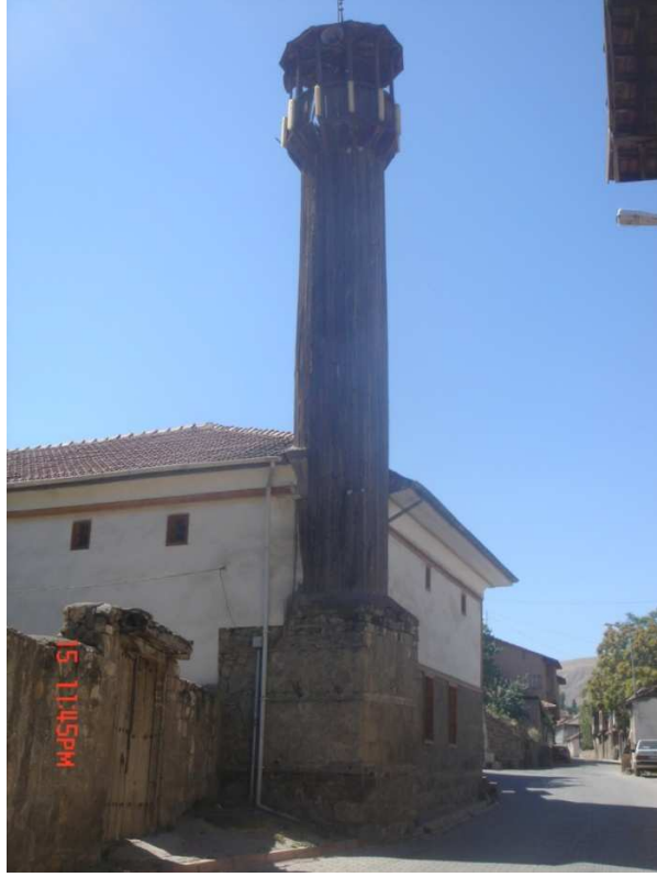
Fotoğraf 11: Abuçimen Camii Minaresi
