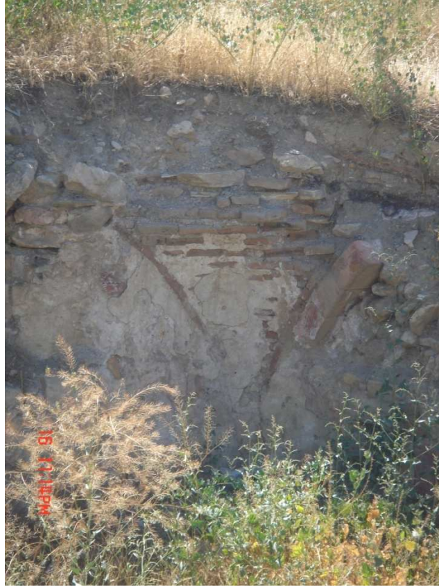
Fotoğraf 264: Behramşah Hamamı Kalıntıları
