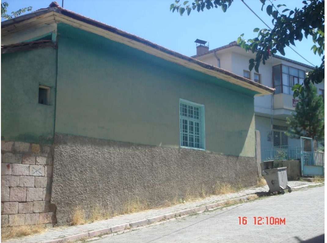
Fotoğraf 104: Koca Paşa ( Saray ) Camii Batı Cephe
