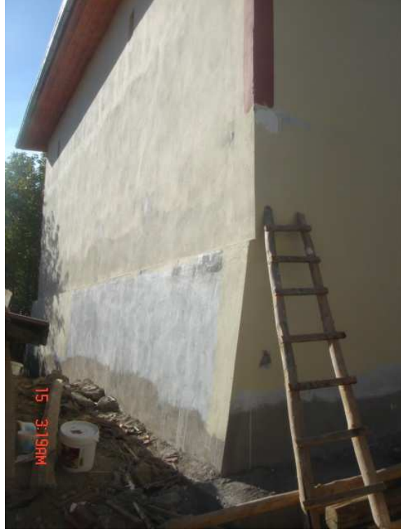
Fotoğraf 136: Süleyman Ağa Camii Güney Cephe
