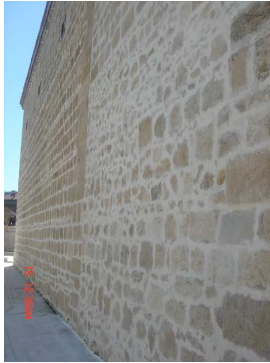
Fotoğraf 28: Cedit Paşa Camii Doğu Cephe
