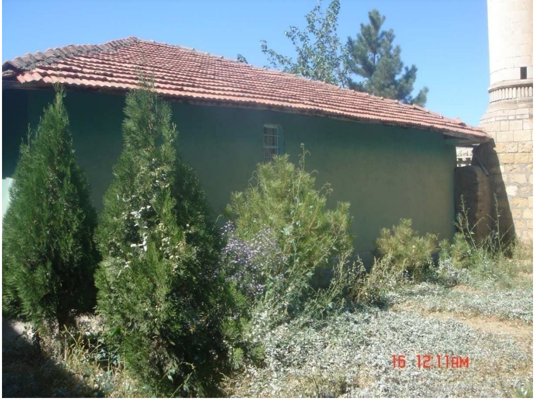
Fotoğraf 106: Koca Paşa ( Saray ) Camii Doğu Cephe
