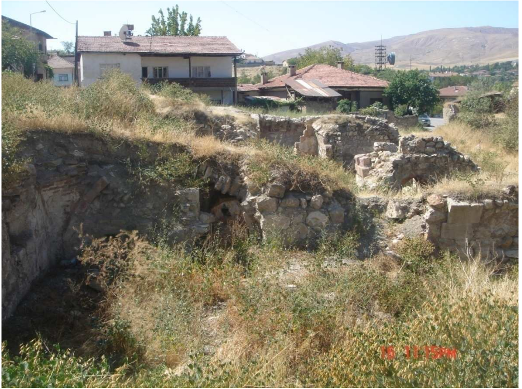
Fotoğraf 262: Behramşah Hamamı Kalıntıları
