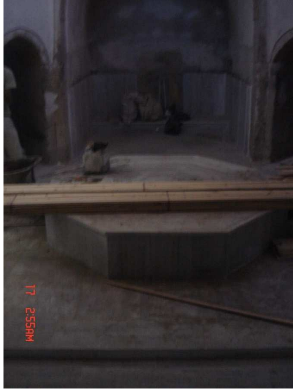
Fotoğraf 258: Aşağı Hamam Sıcaklık Bölümü
