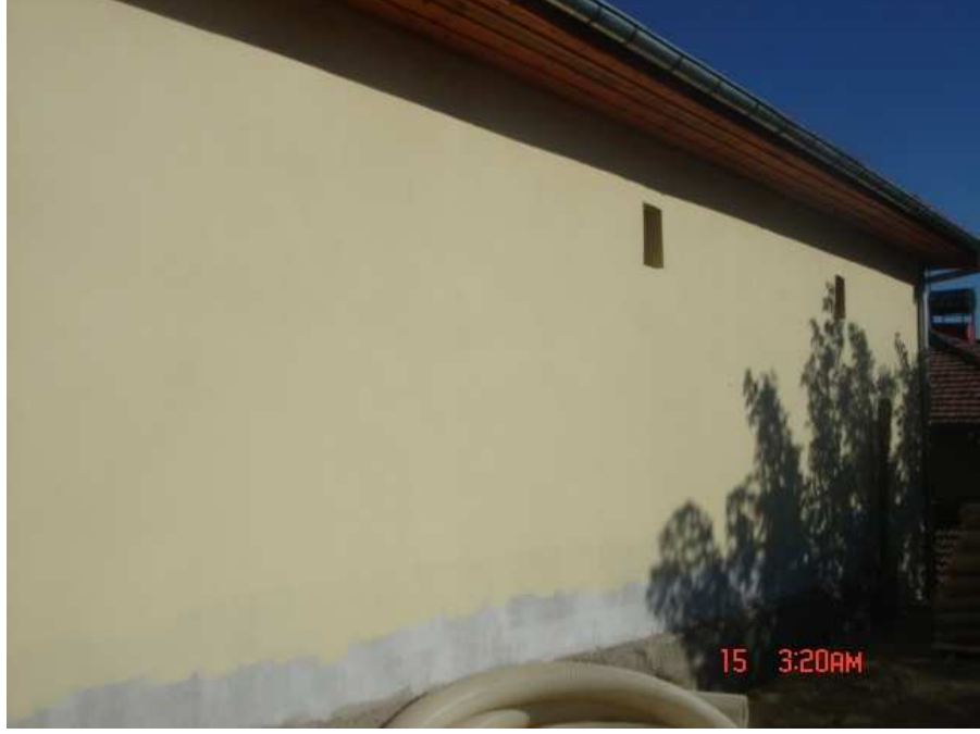
Fotoğraf 137: Süleyman Ağa Camii Güney Cephe
