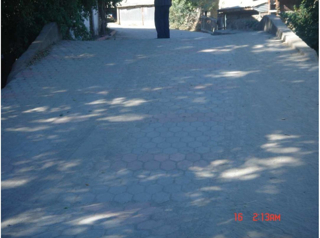
Fotoğraf 272:Kara Yusuf Mahallesi Köprüsü
