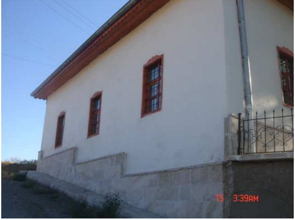
Fotoğraf 71: Güllübağ Camii Batı Cephe
