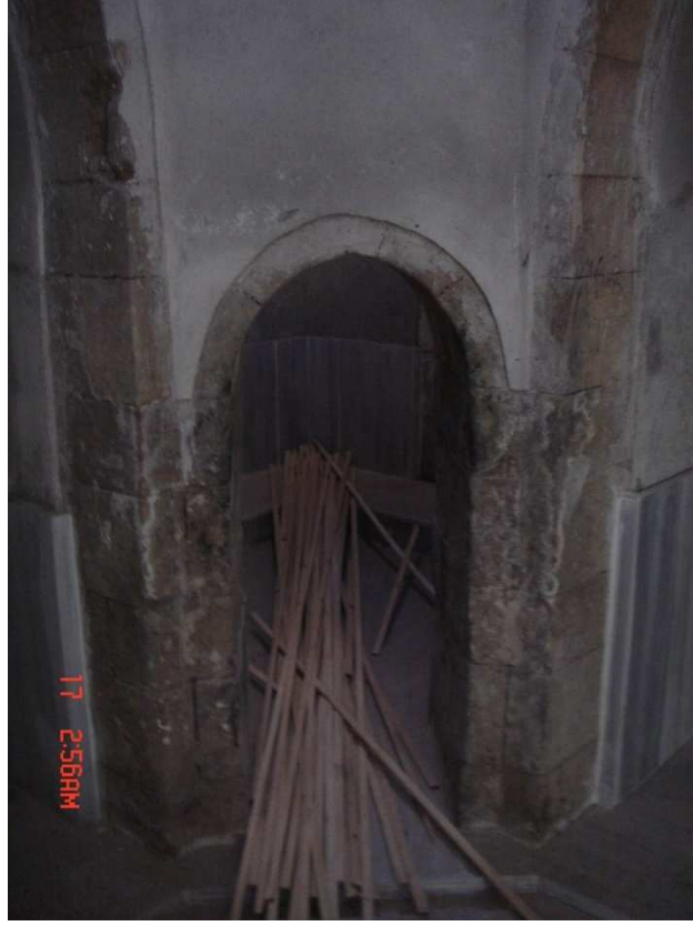
Fotoğraf 259: Aşağı Hamam Sıcaklık Bölümü
