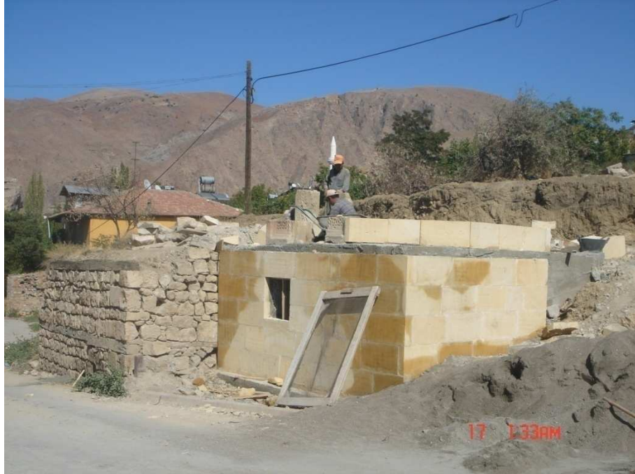
Fotoğraf 190: Arap Baba ( Araplık ) Türbesi Onarım Çalışmaları
