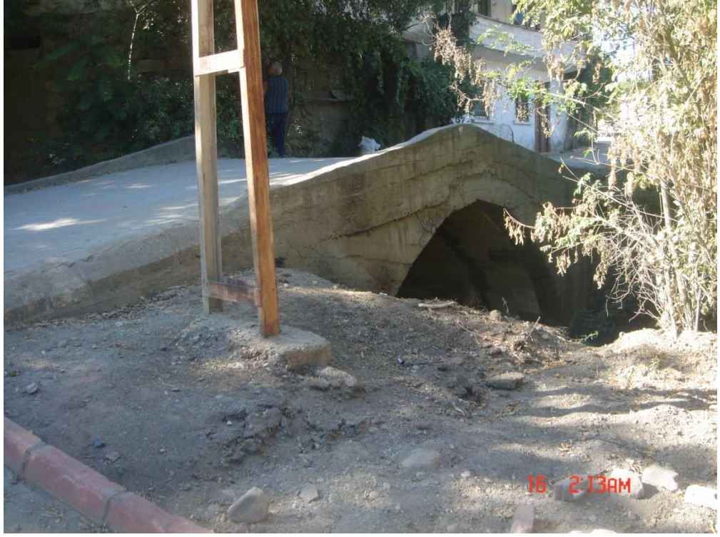
Fotoğraf 269:Kara Yusuf Mahallesi Köprüsü
