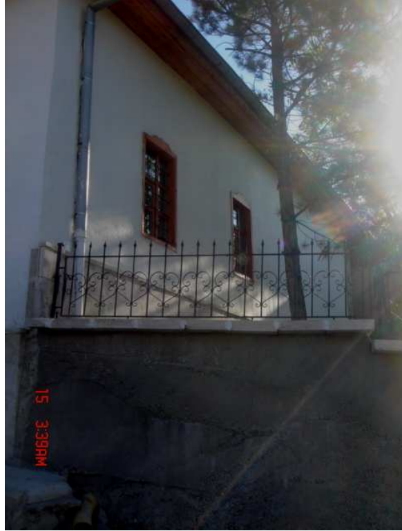
Fotoğraf 72: Güllübağ Camii Güney Cephe
