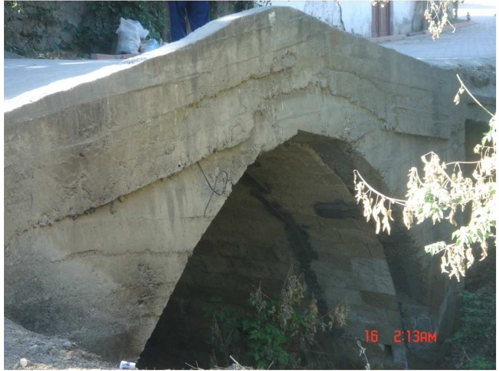
Fotoğraf 270:Kara Yusuf Mahallesi Köprüsü
