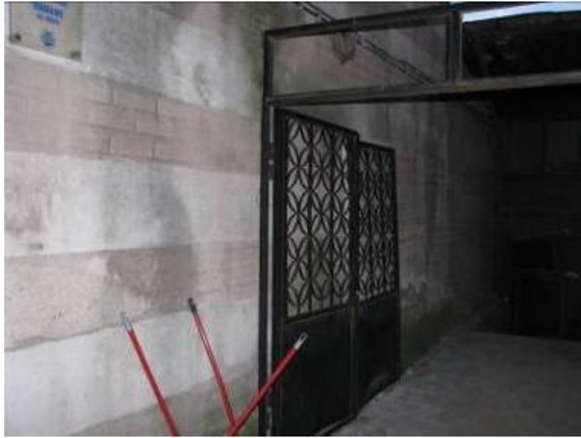
Fotoğraf 3.15-2: Tahtakale Hamamı batı cephesi.
