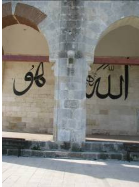
Fotoğraf 3.7-8: Muradiye Camii kuzey cephesi.
