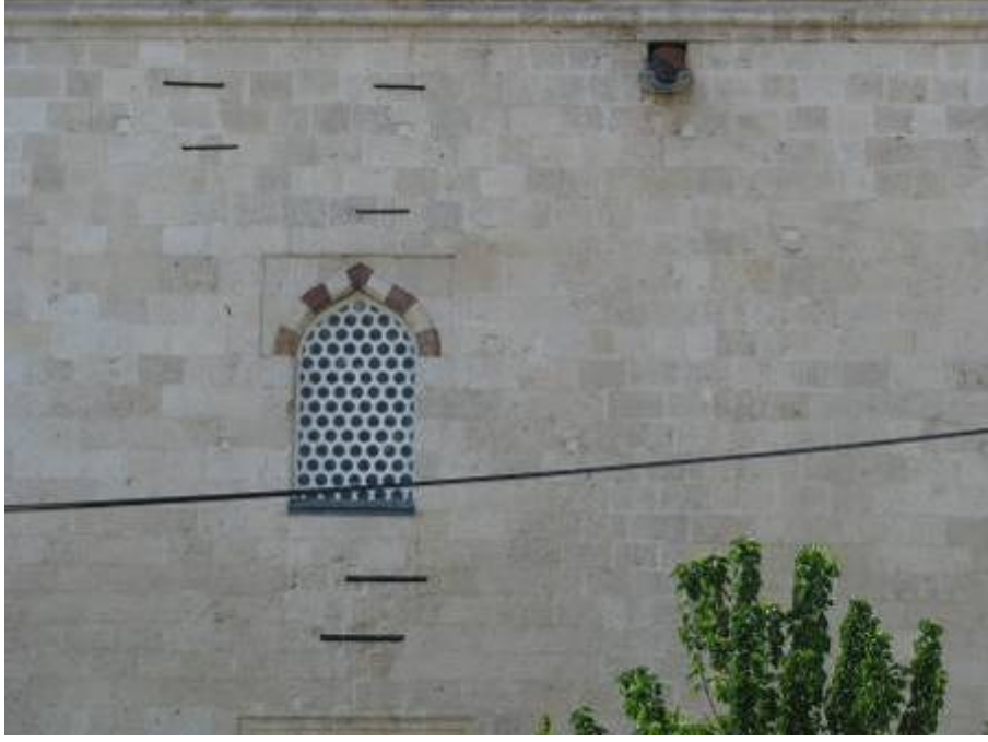
Fotoğraf 3.2-7: Eski Cami güney cephesi.
