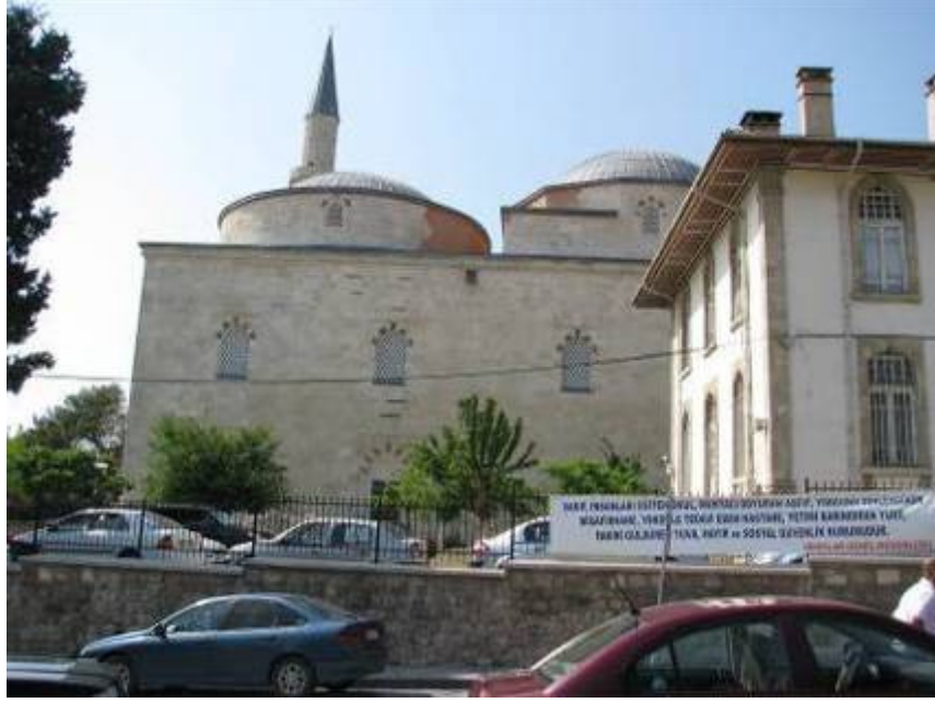
Fotoğraf 3.2-5: Eski Cami güney cephesi.
