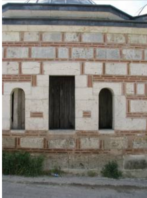
Fotoğraf 3.16-7: Saatli Medrese kuzey cephesi.
