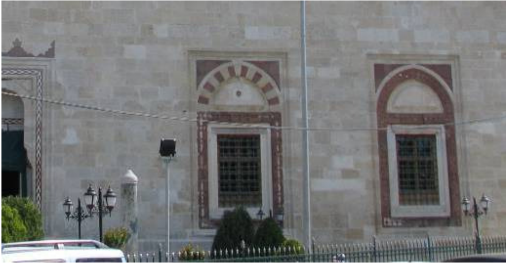
Fotoğraf 3.11-2: Üç Şerefeli Cami batı yönü harim cephesi pencereler.
