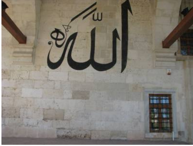
Fotoğraf 3.7-9: Muradiye Camii kuzey cephesi.
