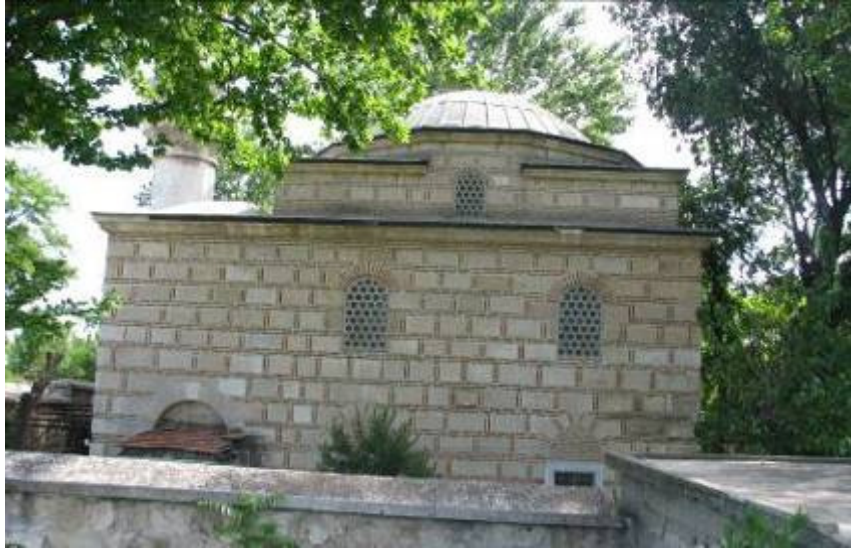
Fotoğraf 3.5-1: Şah Melek Camii batı cephesi.
