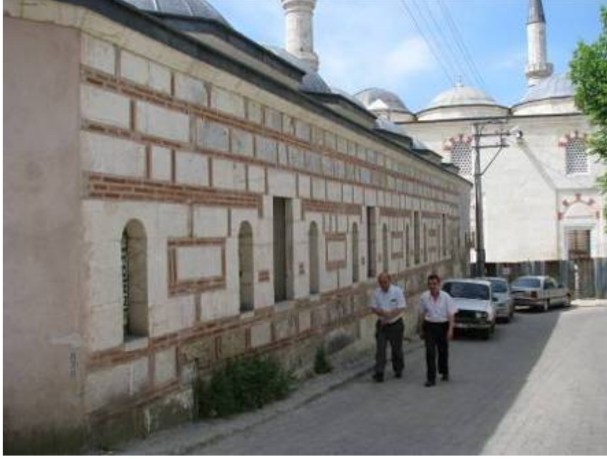
Fotoğraf 3.16-6: Saatli Medrese kuzey cephesi.
