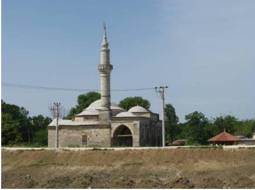
Fotoğraf 3.4-3: Gazi Mihal Camii doğu cephesi.
