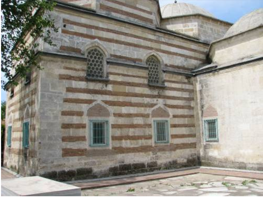
Fotoğraf 3.10-7: Yeşilce (Mezit Bey) Camii güney cephesi.
