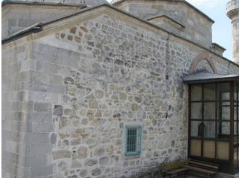
Fotoğraf 3.10-10: Yeşilce (Mezit Bey) Camii kuzey cephesi.
