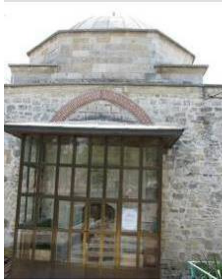
Fotoğraf 3.10-11: Yeşilce (Mezit Bey) Camii kuzey cephesi.
