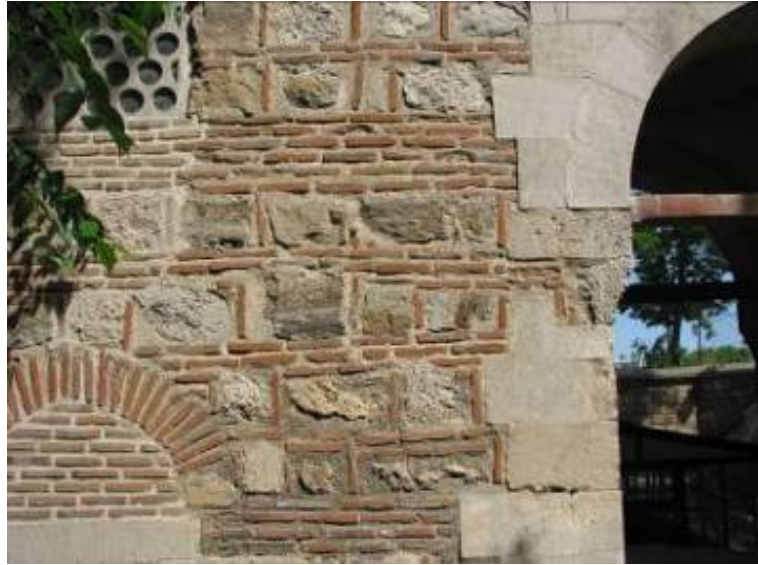
Fotoğraf 3.5-6: Şah Melek Camii güney cephesi.
