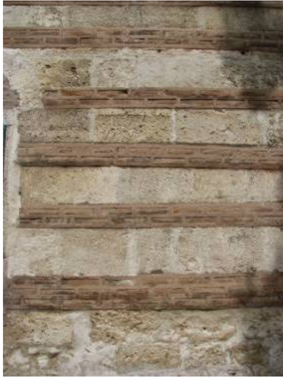
Fotoğraf 3.10-9: Yeşilce (Mezit Bey) Camii güney cephesi.
