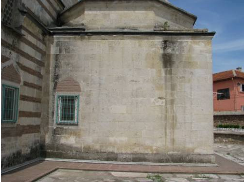
Fotoğraf 3.10-5: Yeşilce (Mezit Bey) Camii dođu cephesi.
