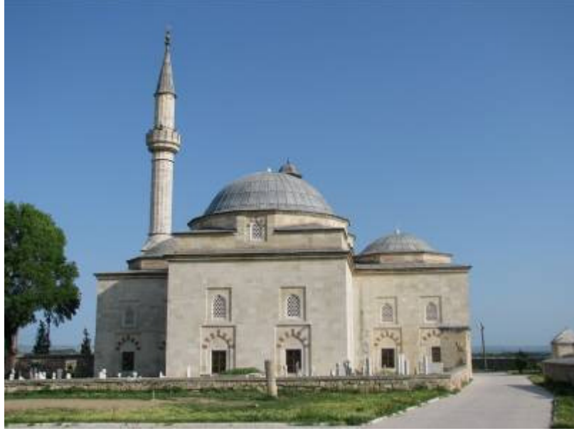
Fotoğraf 3.7-5: Muradiye Camii güney cephesi.
