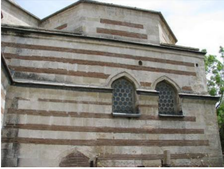
Fotoğraf 3.10-2: Yeşilce (Mezit Bey) Camii batı cephesi.
