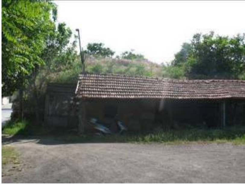
Fotoğraf 3.13-2: Beylerbeyi Hamamı kuzey cephesi.
