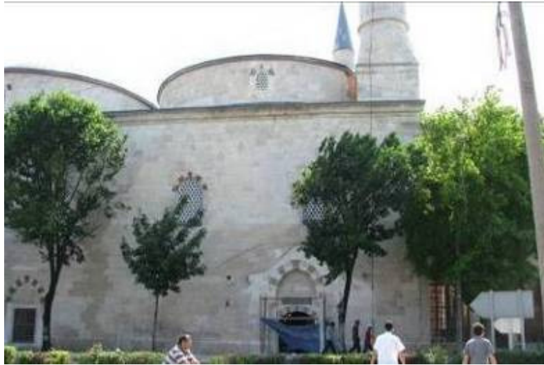
Fotoğraf 3.2-4: Eski Cami dođu cephesi.
