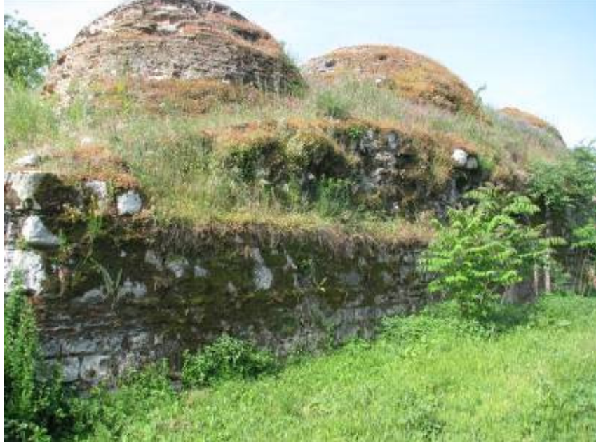
Fotoğraf 3.14-5: Gazi Mihal Hamamı kuzey cephesi.
