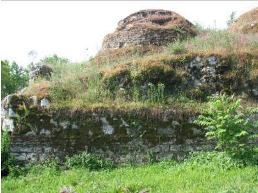
Fotoğraf 3.14-6: Gazi Mihal Hamamı kuzey cephesi.
