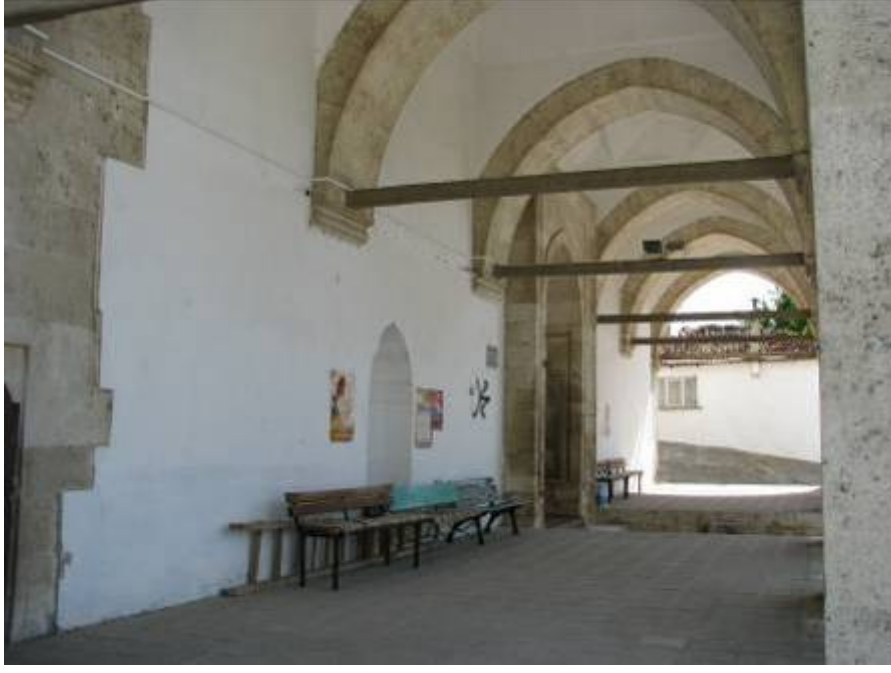
Fotoğraf 3.3-9: Beylerbeyi Cami kuzey cephesi.
