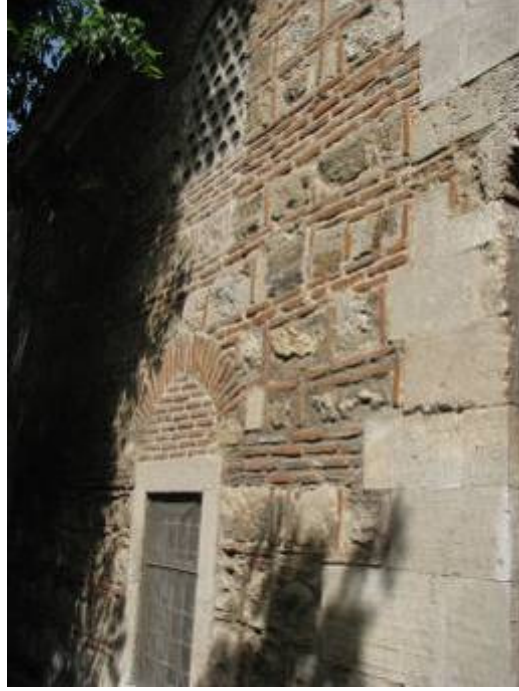
Fotoğraf 3.5-5: Şah Melek Camii güney cephesi.
