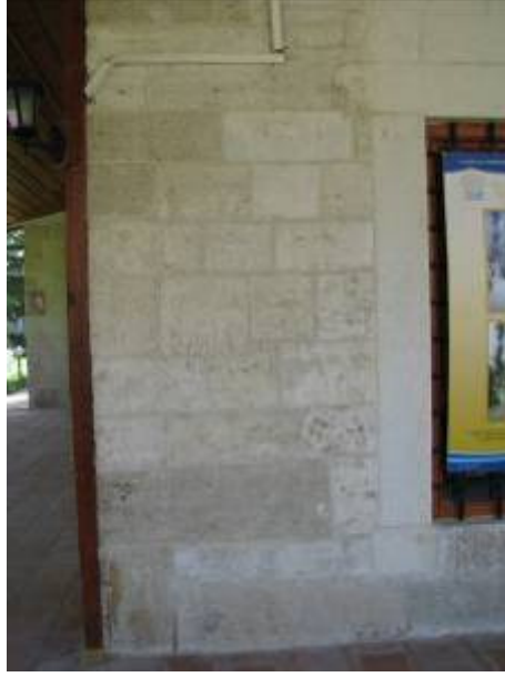
Fotoğraf 3.6-9: Darül Hadis Camii kuzey cephesi.
