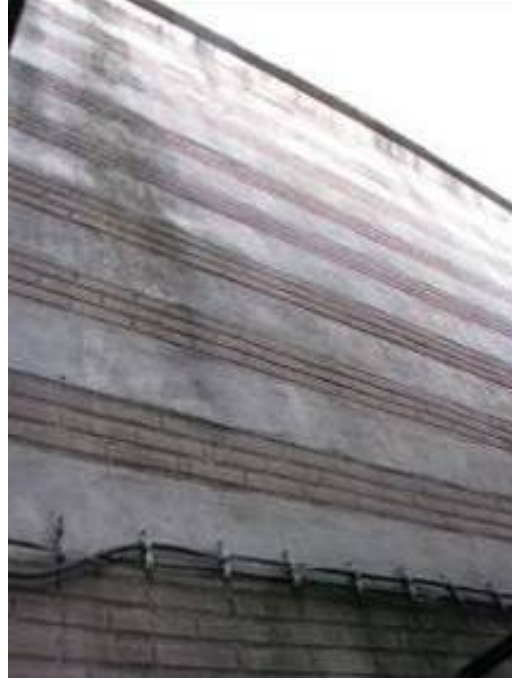
Fotoğraf 3.15-1: Tahtakale Hamamı batı cephesi.
