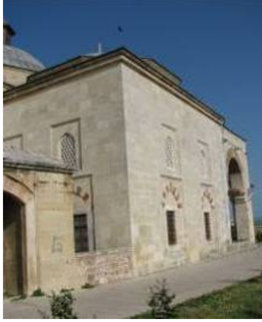
Fotoğraf 3.7-1: Muradiye Camii batı cephesi.
