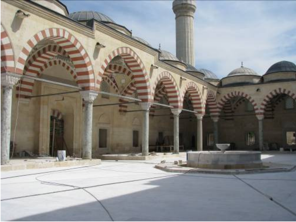
Fotoğraf 3.11-14: Üç Şerefeli Cami avludan kuzey doğu minaresinin görünüşü.
