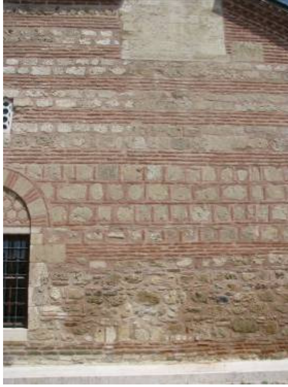
Fotoğraf 3.1-7: Yıldırım Camii güney cephesi
