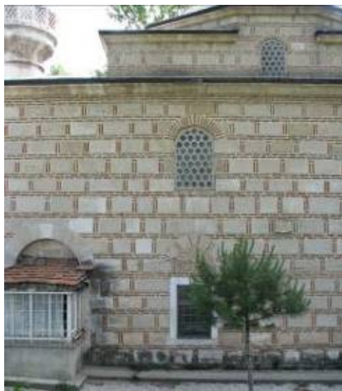
Fotoğraf 3.5-2: Şah Melek Camii batı cephesi.
