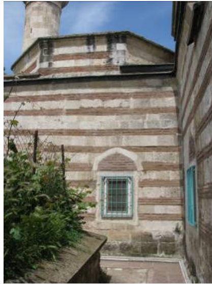
Fotoğraf 3.10-1: Yeşilce (Mezit Bey) Camii batı cephesi.
