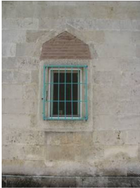
Fotoğraf 3.10-6: Yeşilce (Mezit Bey) Camii dođu cephesi.
