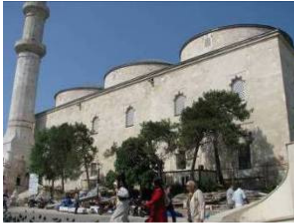
Fotoğraf 3.2-1: Eski Cami batı cephesi.
