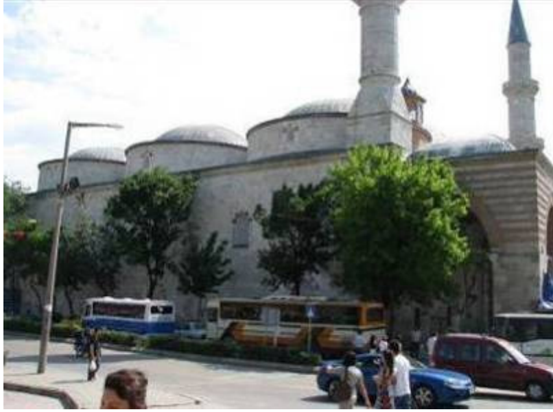
Fotoğraf 3.2-3: Eski Cami dođu cephesi.
