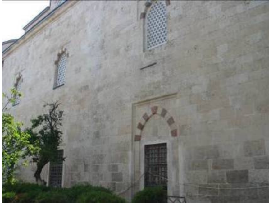
Fotoğraf 3.2-6: Eski Cami güney cephesi.
