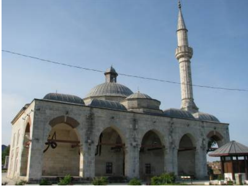
Fotoğraf 3.7-7: Muradiye Camii kuzey cephesi.
