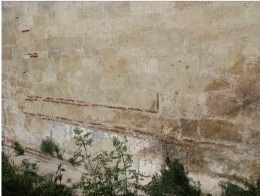
Fotoğraf 3.8-2: Kirazlı (Şihabüddin Paşa) Mescidi batı cephesi.
