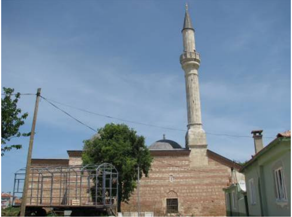
Fotoğraf 3.1-6: Yıldırım Camii güney cephesi.
