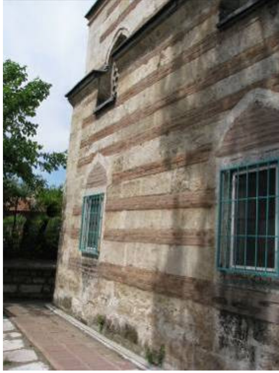
Fotoğraf 3.10-8: Yeşilce (Mezit Bey) Camii güney cephesi.
