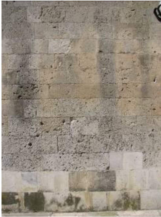
Fotoğraf 3.4-4: Gazi Mihal Camii doğu cephesi.
