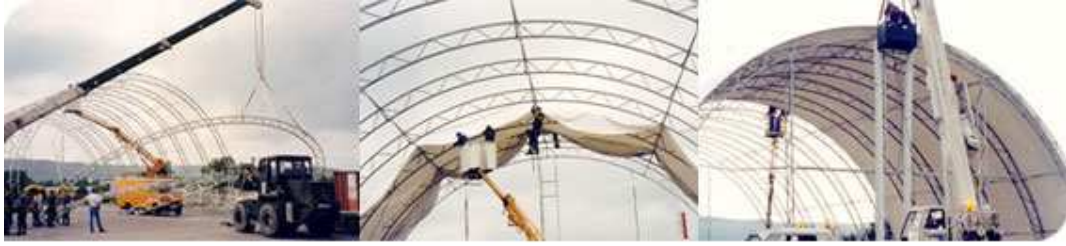
Şekil 2.9. Portatif sığınak imalat aşamaları.
