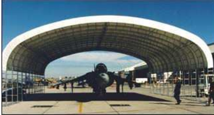
Şekil 2.1. Tipik bir portatif uçak sığınağı.
