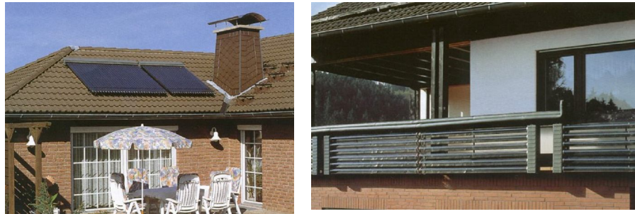
Resim 4.3. Çatı yüzeyinde ve balkon korkuluklarında yer alan vakumlu güneş toplacıları ( www.viessman.com.tr )
