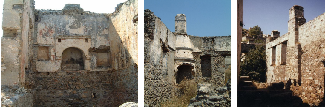
Resim 6.9. Bacaların mekân içindeki ve cephe yüzeyindeki konumu
