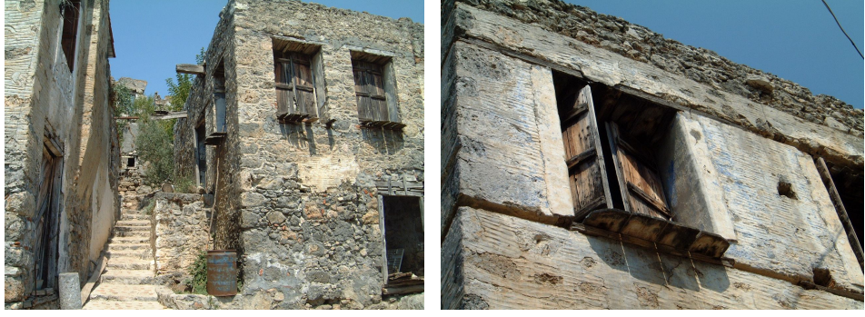
Resim 6.6. Güneş ve rüzgar kontrolü için kepenk kullanımı
