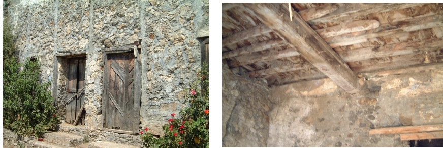
Resim 6.10. Konutların taşıyıcı strüktürü ve çerçeve elemanlar
