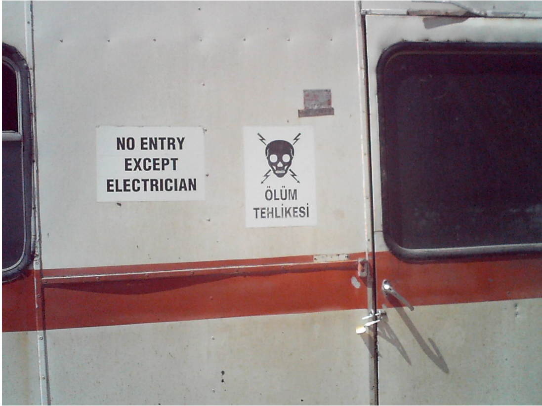
Şekil 3.5. Elektrik Barakasından Bir Görüntü
