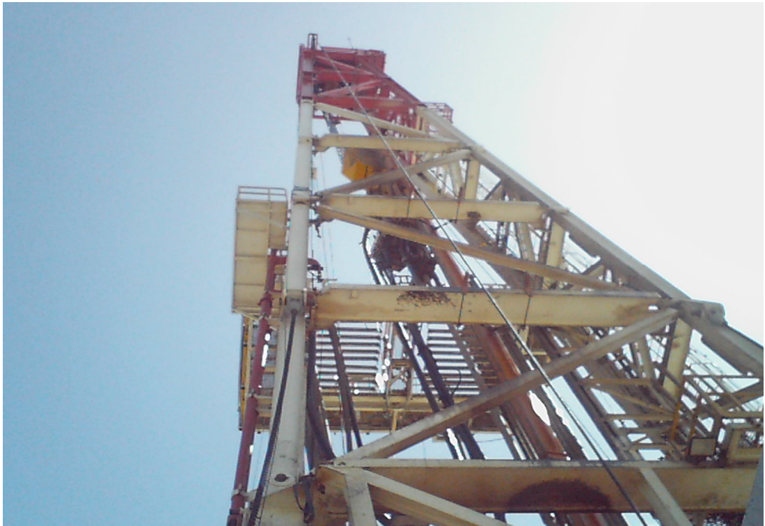
Şekil 3.8. Sondaj Kulesinden Bir Görüntü
