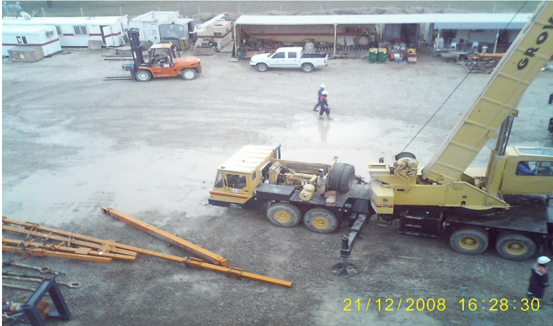
Şekil 3.16. Sondaj Platformundan Lokasyon İçi Bir Görüntü
