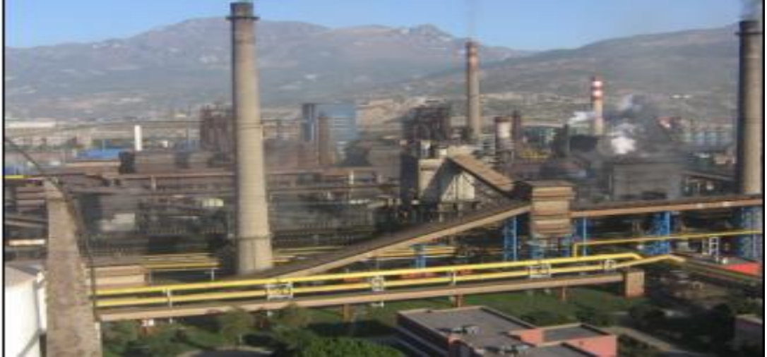
Şekil 2.2. Batarya üzerine kömür nakli
