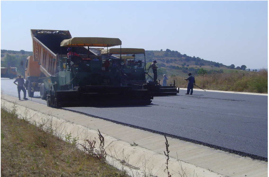
Fotoğraf 2.5 Km 106+00 kesiminde binder tabakasının serilmesi ve sıkıştırılması
