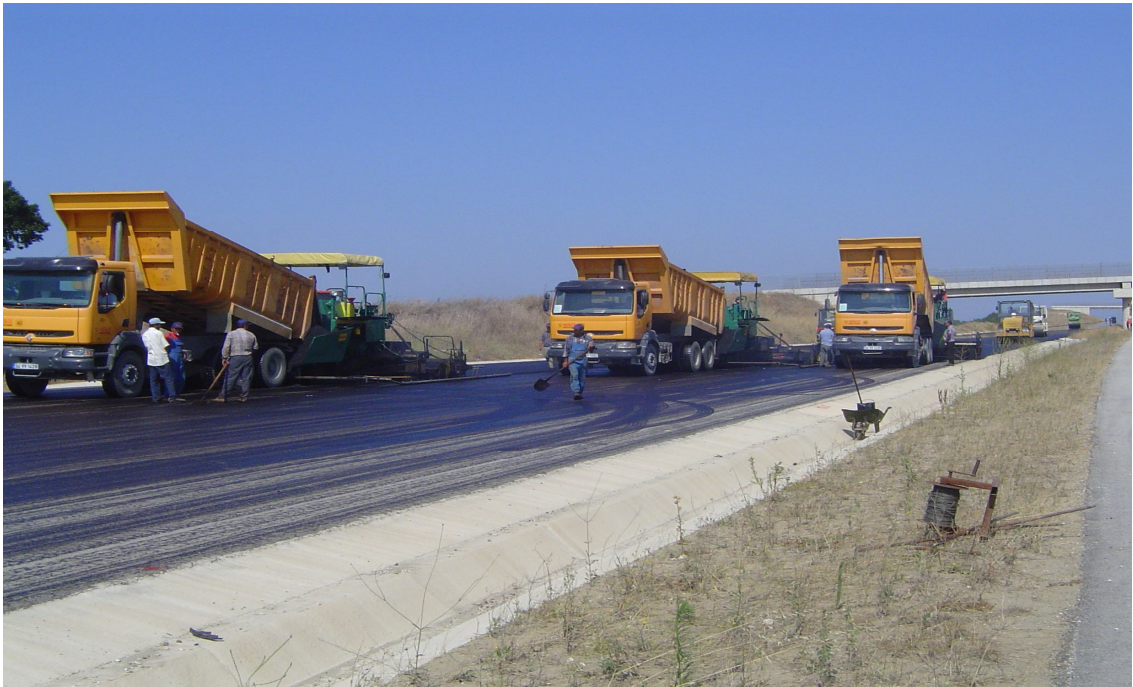
Fotoğraf 2.6 Km 104+050 kesiminde aşınma tabakasının yapımı
