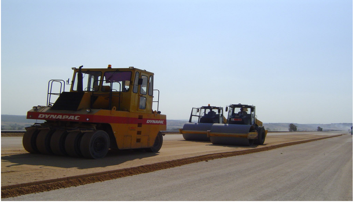
Fotoğraf 2.3 Km 106+00 Mekanik tabakanın serilme aşamasından bir görünüm
