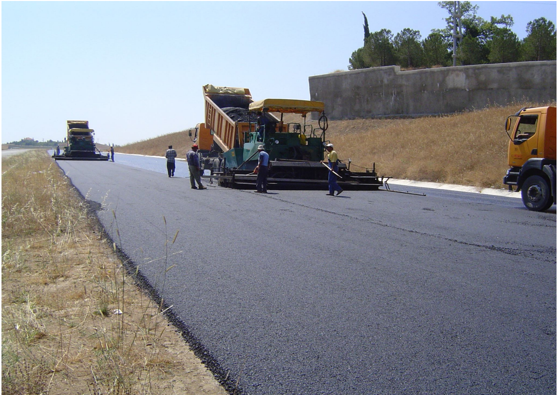
Fotoğraf 2.4 Km 105+070 kesiminde bitümlü temel tabakasının serilmesi ve sıkıştırması işlemlerinin görünümü
