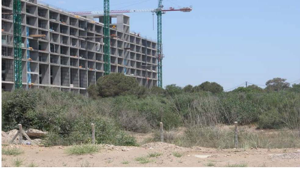
Resim 2: Belek Turizm Merkezinde Turizm Tesisi İnşaatından Görünüm
