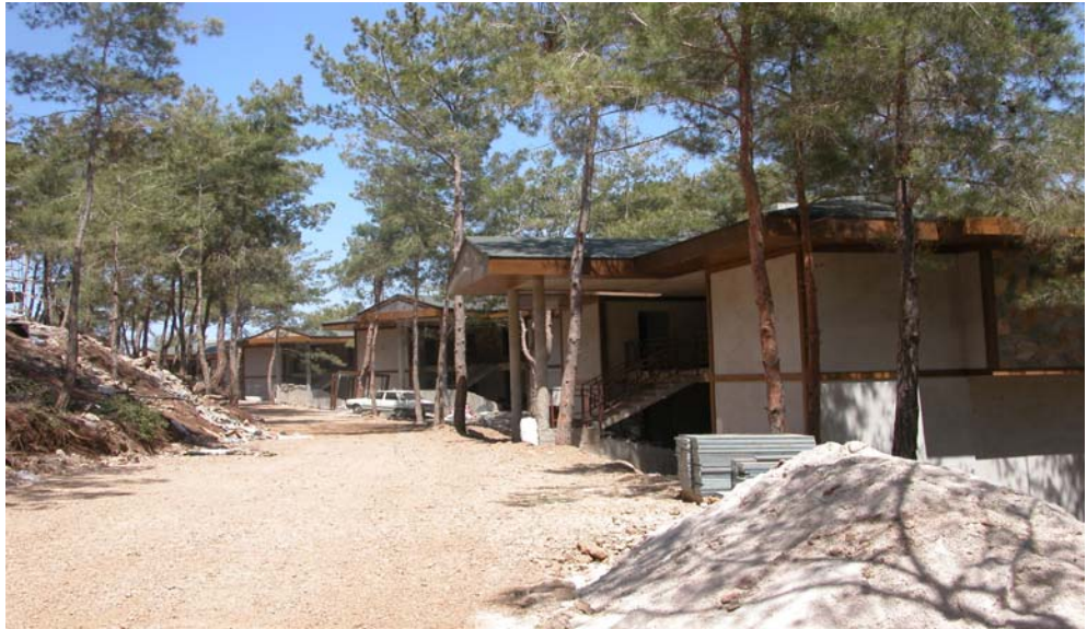
Resim 7: Alanya da OK kapsamında verilen Bir Alanda Turizm Tesis İnşaatından Görünüm
