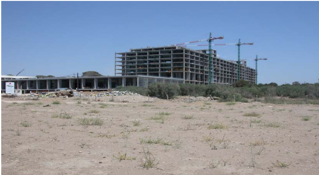
Resim 3: Belek Turizm Merkezinde Turizm Tesisi İnşaatından Görünüm
