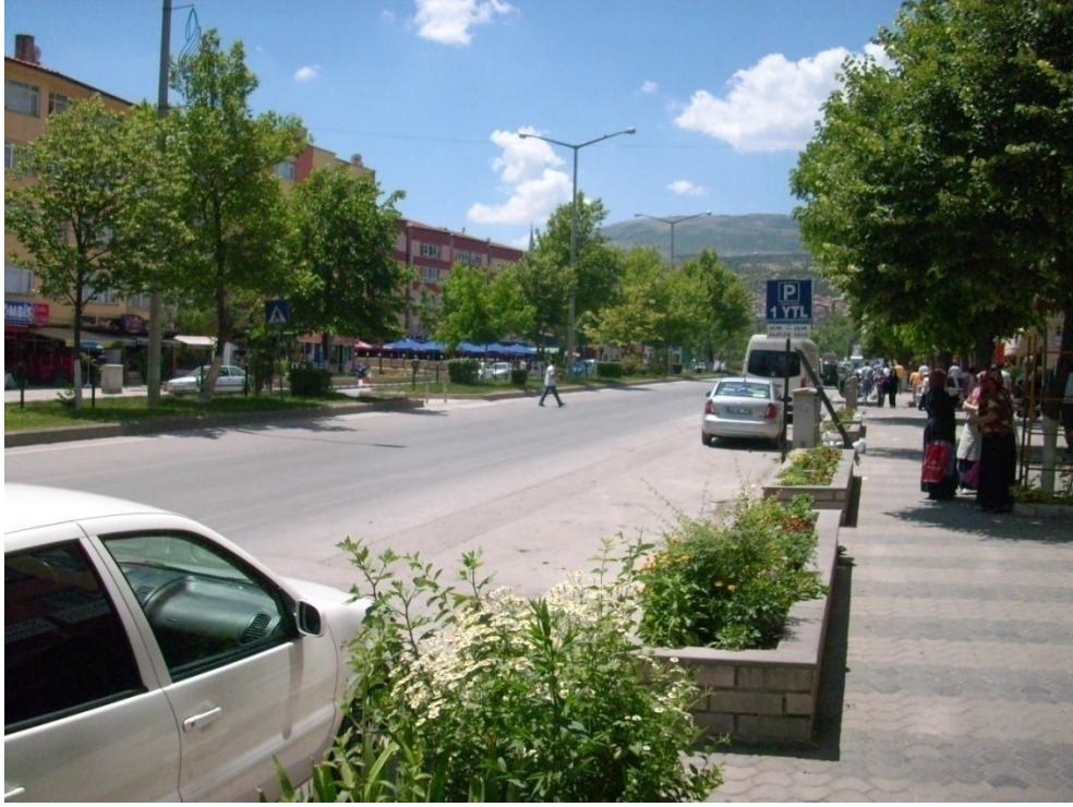
Şekil 4.15. Uygulama yapılan yoldaki yaya geçitleri
