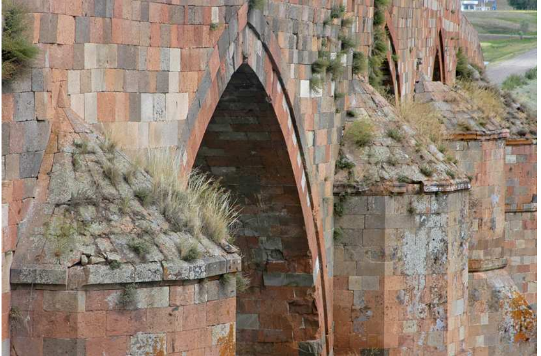
Resim-171: Erzurum Çobandede Köprüsü, Batı Cephesi, 2008
