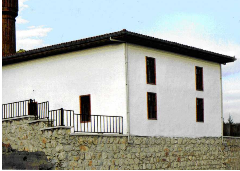
Resim-59: Amasya, Merzifon, Buğdaylı Cami; Restorasyonu tamamlanan yapının son hali, 2005
