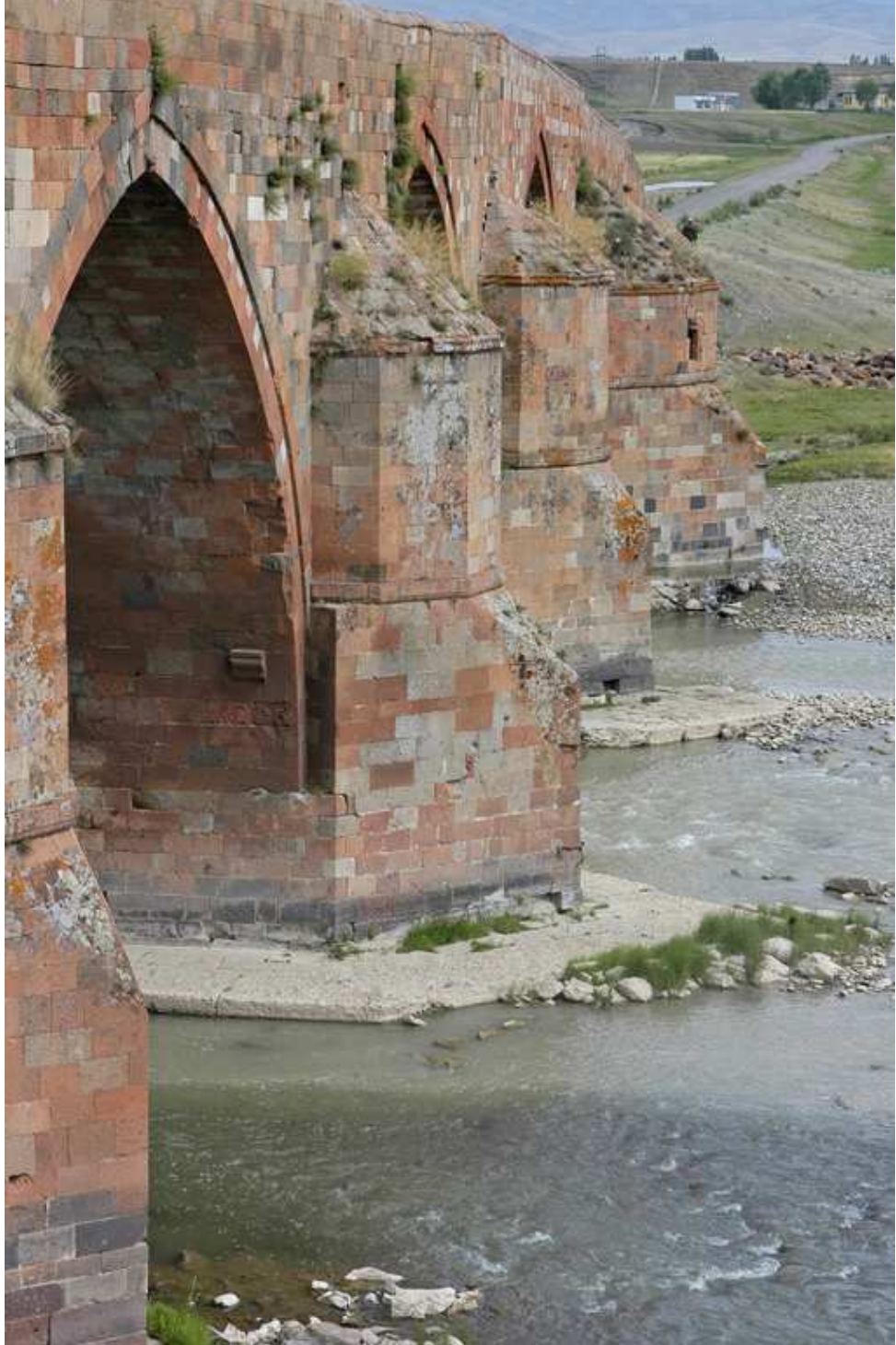
Resim-153: Erzurum Çobandede Köprüsü, Batı Cephesi, 2008
