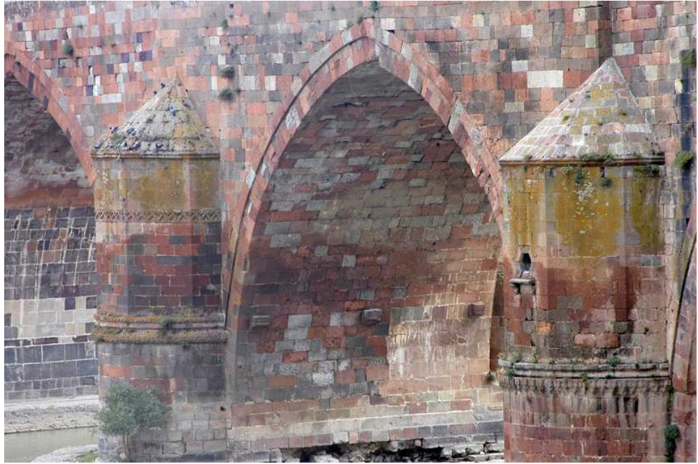
Resim-157: Erzurum Çobandede Köprüsü, Doğu Cephesi, Köprü Ayakları ve Kemerleri, 2008
