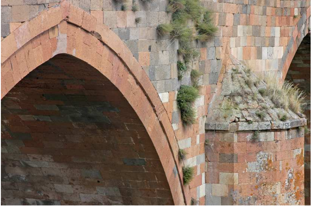
Resim-173: Erzurum Çobandede Köprüsü, Batı Cephesi, 2008
