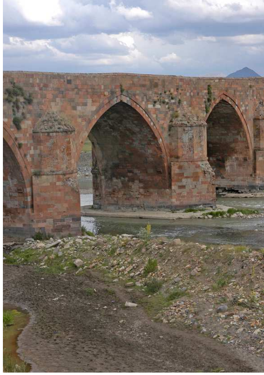
Resim-162: Erzurum Çobandede Köprüsü, Batı Cephesi, Su Geçiş Gözleri, 2008
