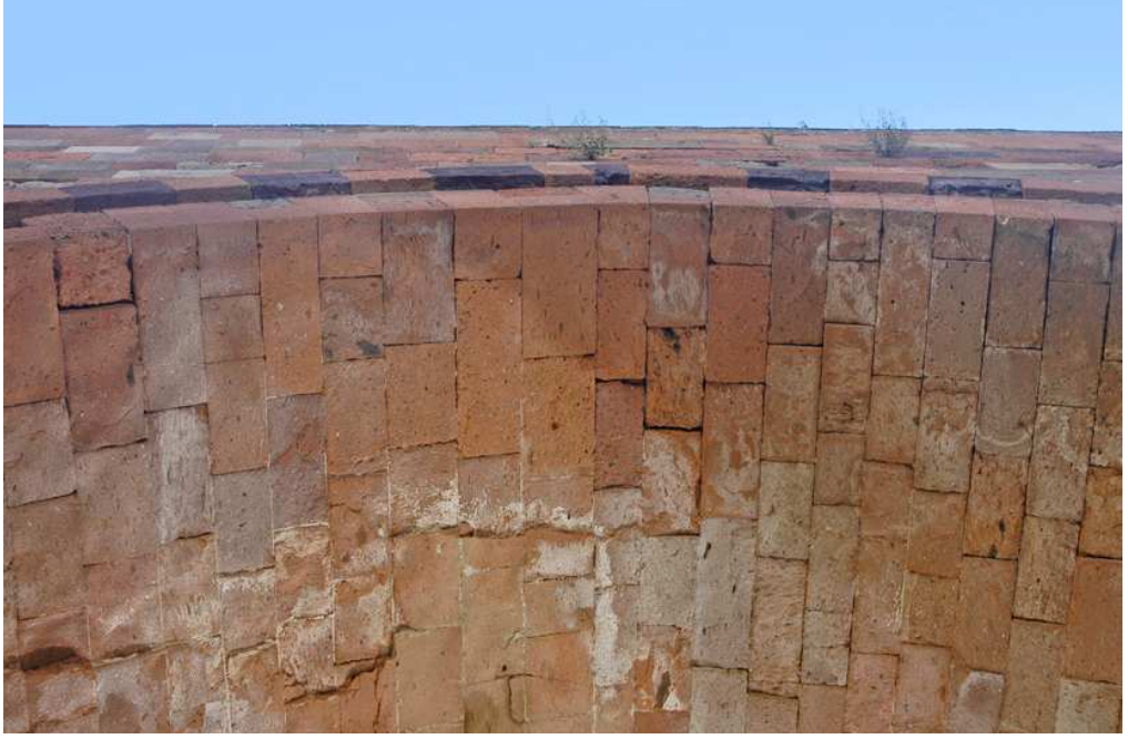
Resim-170: Erzurum Çobandede Köprüsü, Batı Cephesi Kemer, 2008
