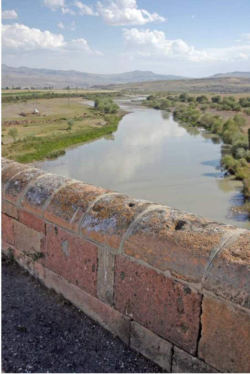
Resim-175: Erzurum Çobandede Köprüsü, Köprü üzeri, 2008
