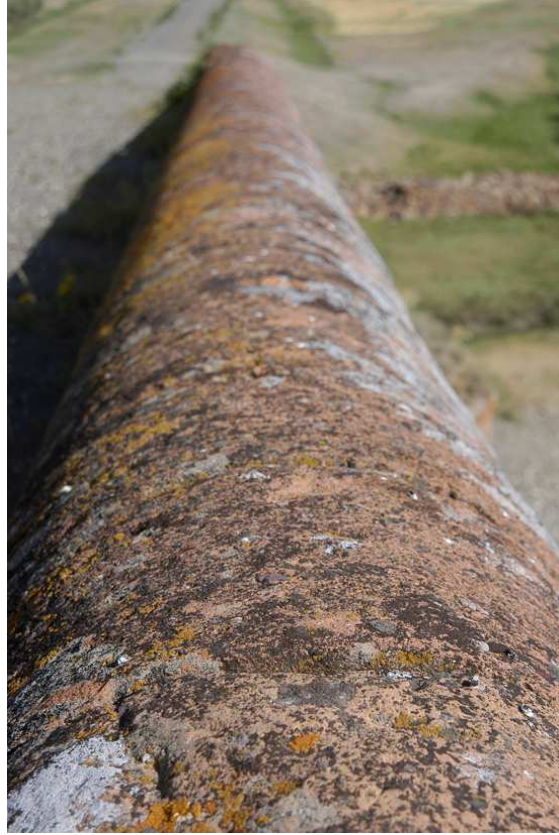
Resim-177: Erzurum Çobandede Köprüsü, Köprü Üzeri Yol Korkuluğu, 2008
