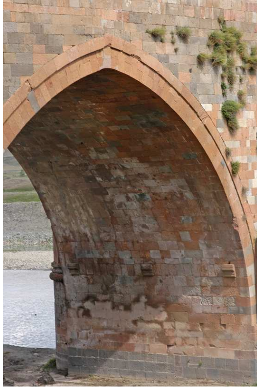
Resim-161: Erzurum Çobandede Köprüsü, Batı Cephesi, Su Geçiş Gözü Kemerleri, 2008
