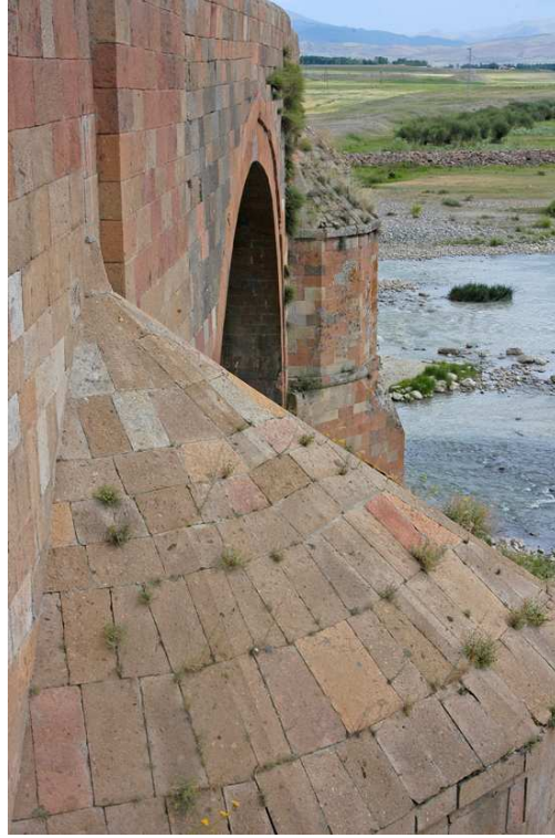
Resim-163: Erzurum Çobandede Köprüsü, Batı Cephesi, 2008
