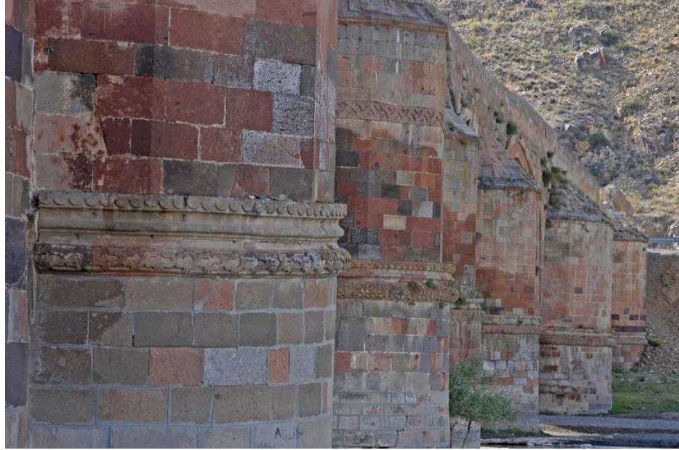
Resim-155: Erzurum Çobandede Köprüsü, Doğu Cephesi, Köprü Ayakları, 2008
