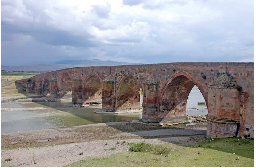
Resim-39: Çobandede Köprüsü, Köprüköy, Erzurum, 2008
