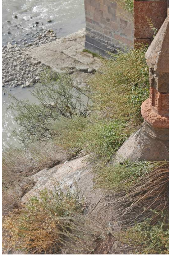
Resim-168: Erzurum Çobandede Köprüsü, Batı Cephesi, 2008
