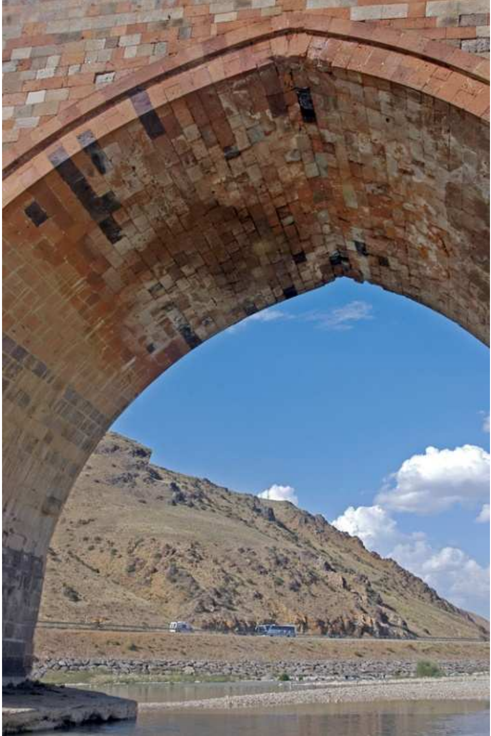
Resim-159: Erzurum Çobandede Köprüsü, Batı Cephesi, Su Geçiş Gözü Kemerli, 2008
