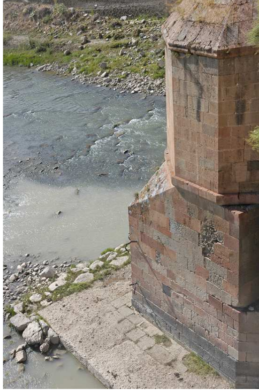
Resim-176: Erzurum Çobandede Köprüsü, Batı Cephesi, 2008
