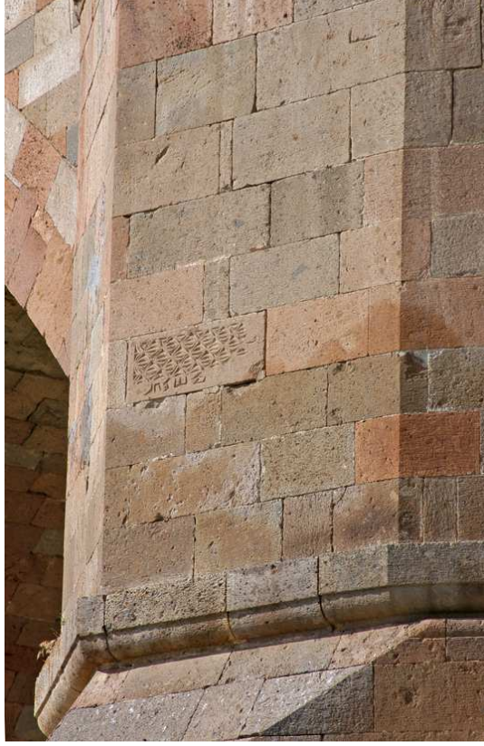
Resim-166: Erzurum Çobandede Köprüsü, Batı Cephesi, 2008
