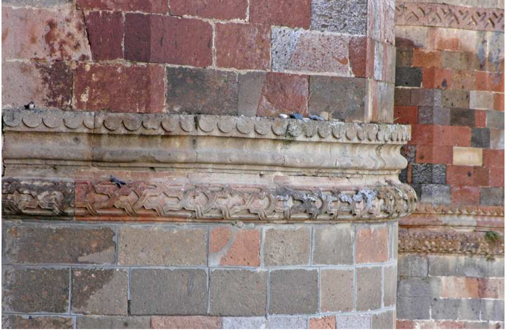
Resim-156: Erzurum Çobandede Köprüsü, Doğu Cephesi, Köprü Ayakları, 2008
