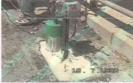
Şekil A.4. Karasu Viyadüğünde kontrol noktası tesisi çalışmaları
