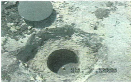
Şekil A.5. Karasu Viyadüğünde kontrol noktası tesisi çalışmaları
