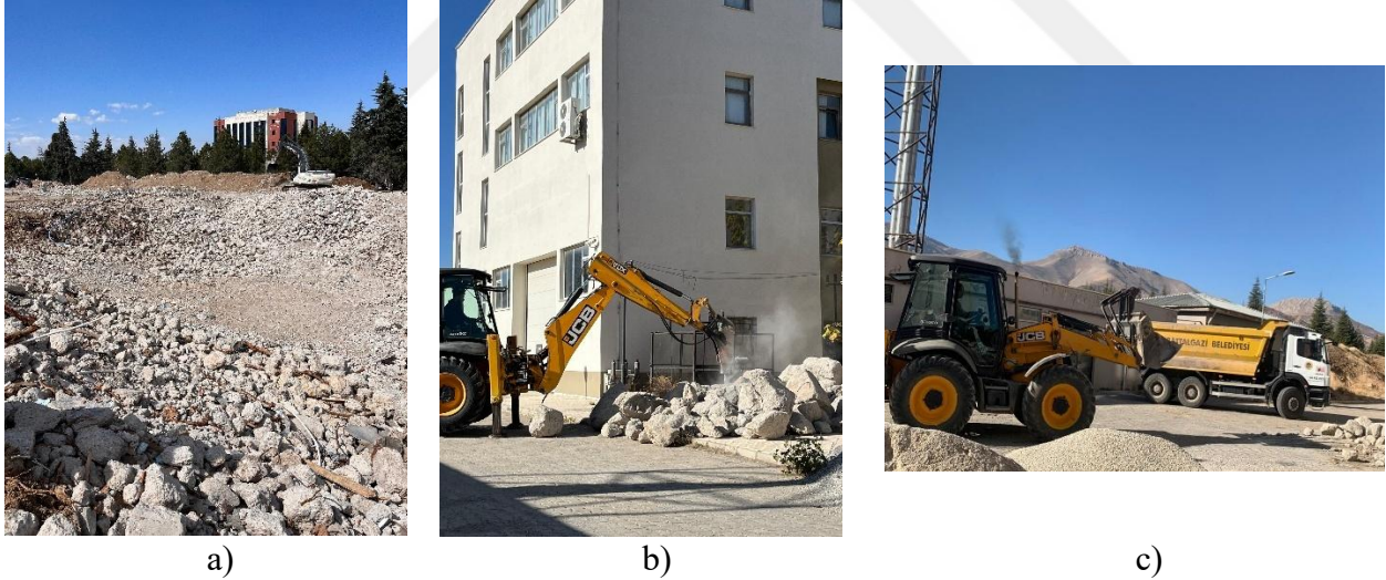
Şekil 3.2: a) İnşaat yıkıntı atıklarının alındığı yer, b) Beton blokların küçültülmesi, c) Küçültülen beton blokların konkasör şantiyesine taşınması
