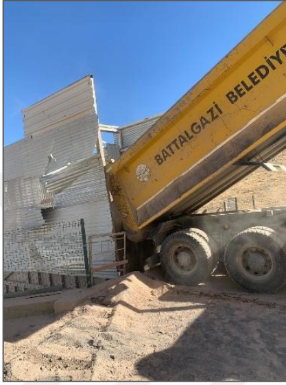
a) Yıkıntı atığı beton blokların konkasöre boşaltılması
