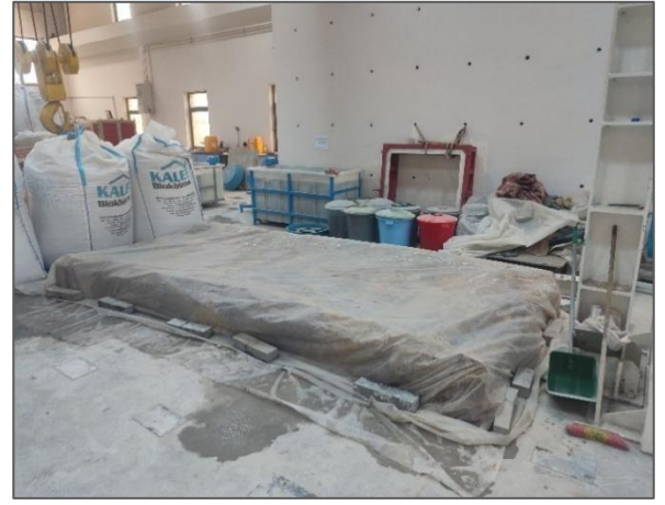
c) Betonarme kirişlerin kür işlemi
