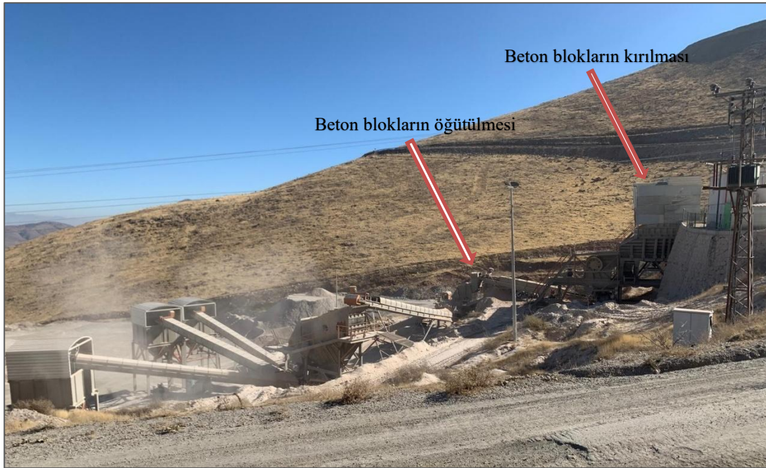
b) İnşaat yıkıntı atığının küçük parçalara ayrılması ve öğütülmesi
