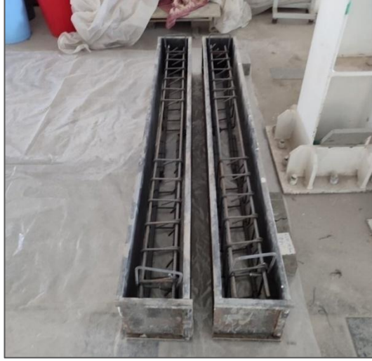
a) Donatıların kiriş kalıplara yerleştirilmesi
