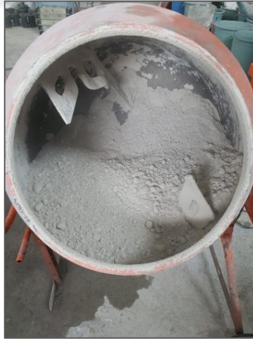
Şekil 3.7: Katı malzemelerin kuru halde karıştırılması
