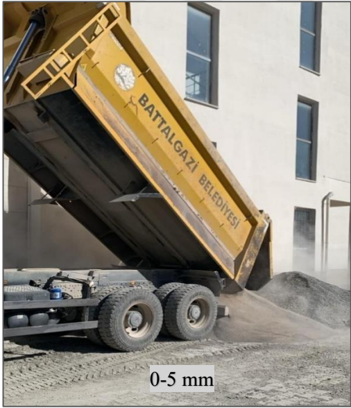
d) Geri dönüştürülmüş agreganın İnşaat Mühendisliği laboratuvarına getirilmesi
