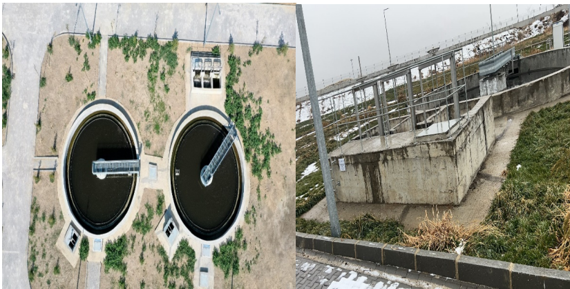
Şekil 3.5 Muradiye atıksu arıtma tesisi son çökeltme ve dağıtım yapısı
