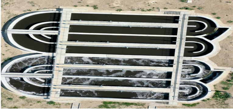
Şekil 3.4 Muradiye atıksu arıtma tesisi havalandırma havuzu ünitesi
