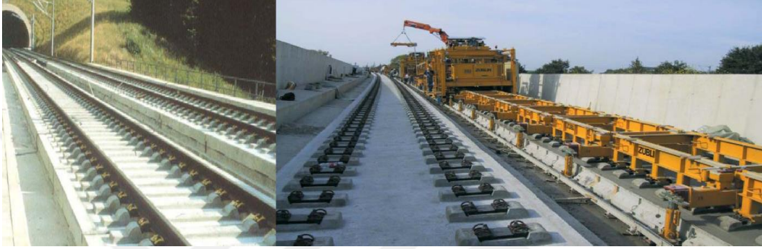
Görsel 25: Asfalt yataklı üst yapı(Polat,2011)
