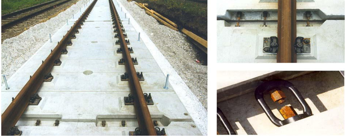
Görsel 26: J-Shinkansen prekast üst yapı (Polat,2011)
