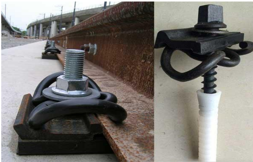
Görsel 19: Yay tipli elastik bağlantı (Rail-Fastener.com)
