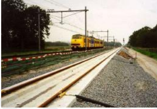
Görsel 29: Yüksek hızlı hatlar için ERC gömülü ray istemi(Polat,2011)
