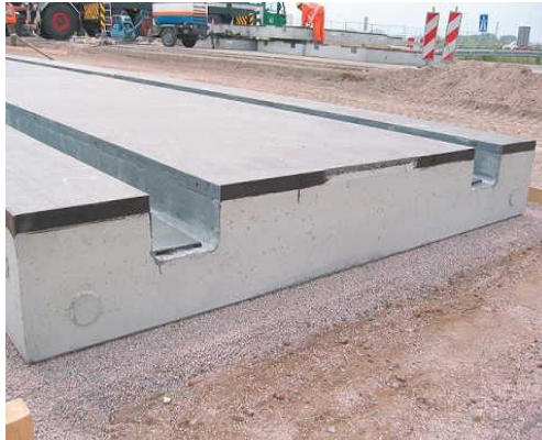
Görsel 30: Yüksek hızlı hatlar için ERC gömülü ray sistemi çim hat
