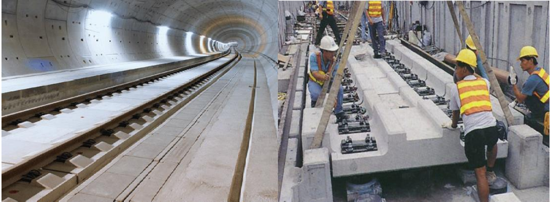
Görsel 28: Porr prekast üst yapı(Polat,2011)
