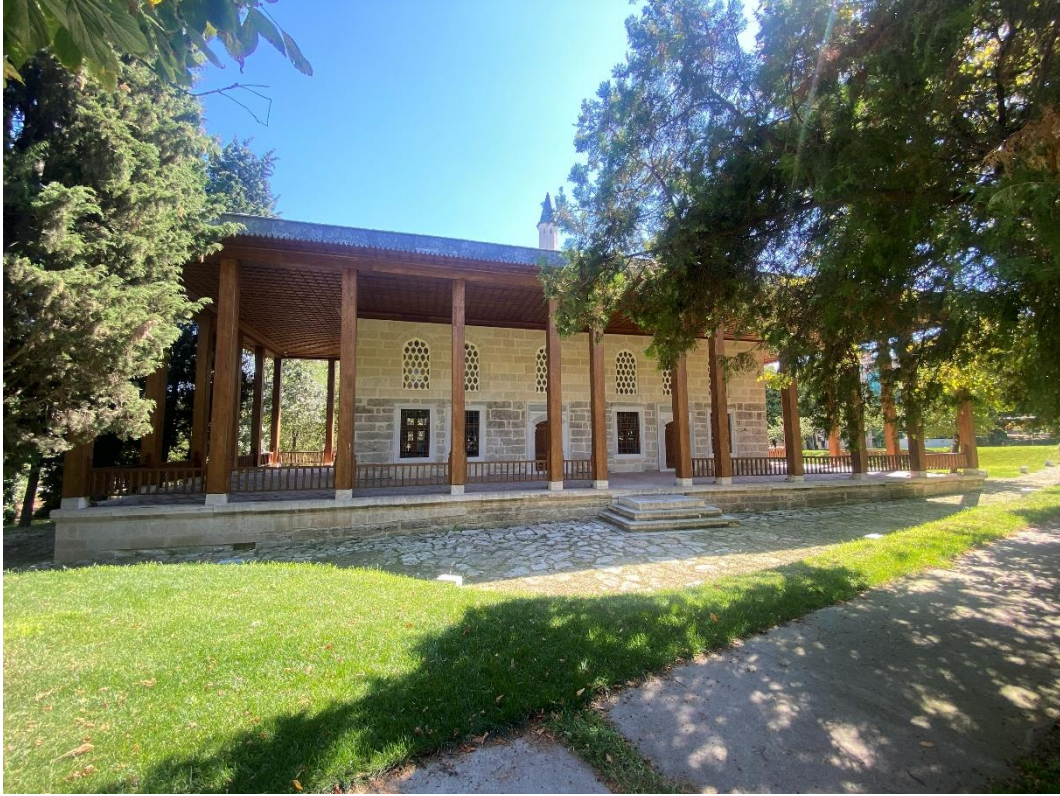
Şekil 2.2 Sancak Köşkü'nün Kuzey cepheden görünümü
