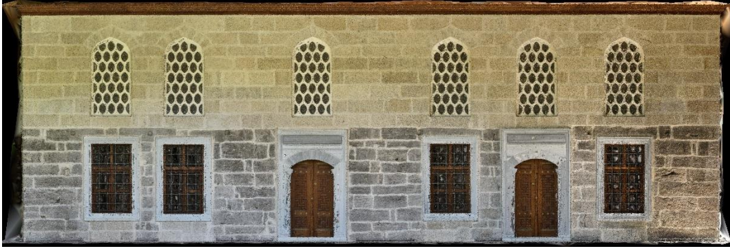
Şekil 4.3 İHA fotogrametri verisinden üretilen Kuzey cephesi görünüşü
