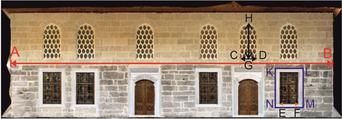
Kuzey Cephe Görünümü
