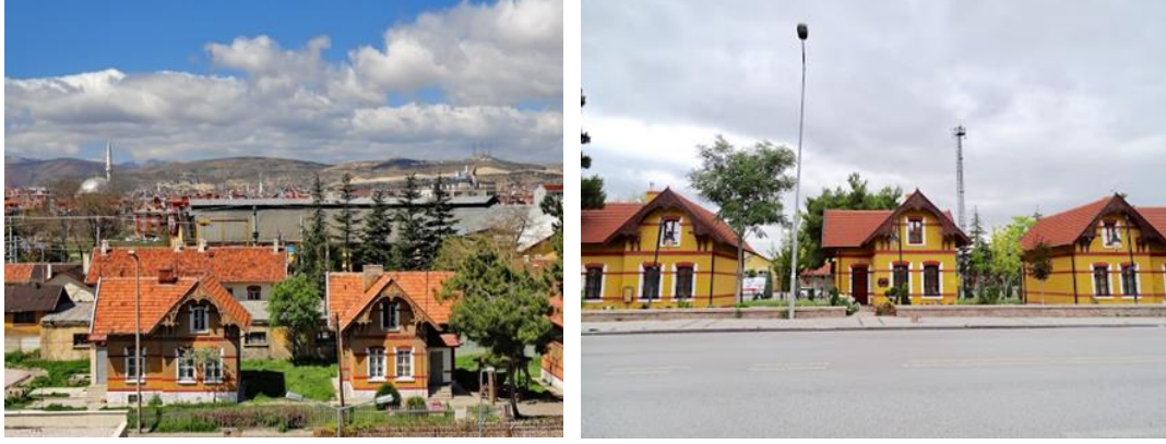
Şekil 3.4 Lojman Binaları Restorasyon Öncesi ve Sonrası ( Yazarın Arşivi )
