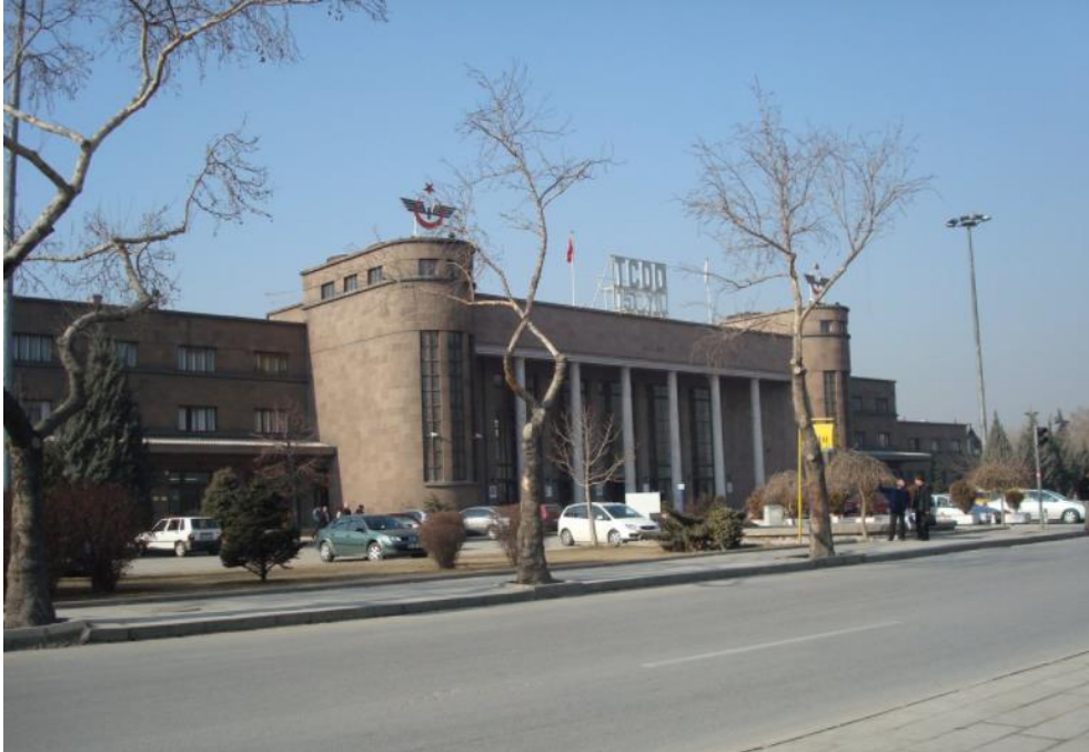
Şekil 2.14.Ankara Garı Binası ( http://www.gezmece.com/tren-istasyonlari-2/ )
