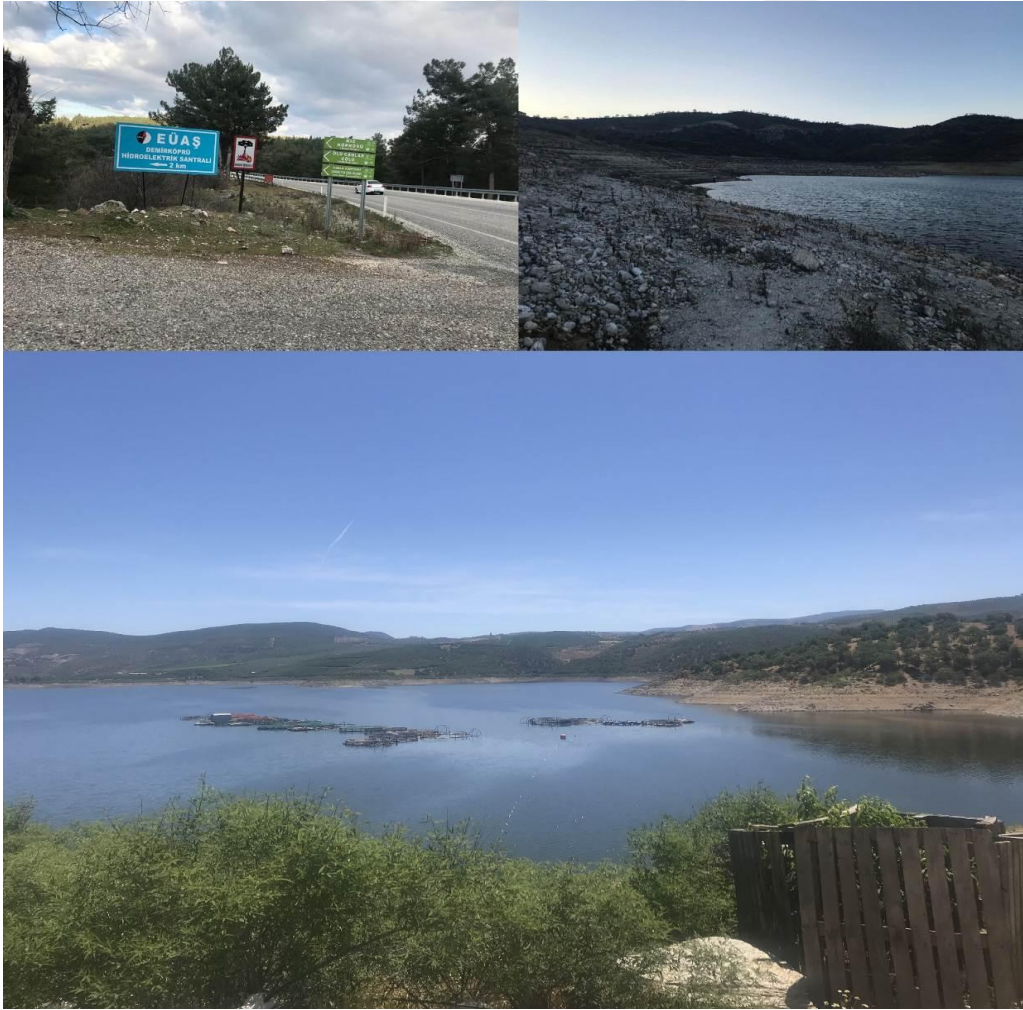
Şekil 2.1. Demirköprü Baraj Gölü
