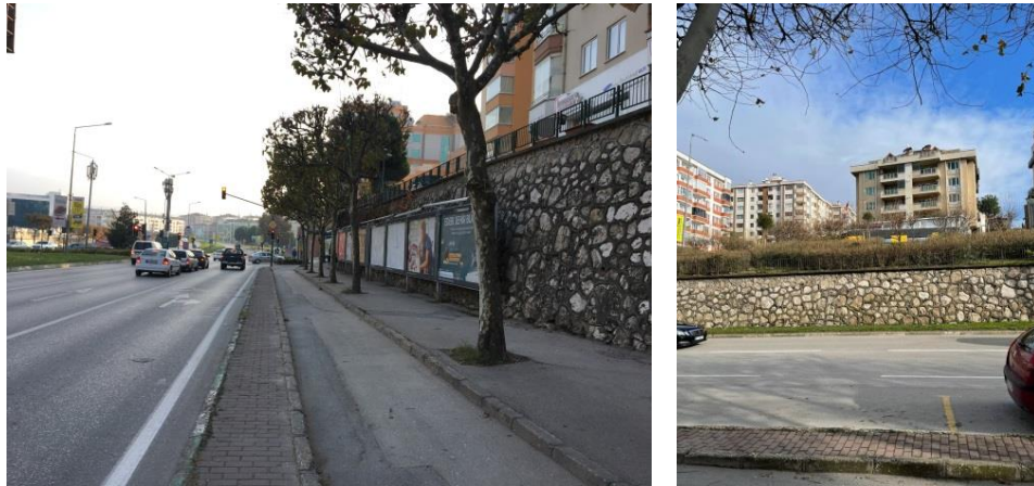
Şekil 5.24 : FSM Bulvarı A bölgesindeki kot farkı.
