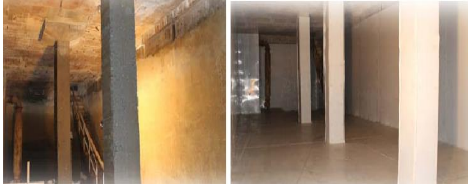
Şekil 2.22. Polipropilen malzeme ile su deposu yalıtım uygulaması
