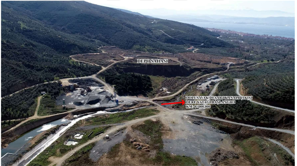
Ek Şekil 2. Büyükkumla Barajı depo sahası
