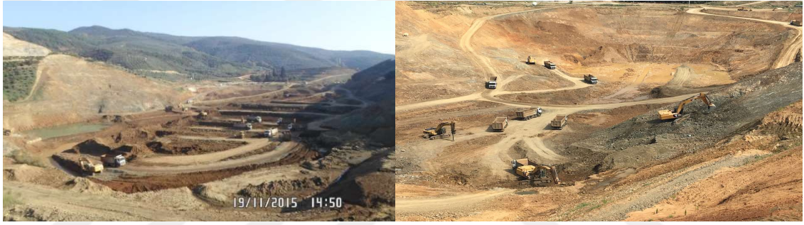
Şekil 3.8. Baraj gövdesi temel kazıları
