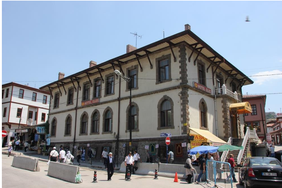
Şekil 2.13 Eski Şeriye ve Evkaf Vekaleti Binası, Ankara, Koyunoğlu'nun çatısını tamir ettiği yapı (Envanter, Y.y.y.)
