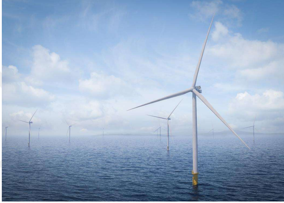
Görsel 3.2. Danimarka 'da bulunan V236-15.0 MW açık deniz prototip rüzgâr türbini (Vestas, 2022).
