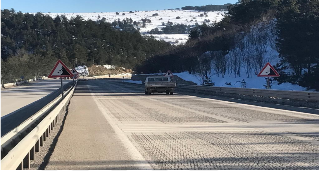
Şekil 5.19 Devrekâni ilçesi Oyrak geçidine ait fotoğraf
