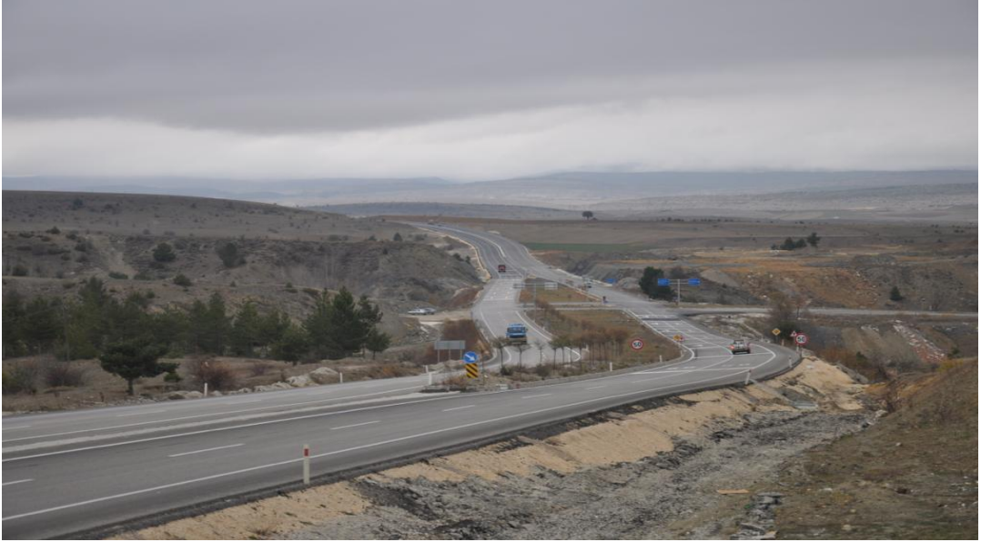
Şekil 5.25 Devrekâni kavşağı eski hali
