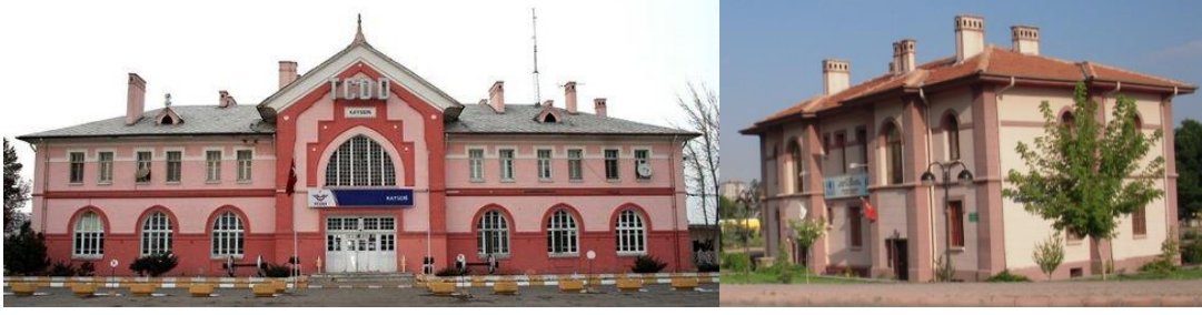
Şekil 3.2 Kayseri İstasyon Binası ve lojmanı (mapio.net)
