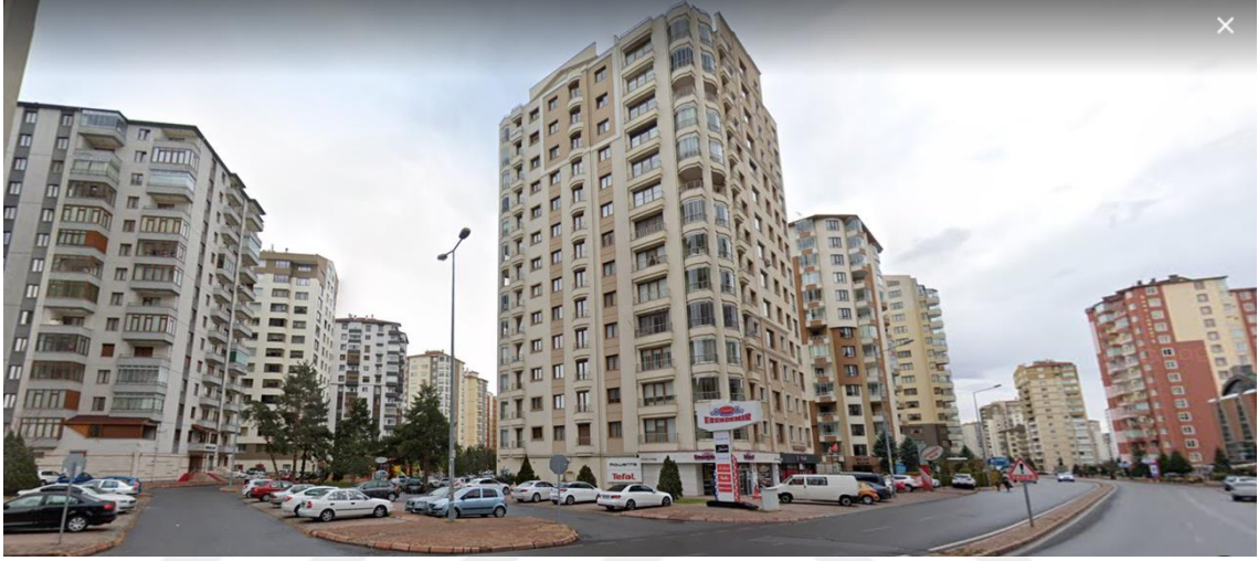
Şekil 3.11 Köşk Mahallesi'nden Genel Görüntü
