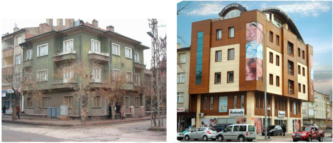
Şekil 4.6 1957 tarihli Tohumcu Apartmanı 2008'de yıkılarak yerine dış kliniği inşa edilmiştir (Eldek, 2012)
