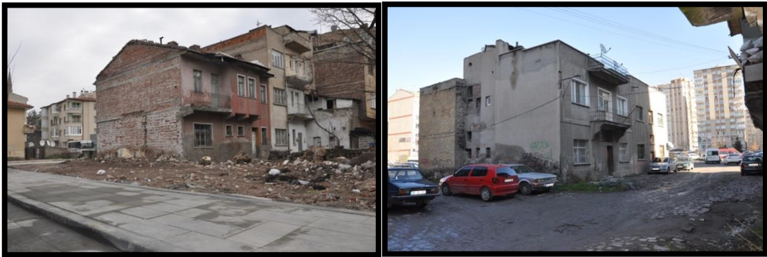
Şekil 4.9 Mahalleden kullanılmayan yapı örnekleri
