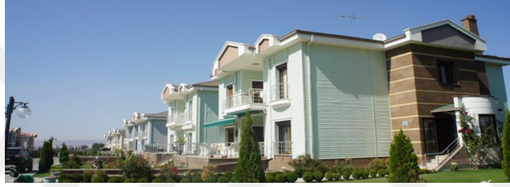
Şekil 3.13 Erenköy Mahallesi'nden iki site örneği
