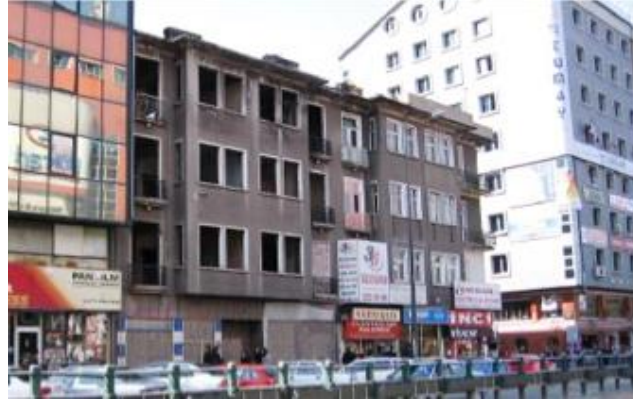
Şekil 4.7 İstasyon Caddesinden Eski Bir Apartman Örneği
