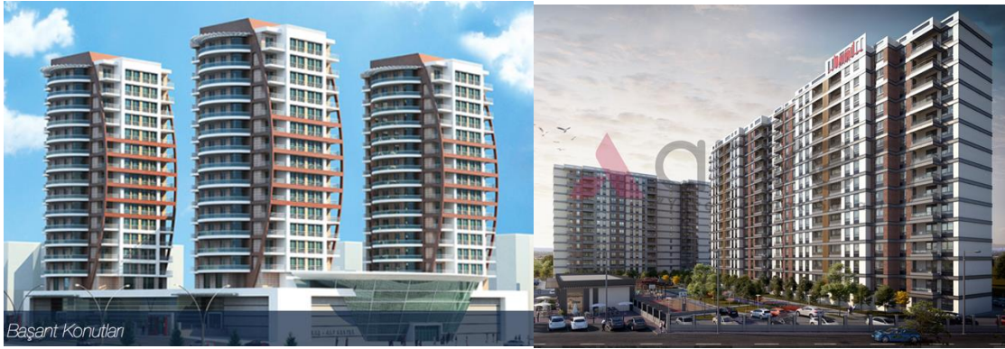
Şekil 3.12 Kapalı Site Örnekleri (solda Başant Konutları, sağda Arven Mahal Konutları)
