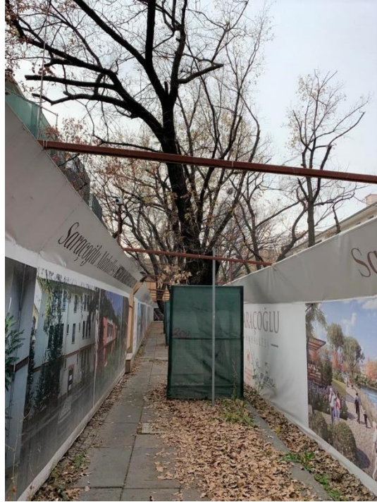
Şekil 2. 17 Saraçoğlu Mahallesi'nin iç bölgesindeki inşa alanı (Kaynak: kişisel arşiv)
