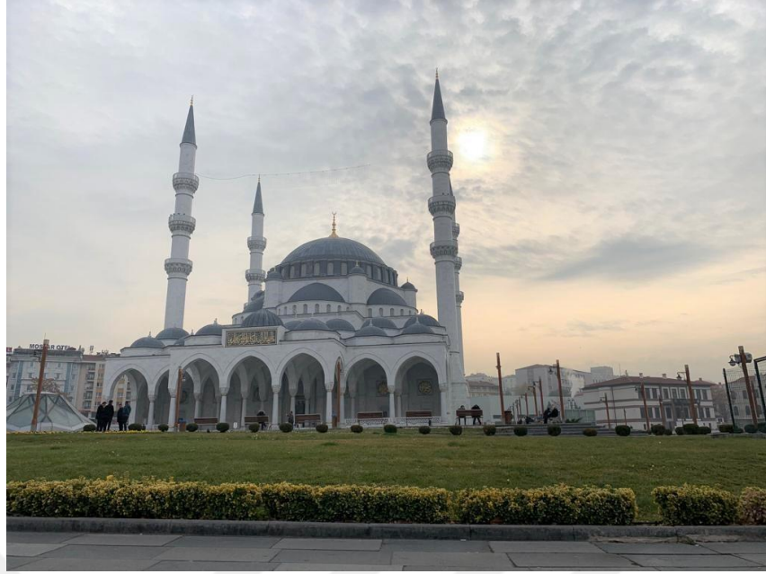
Şekil 2. 3 İller Bankası'nın yıkımı sonrası bölgenin güncel görünümü (Kaynak: kişisel arşiv)
