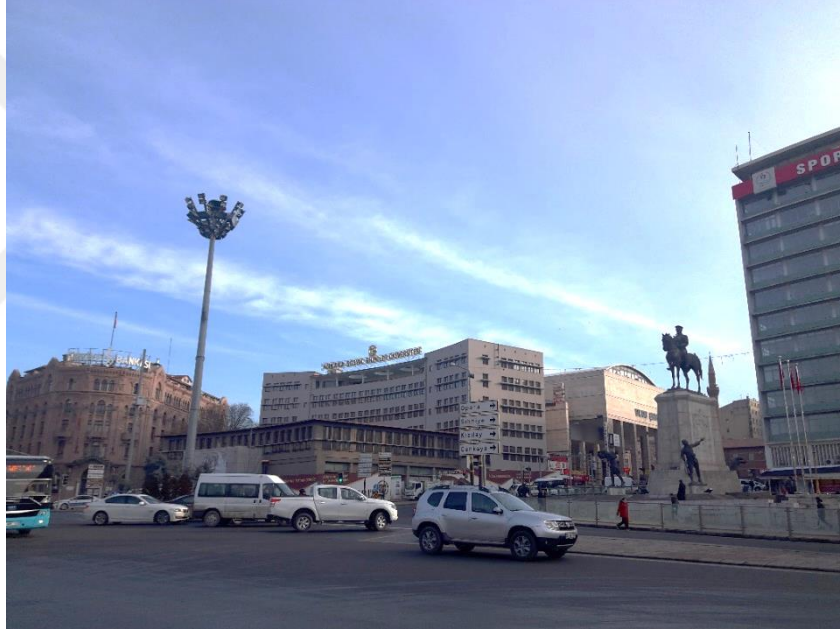
Şekil 2. 1 Türkiye İş Bankası (solda), Sümerbank: Ankara Sosyal Bilimler Üniversitesi Binası (günümüz) (ortada) ve Ulus Heykeli (Zafer Anıtı sağda)(Kaynak: kişisel arşiv)
