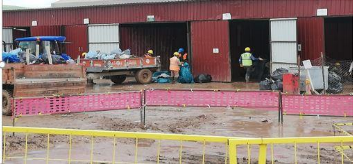
Şekil 6. Şantiye atık alanı atıkların ayrıştırılıp bölmelere konulması görünümü
