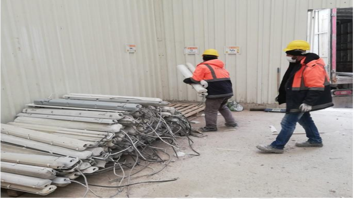
Şekil 8. Oluşan atıkların atık sınıfına göre ayrı ayrı paketlenip istiflenmesi
