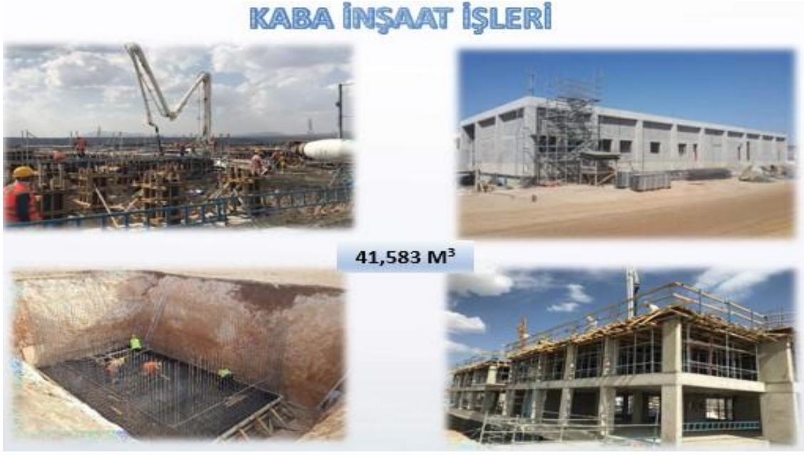
Şekil 12. Kaba inşaat işleri çalışması (Keleşoğlu, A. 2019).
