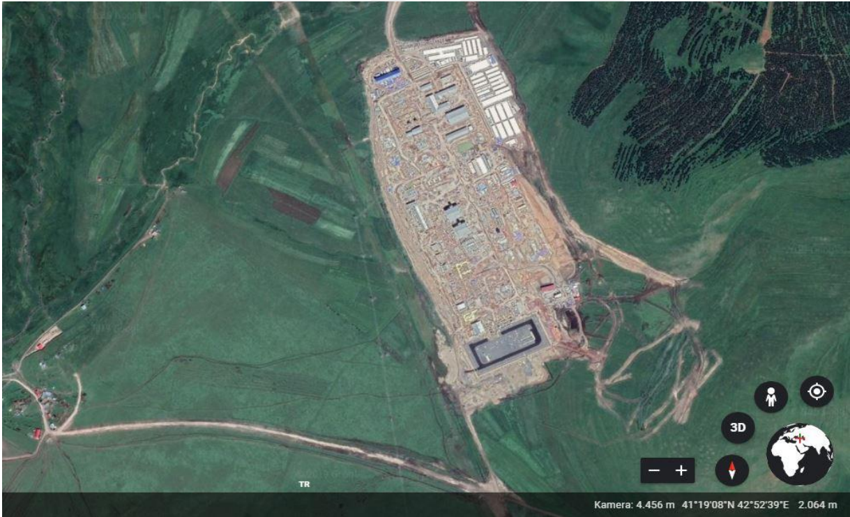
Şekil 2. Tanap Ardahan Kompresör İnşaat şantiyesi üstten görünümü.
