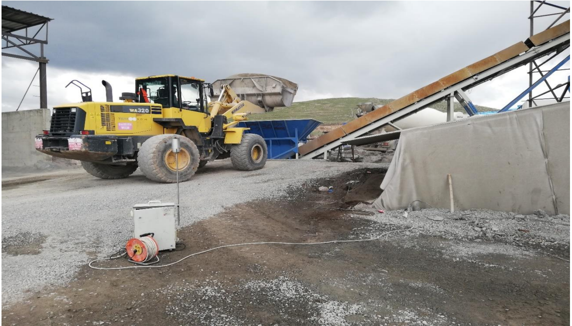
Şekil 4. Beton santrali çalışma alanı görüntüsü
