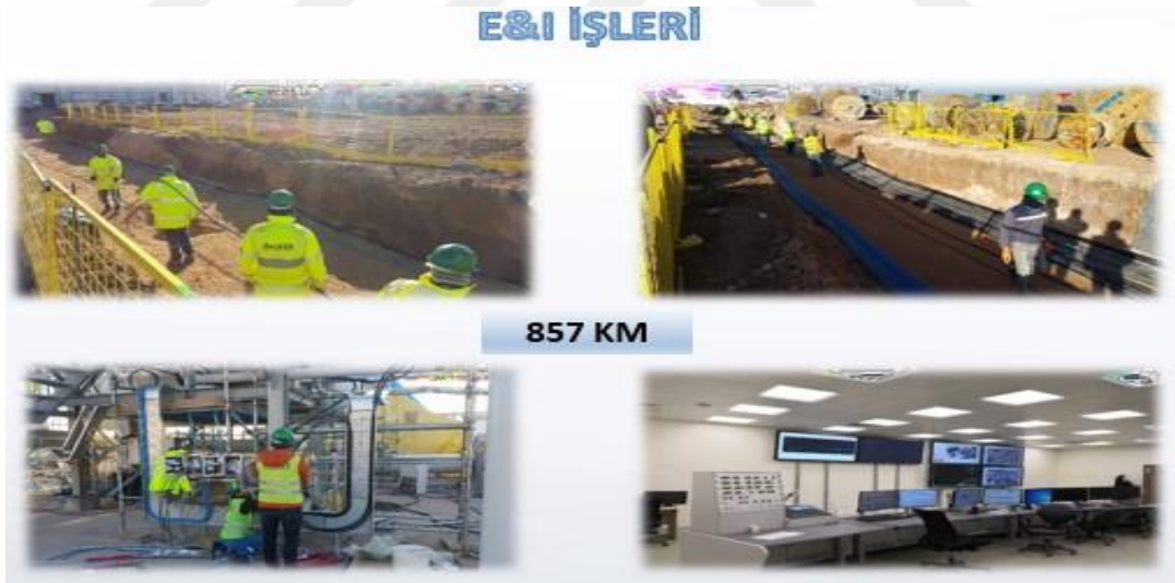
Şekil 15. Genel sahada çekilen elektrik işleri ve fiber kablo miktarı. (Keleşoğlu, A.2019).
