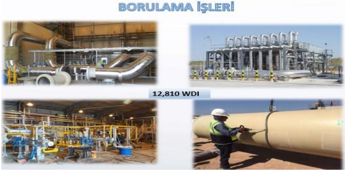
Şekil 14. Borulama İşlerinde 12,810 wdi kaynak işlemi (Keleşoğlu, A. 2019).
