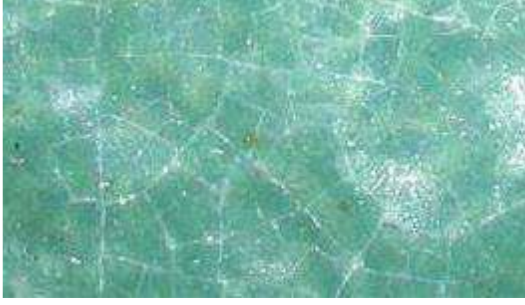
Resim 3.19. Sır Çatlağı (Karasu, 2020)
