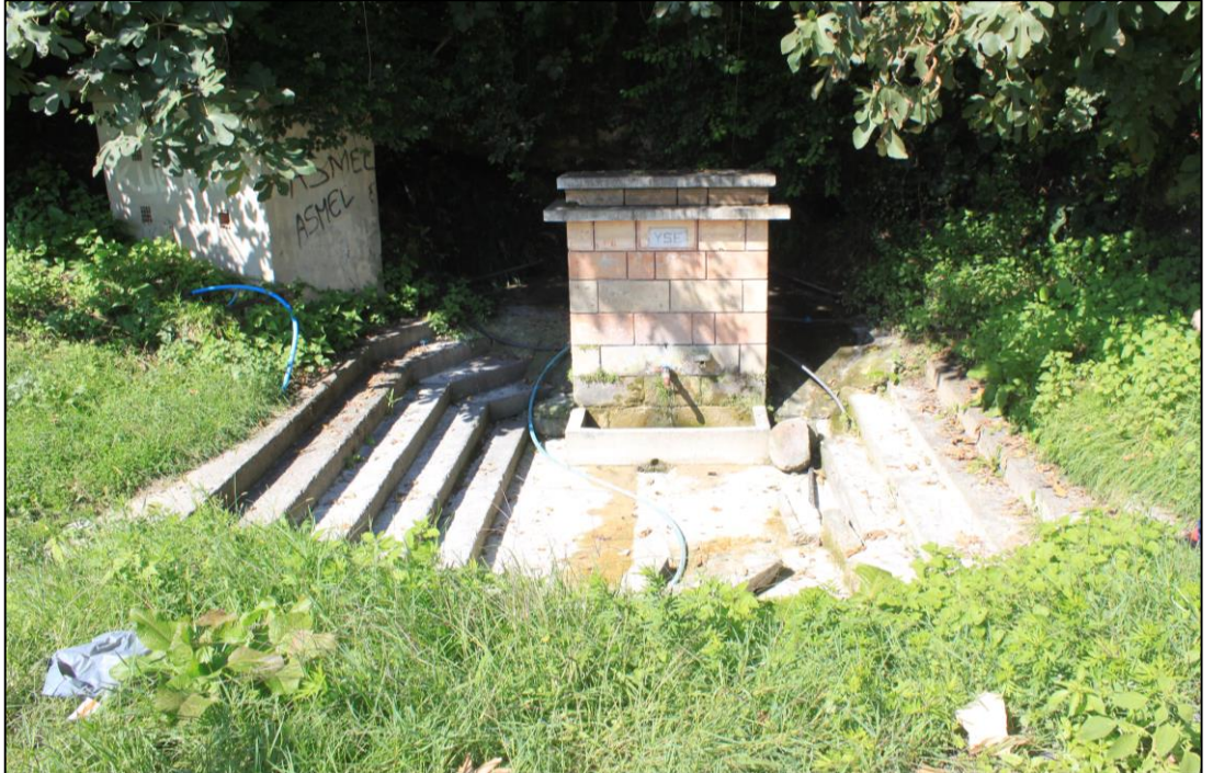
Şekil 3.28. Çatalpınar Mahallesi resürjans kaynağı çıkışı
