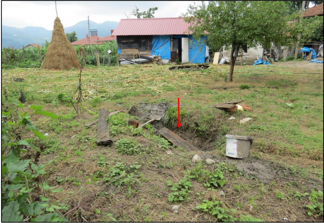
Şekil 3.23. Kaleköy Mahallesiinde yer alan fosseptik çukurlarından biri
