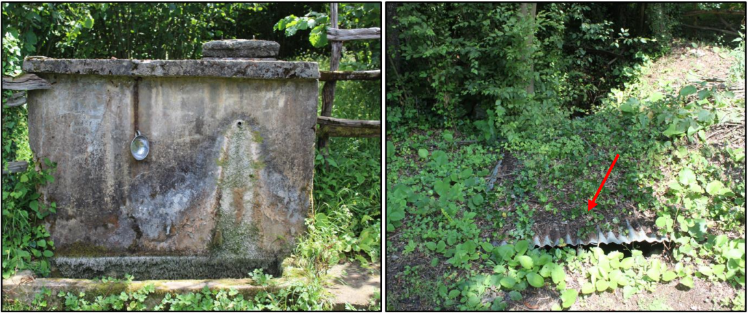
Şekil 3.35. Atıl durumda olan çeşme (solda) üzeri kapatılmış eski su kuyusu (sağda)
