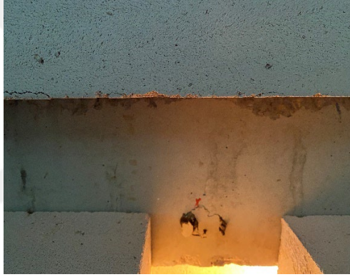
Şekil 5.14 Numunelerdeki bozulmalar a) Soyulma-toz haline gelme-dökülme b) Su kaybı c) Çatlaklar d) Kararmalar
