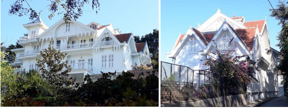
Şekil 142-143. Ağasi Efendi Köşkü'nün Günümüzdeki Durumu (Ön ve Arka Cepheler) (Amil Faruk Gezen-2020)
