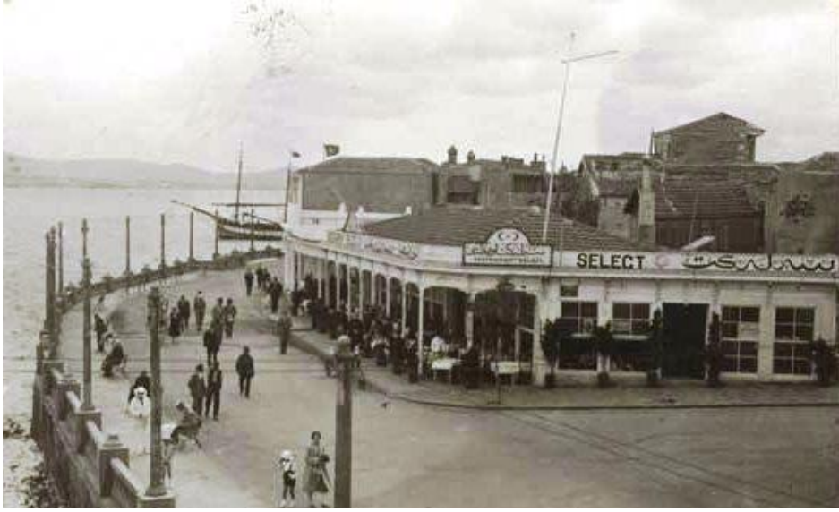
Şekil 154. 20. Yüzyıl Başlarında Selekt Lokantası
