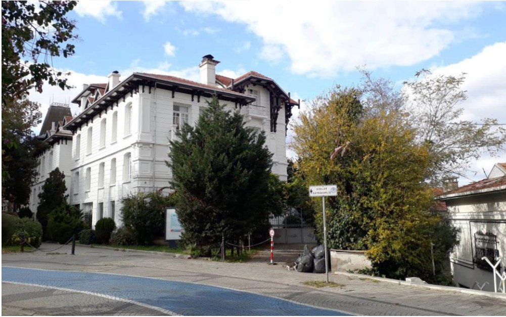
Şekil 172. Günümüzde Giacomo Otel'i'nin Yerinde Bulunan Anadolu Kulübü Binası (Amil Faruk Gezen-2020)
