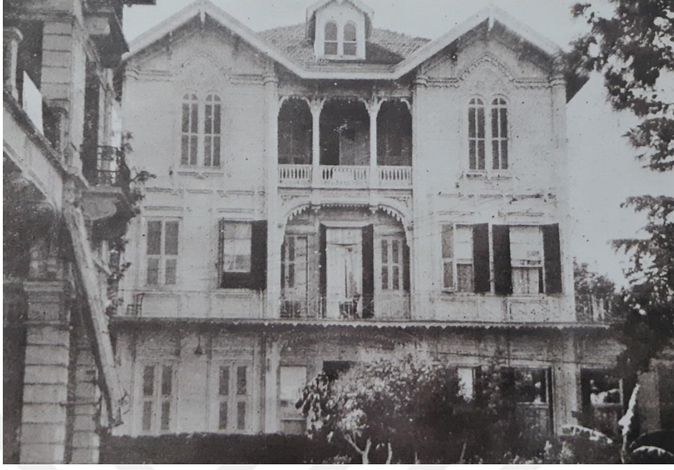
Şekil 175. Zarifi Köşkü Yıkılmadan Önce
