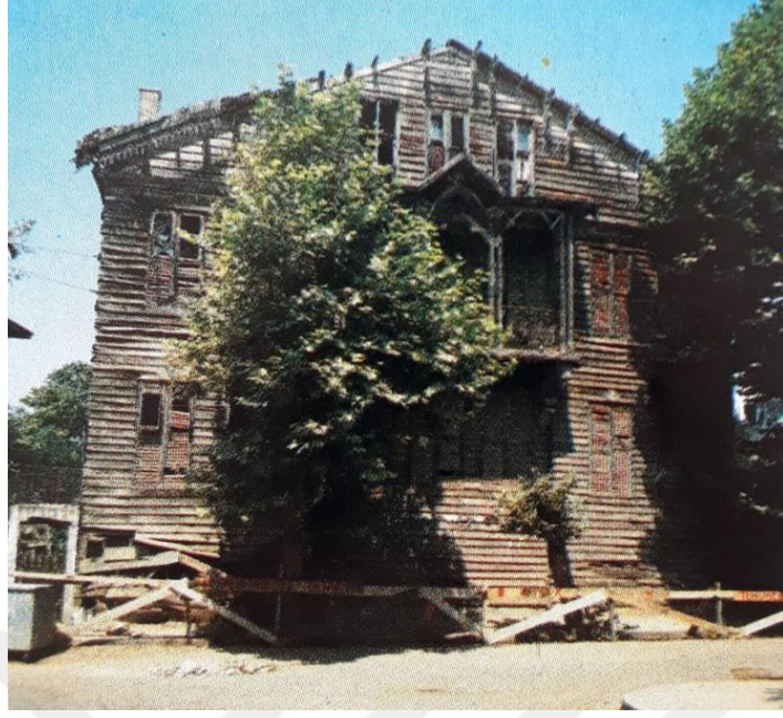
Şekil 144. Sahak Mesrob Ermeni Okulu Yıkılmadan Önce
