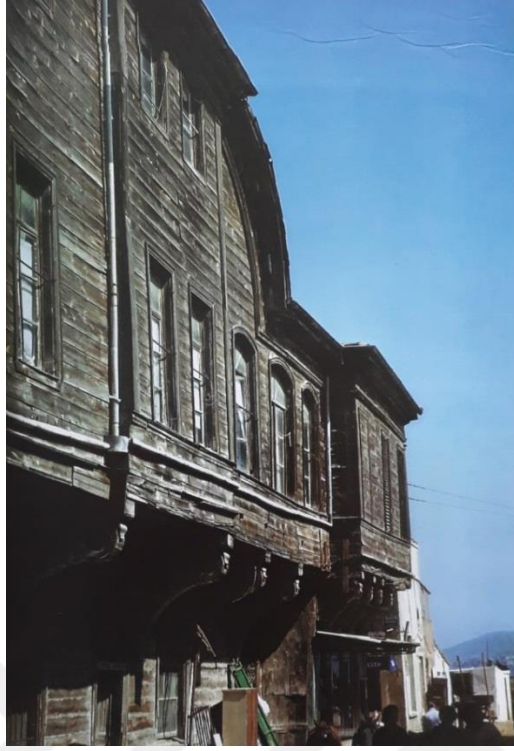
Şekil 165. Kangelaris Köşkü'nün Özdemir Sokağı'na Bakan Cephesi
