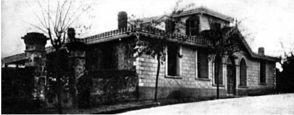
Şekil 190. Hamson Evi'nin Yol Cephesi
