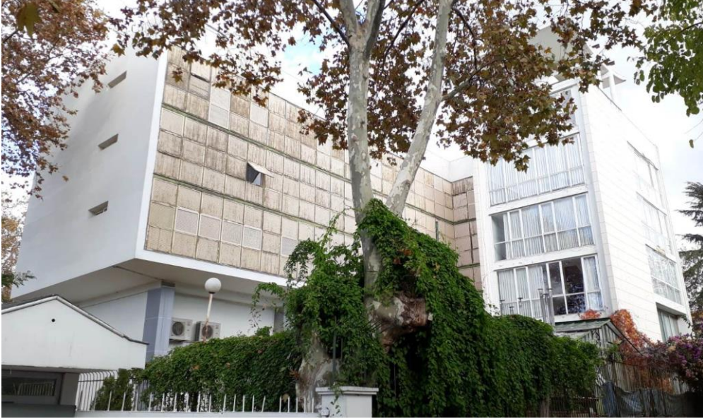
Şekil 176. Günümüzde Zarifi Köşkü'nün Yerinde Bulunan Anadolu Kulübü Otel Binası (Amil Faruk Gezen-2020)
