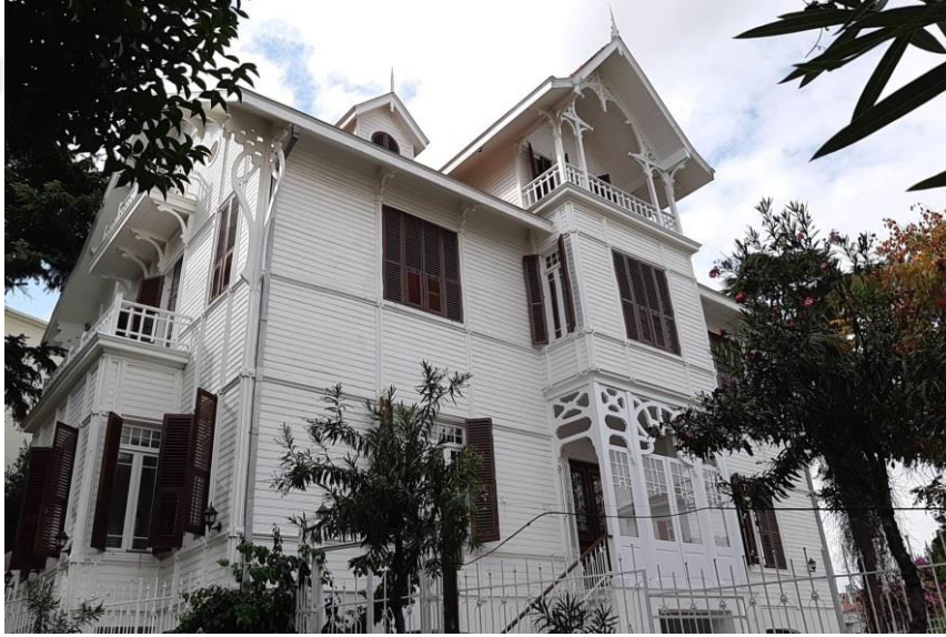
Şekil 127. Restorasyon Sonrası Kazım Paşa Köşkü (Amil Faruk Gezen-2021)
