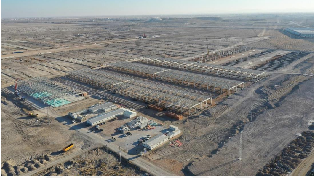
Şekil 7.7(a). Konya Yeni Motorlu Küçük Sanayi Sitesi şantiyesi
