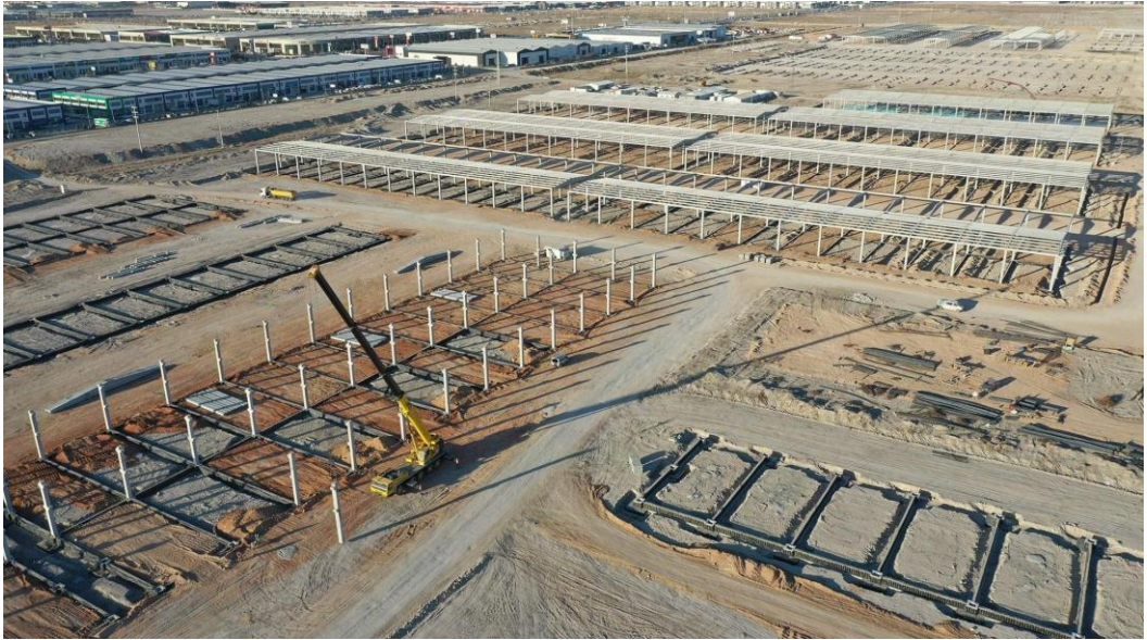
Şekil 7.7(b). Konya Yeni Motorlu Küçük Sanayi Sitesi şantiyesi
