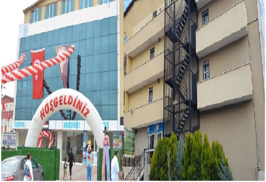
Şekil 6.1. Çalışmanın Yapıldığı Özel Okulum Ön ve arka Cephesi
