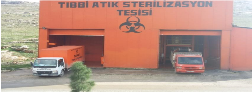
Şekil 4.23. Şanlıurfa ili Tıbbi Atık Sterilizasyon Tesisi dıştan görünüm
