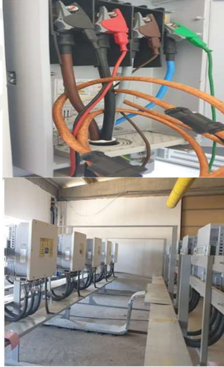
Şekil 4.25 HT PQA824 Güç Kalitesi Analizörü Ölçüm Bağlantısı (Tesis-3 İnvörtör-1)
