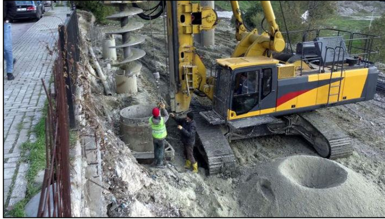
Şekil 29 Ambarlı Mahallesi kıyı hattında kazık çakılma işlemi-2 (URL-24).
