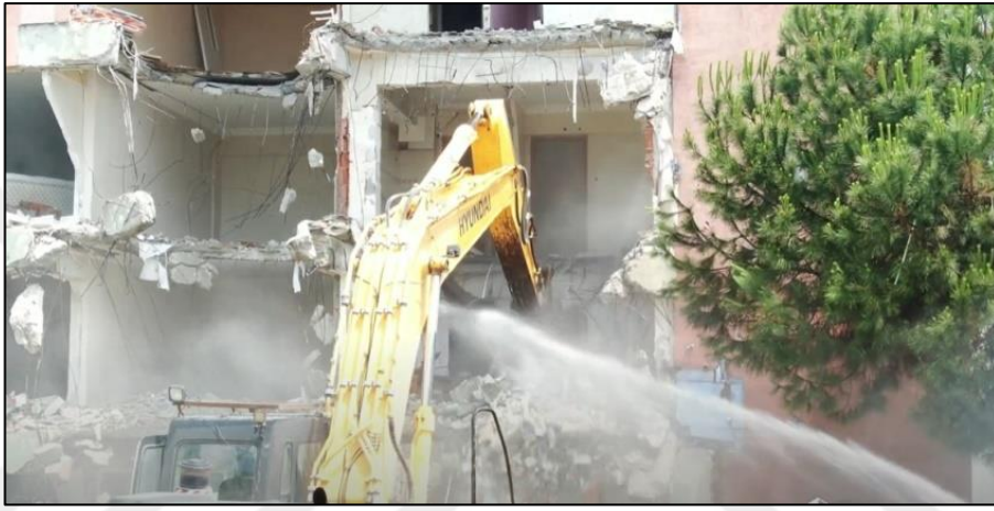
Şekil 40 Binaların yıkım aşaması görüntüleri (Kaynak: Yazar).
