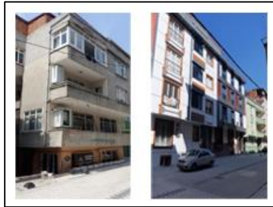
Şekil 22-23 Küçükçekmece İlçesi Kanarya Mahallesi 478 Ada 26 paftada bulunan parselin yenileme öncesi ve sonrası görüntüleri (Ergün, 2019).
