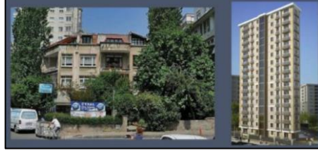
Şekil 20-21 Caddebostan Mahallesi Sarıgül Sokak'ta bulunan parselin yenileme öncesi ve sonrası görüntüleri (Özer ve Ark., 2015).
