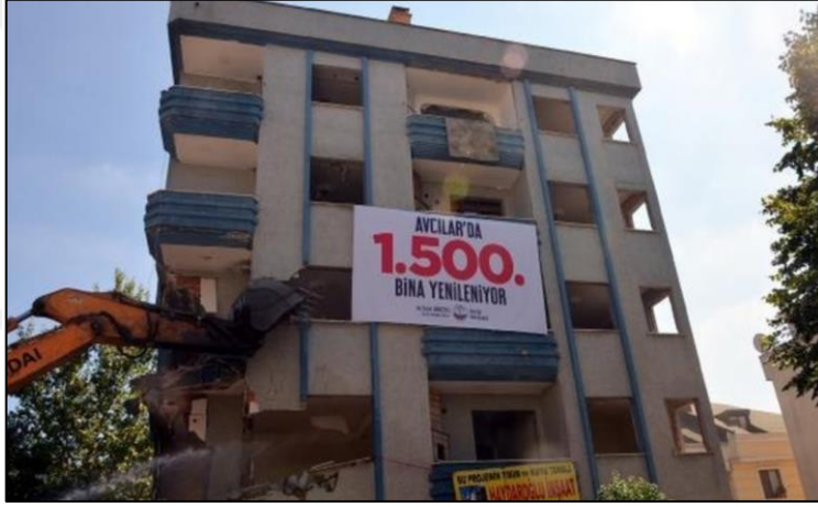
Şekil 31 Avcılar'da yenilenen 1.500. bina (17.08.2021) (URL-26).
