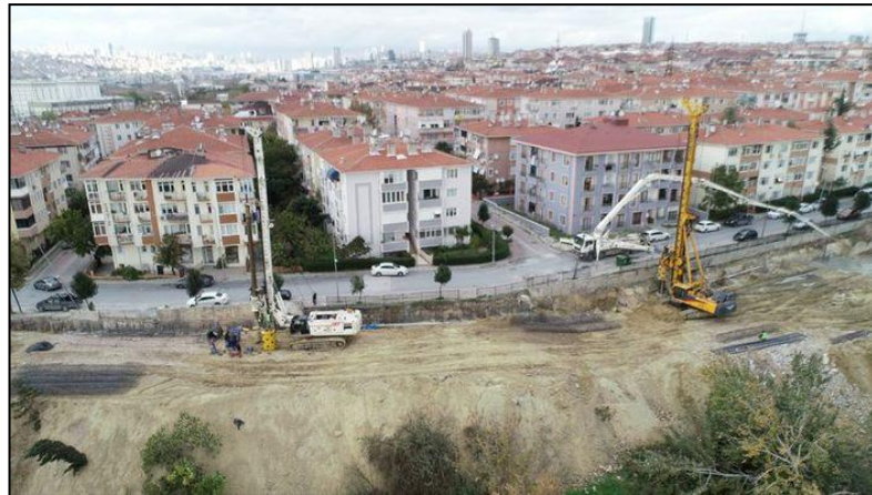
Şekil 28 Ambarlı Mahallesi kıyı hattında kazık çakılma işlemi-1 (URL-24).
