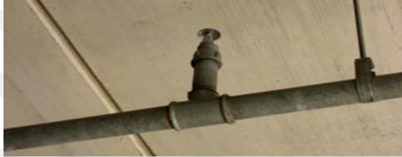
Şekil 3.1. Otomatik çalışan sprinkler sistemi
