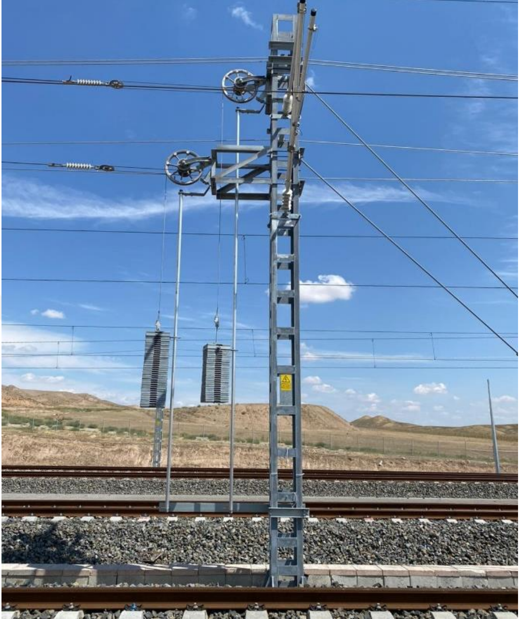
Görsel 2.6. Ağırlıklı otomatik gergi cihazı
