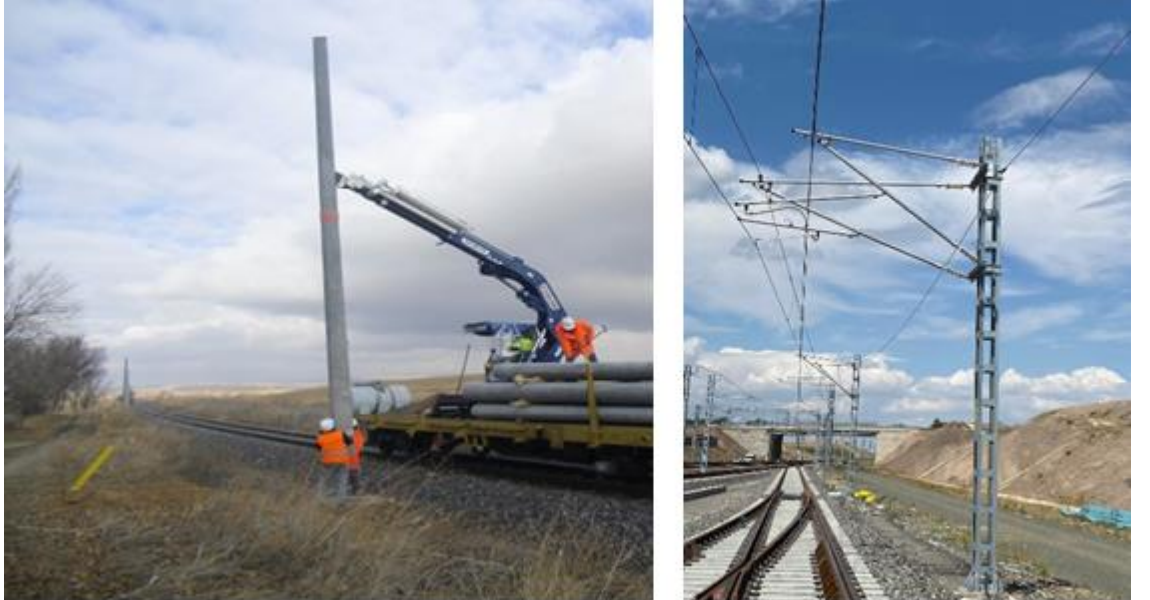
Görsel 2.1. Beton direk(sol), Çelik kafes direk(sağ)
