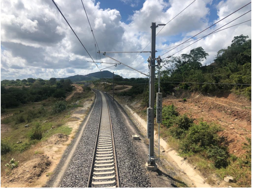
Görsel 2.2. Çekiye konsol-hoban takımı saha uygulama örneği
