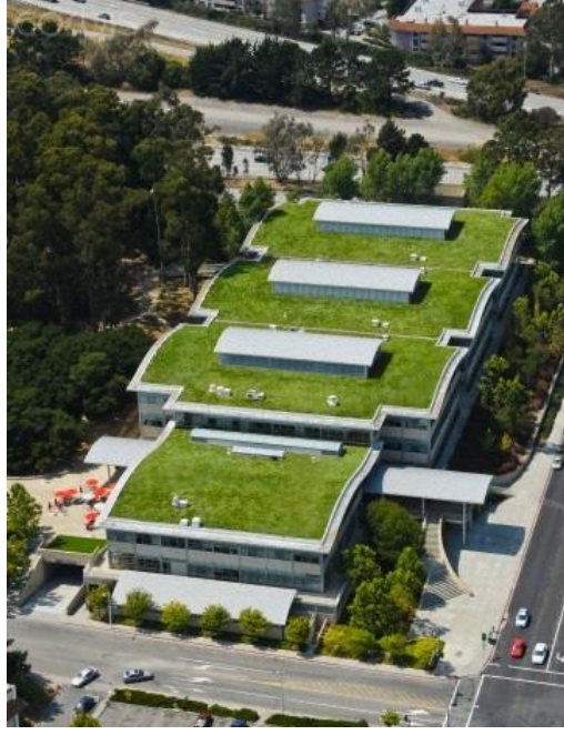
Şekil 4.43. Kaliforniya'daki GAP giyim ofislerinin yeşil çatısından bir görünüm (Green Roofs for Healthy Cities, 2015)
