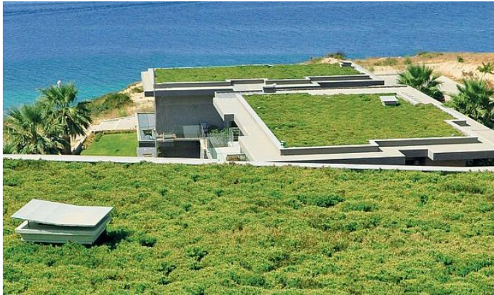
Şekil 4.39. Çeşme Şato Ayasaranda Design Hotel çatıda Sedum sp. Uygulaması (Karakoç, 2014)
