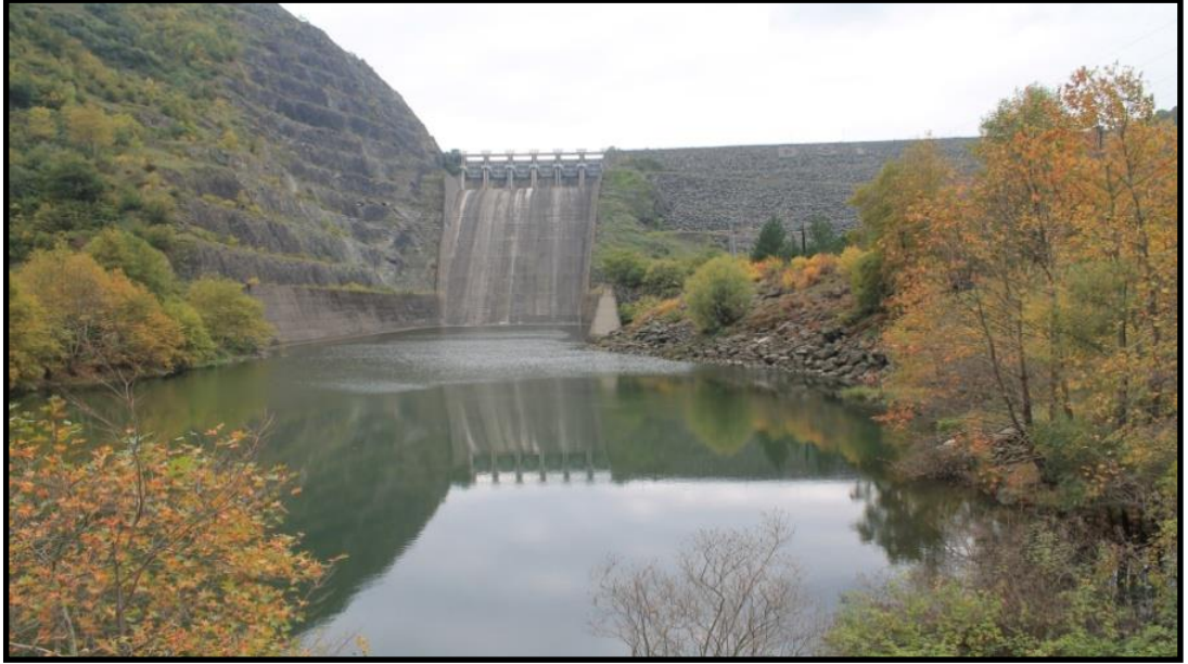
Şekil 2: İnceleme alanının güney sınırını oluşturan Hasan Uğurlu barajı
