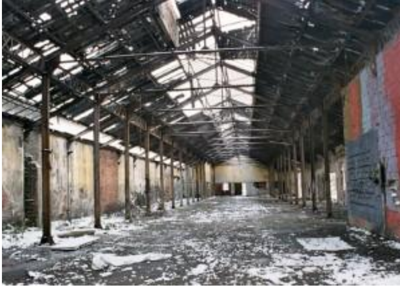
Şekil 44: Kibrit Fabrikası'nın İçmekan Görünüşü
