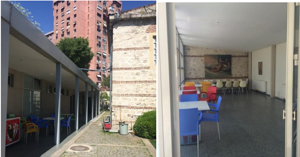
Şekil 97: Avlu girişinin solunda bulunan ek bina (sol) binanın iç mekânı (sağ)
