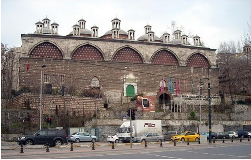
Şekil 78: Tophane-i Amire binası görünüşü
