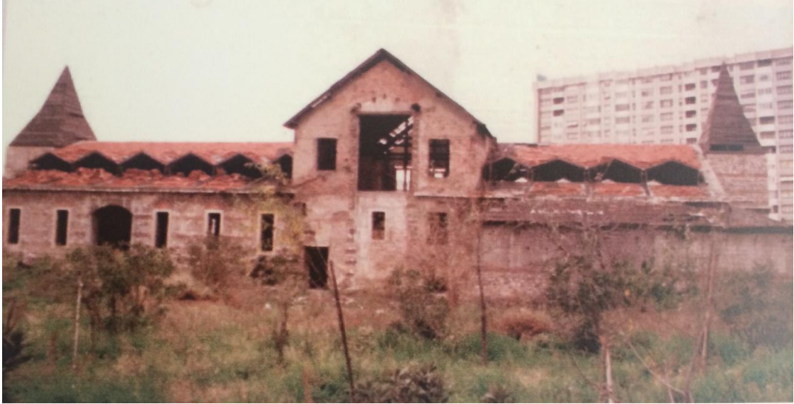
Şekil 112: Bakırköy İspirtohane Binası Yenileme öncesi durumu
