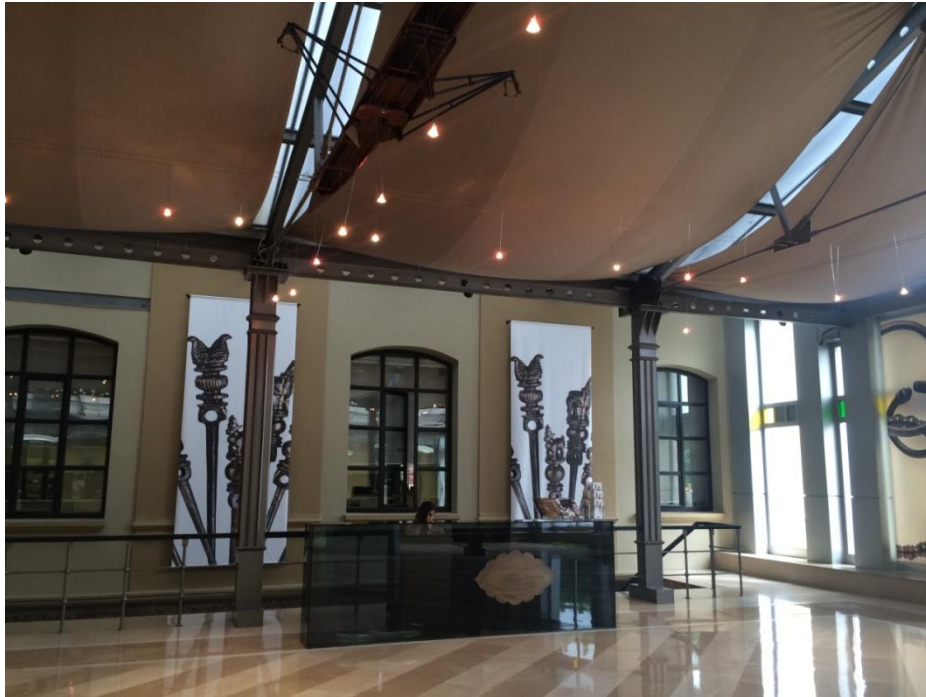
Şekil 158: Yenileme sonrası iki blok arasında yapılmış olan çelik- gergi çatı görünümü.
