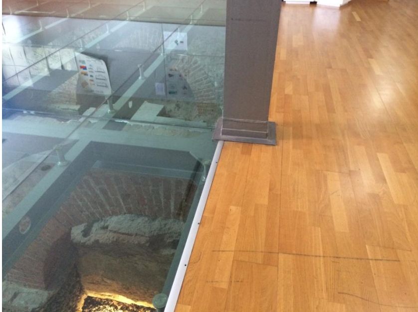
Şekil 182: Giriş fuayesine yapılan çelik konstrüksiyonlu cam döşeme (R.A. Ağrılı arşivi)
