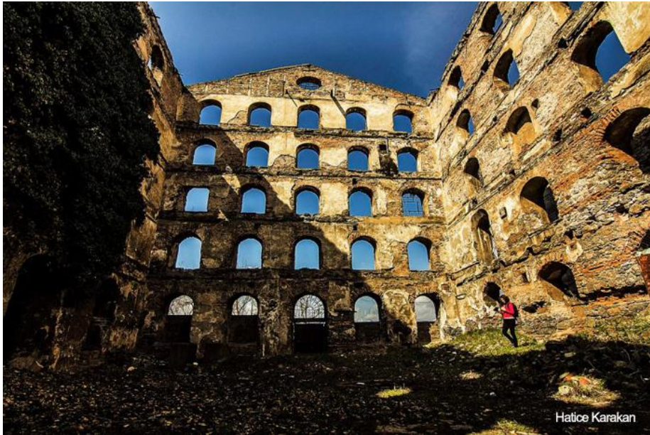
Şekil 64: Paşalimanı Un Fabrikası Dış Cephe Duvarlarının İç Görünümü
