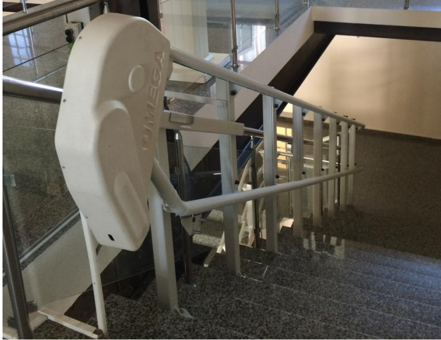
Şekil 122: Ana merdivene eklenmiş olan merdiven asansörü (R. A. Ağrılı Arşivi)
