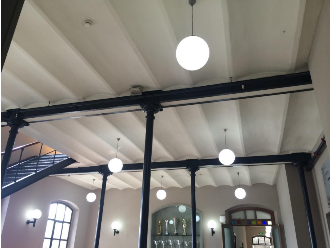
Şekil 157: A blok giriş alanında sütunları birleştiren çelik kirişler ve volta döşeme görünümü (R.A. Ağrılı arşivi)
