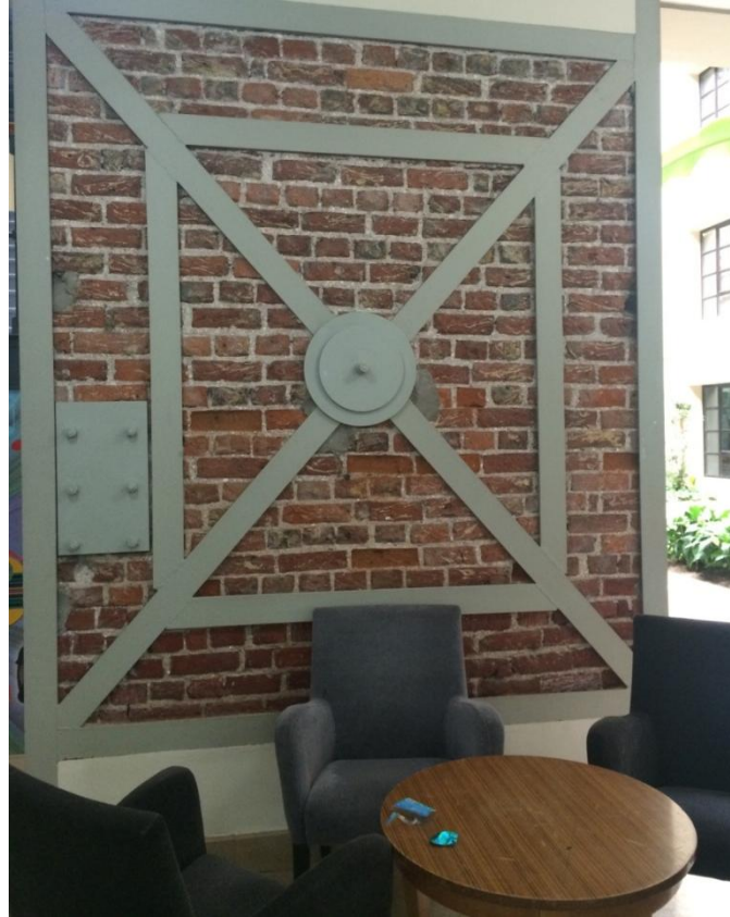
Şekil 160: B Blok kafeteryasında bulunan tuğla duvarların güçlendirilmesinde kullanılan çelik konstrüksiyon (R.A. Ağrılı arşivi)
