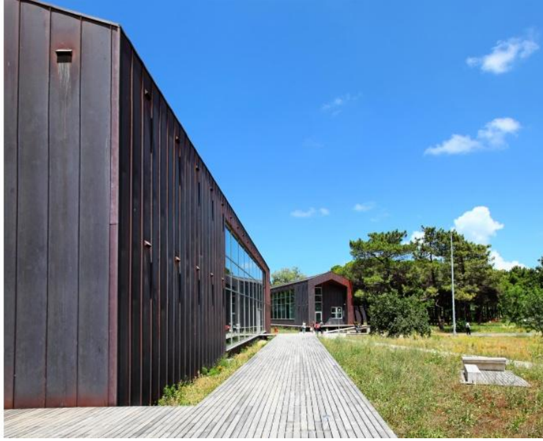
Şekil 72: Terkos Su Pompa İstasyonu
