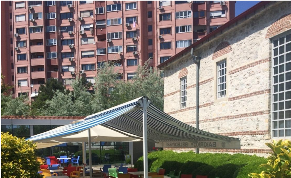
Şekil 111: Yapının dikdörtgen söveli pencereleri ve tuğladan yapılmış daire kemer deseni (R. A. Ağrılı Arşivi)
