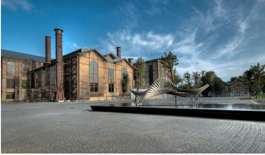
Şekil 66: Yenilenen santral binalarından Bir görünüm
