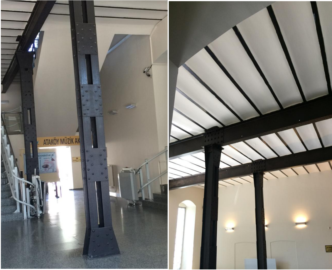
Şekil 117: Yapının Giriş katında Bulunan Dökme Demir Kolonların Görünüşü
