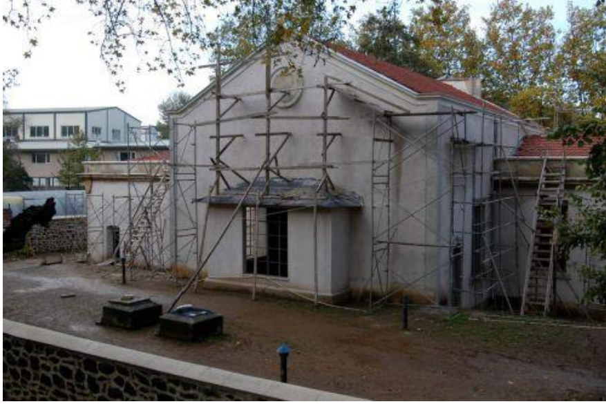
Şekil 18: Cendere Hamidiye Su Pompası Restorasyon Çalışmaları
