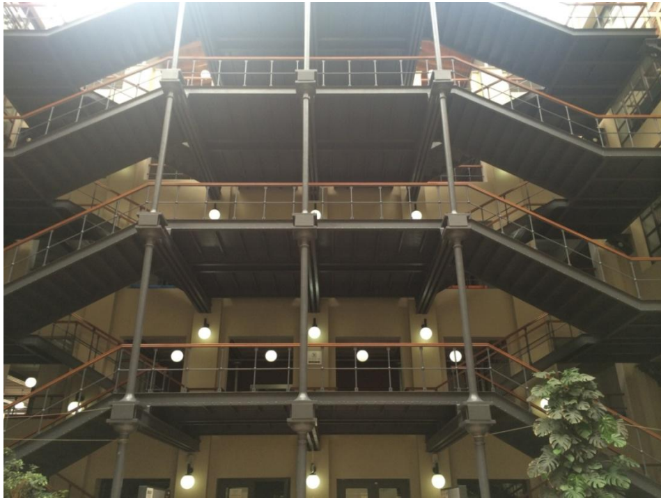
Şekil 141: B blokta bulunan ve bütün katları bağlayan merdivenler ve galeriler
