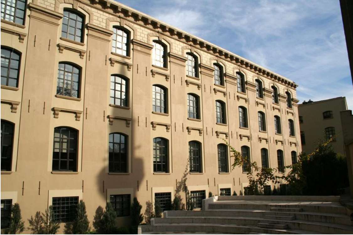
Şekil 152: Cephede Görünen Pahlı Kesme Taş Biçimli Kemerlerden görünüş
