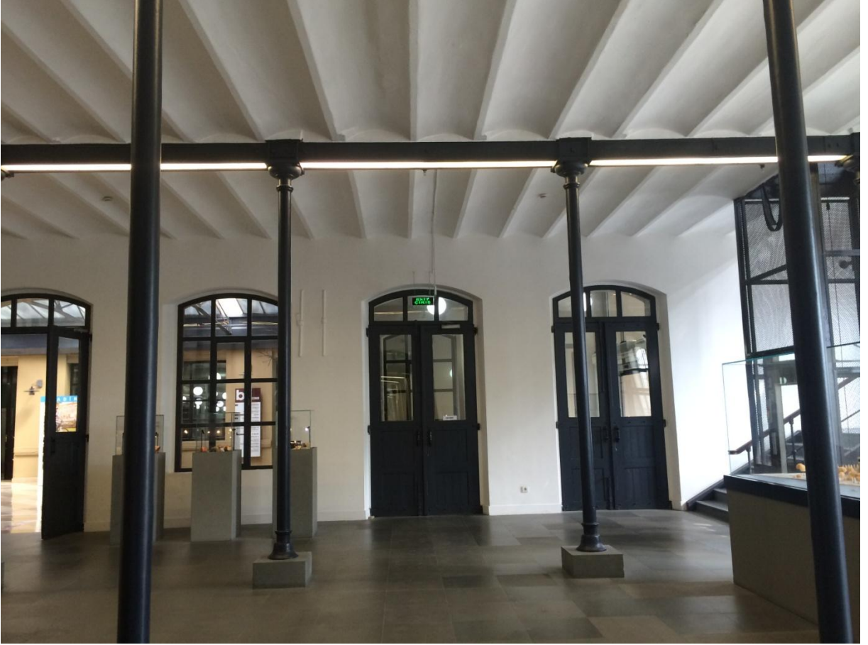
Şekil 138: A blok zemin kat giriş bölümü
