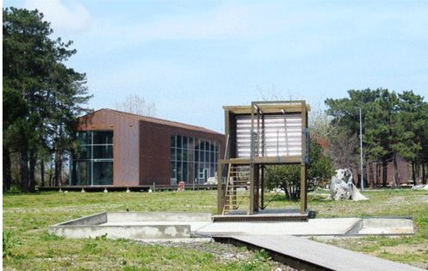
Şekil 73: Terkos Su Pompa İstasyonu genel görünüşü
