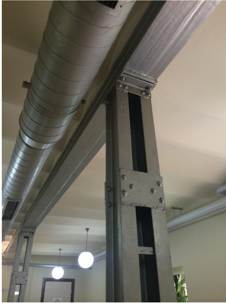
Şekil 179: Strüktür elemanı dökme demir dikme ve yanında konumlandırılmış olan havalandırma kanalı (R.A. Ağrılı arşivi)
