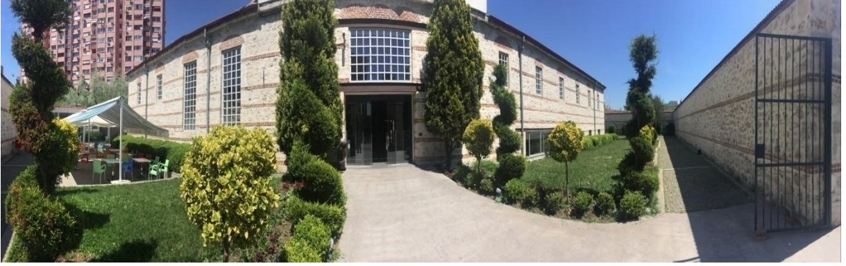
Şekil 110: Bakırköy İspirtohane Binası Ana Giriş Kapısından Görünüş (R. A. Ağrılı Arşivi)
