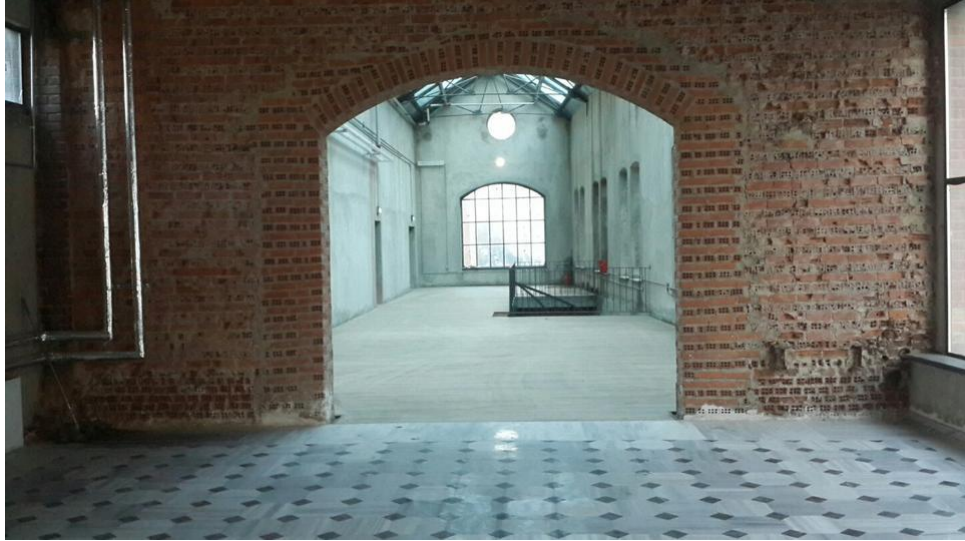
Şekil 15: Bomonti Bira Fabrikası Restorasyon Öncesi
