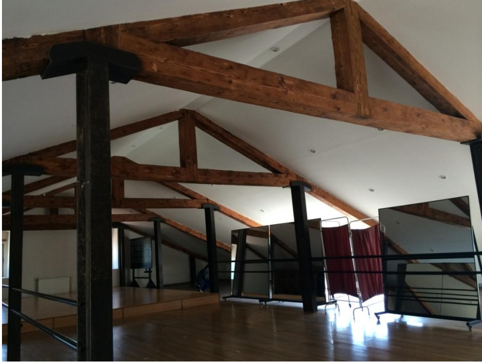
Şekil 118: Birinci kat Bale Stüdyosu dökme demir kolonları ve çatı makasları
