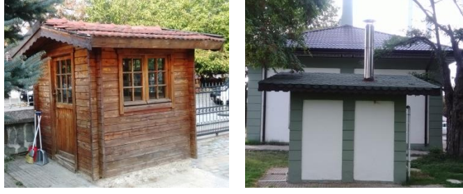
Şekil 44: 23 No'lu Güvenlik Kulübesi ve 24 No'lu Trafo Merkezi
