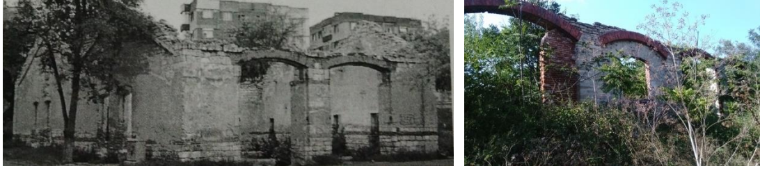
Şekil 41: Kırklareli Lokomotif Deposu ile Edirne Hangar Binası
