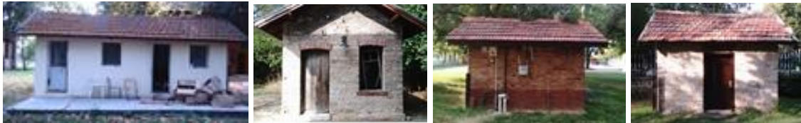
Şekil 43: 19, 20, 21, 22 No'lu hela ve depo binaları
