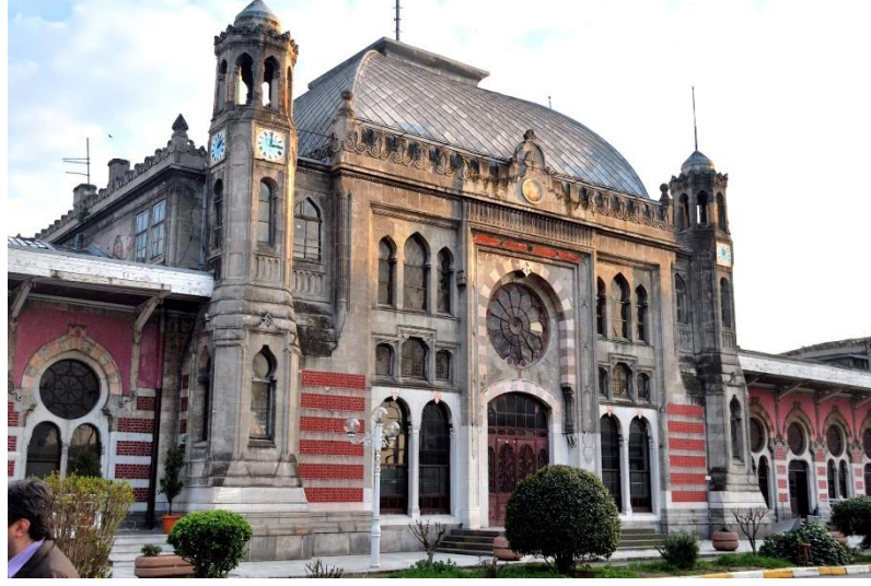
Şekil 10: Sirkeci Garı Dış Görünüş (46)
