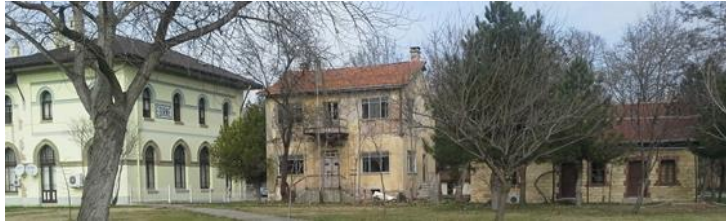
Şekil 31: Eski PTT binası peron cephesinden görünüş (13.02.2014)
