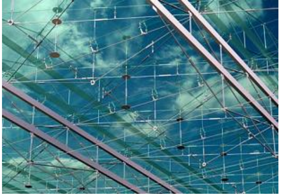
Şekil 2.12: Çelik gergili sistemle yapılmış transparan çatı alt görünüşü [9]
