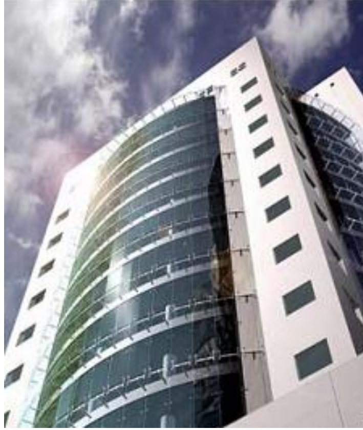
Şekil 2.14: Transparan cephe sistemi ile yapılmış bina [9]
