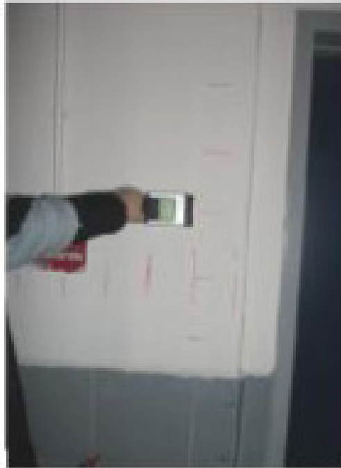
Şekil A.2 : Donatı tespit cihazı ile donatı çapı ve aralıklarının belirlenmesi-1.
