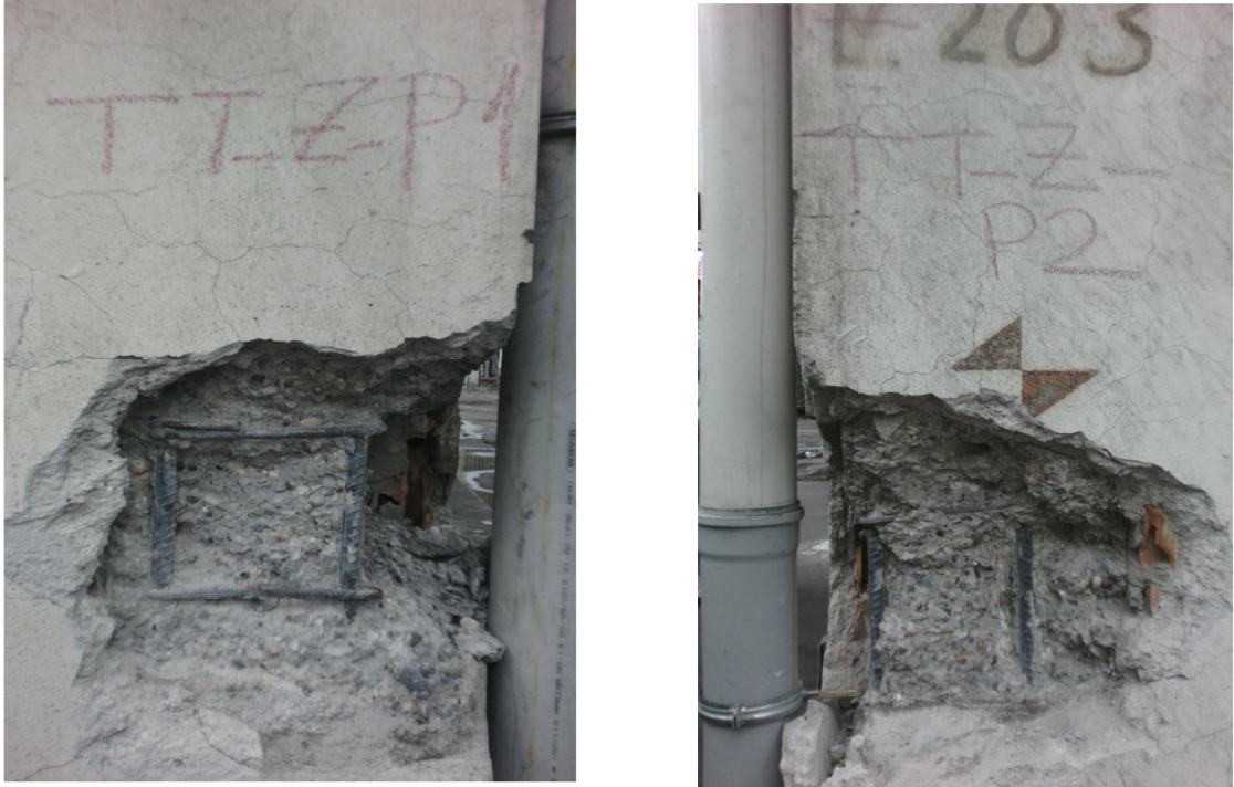
Şekil A.10 : Paspayı sıyrılması-1.
