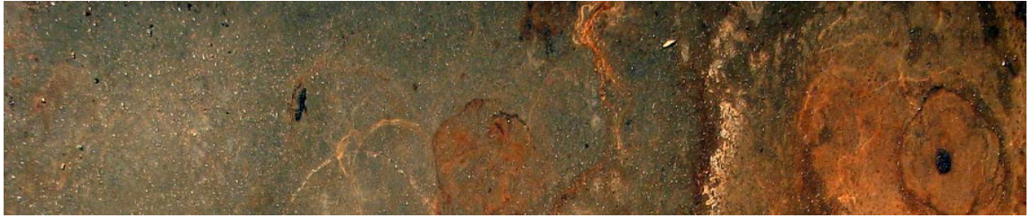
Şekil 2.8. Metal yüzeyinde farklı korozyon türleri (Anonim 2015a)
