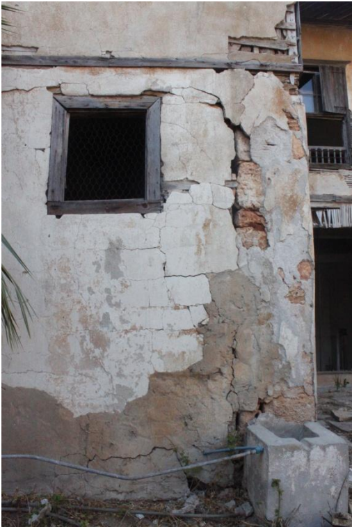
Şekil C 227. Güney cephesi / EK01 penceresi.
