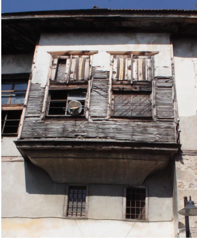
Şekil C 217. Batı cephesi / ARA02 pencereleri ve cumba.
