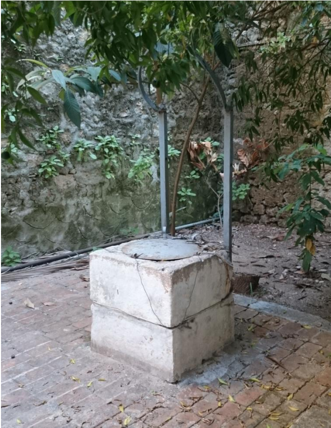
Şekil A 12. Avluda bulunan kuyu / Müze Sokak, Paşa Konağı.
