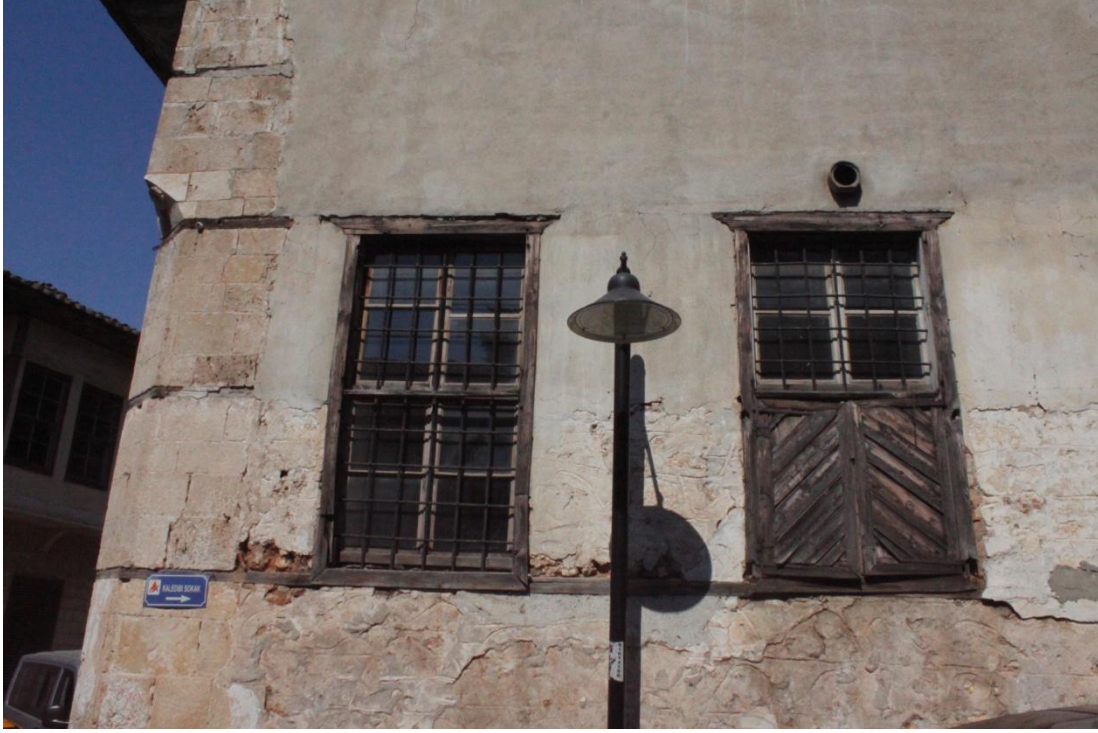
Şekil C 214. Batı cephesi / Z03 pencereleri.
