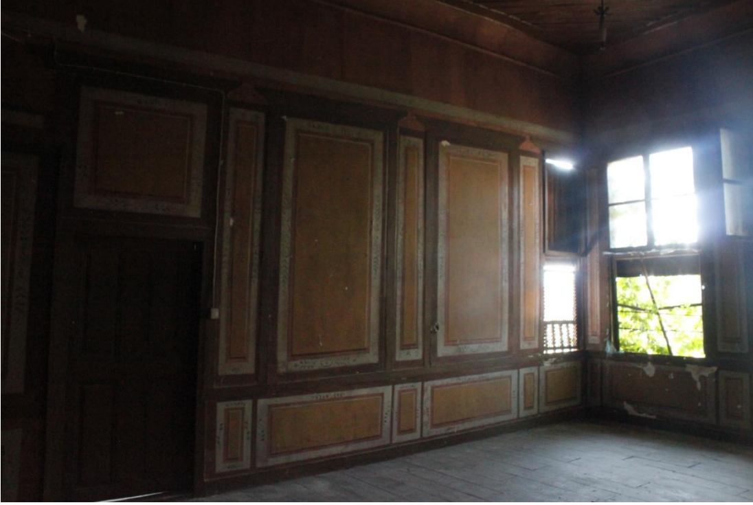
Şekil C 110. 1K03 batı duvarı üzeri ahşap çerçeveler ve dar pencere.
