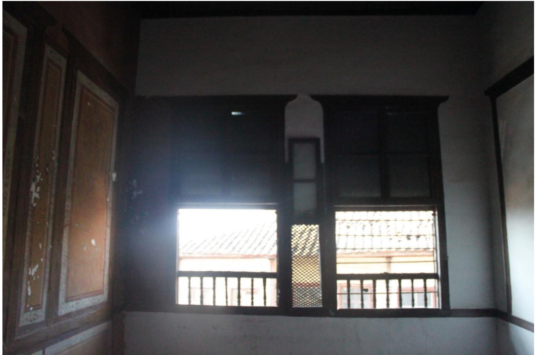
Şekil C 100. 1K02 kuzey duvarı pencereleri.
