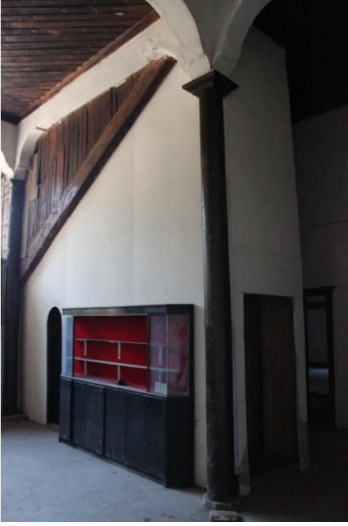
Şekil C 34. Kapatılmış ahşap merdiven altı.
