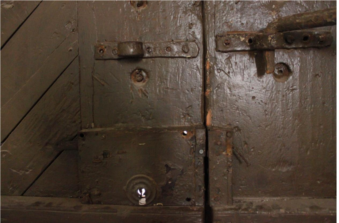
Şekil C 252. Ahşap kapı üzerinde metal elemanlar.
