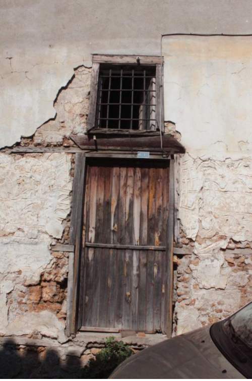
Şekil C 285. Z04 mekanından kapatılmış kapı.
