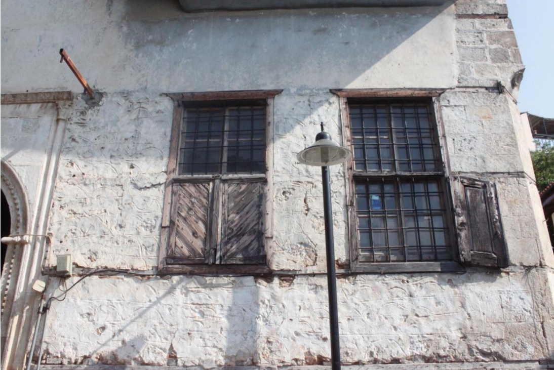
Şekil C 203. Kuzey cephe / Z03 mekanı pencereleri.
