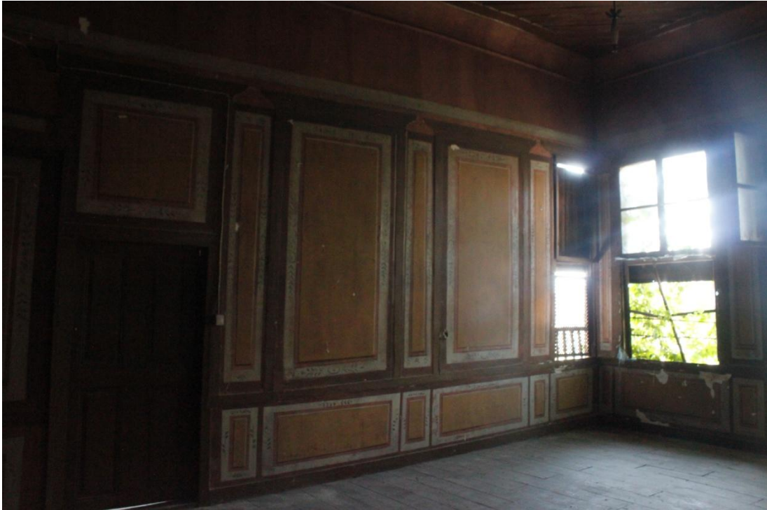
Şekil C 115. 1K03'ten 1K02 mekanına geçiş / 1K03 batı duvarı.
