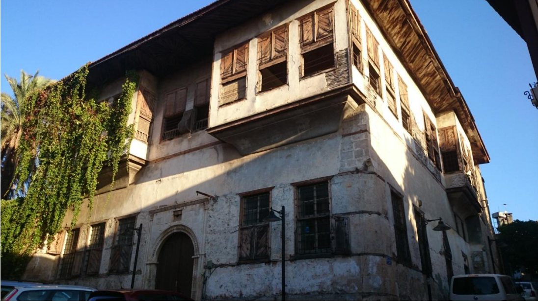
Şekil C 14. Ömer Lütfü Lülü Konağı kuzey cephesi.
