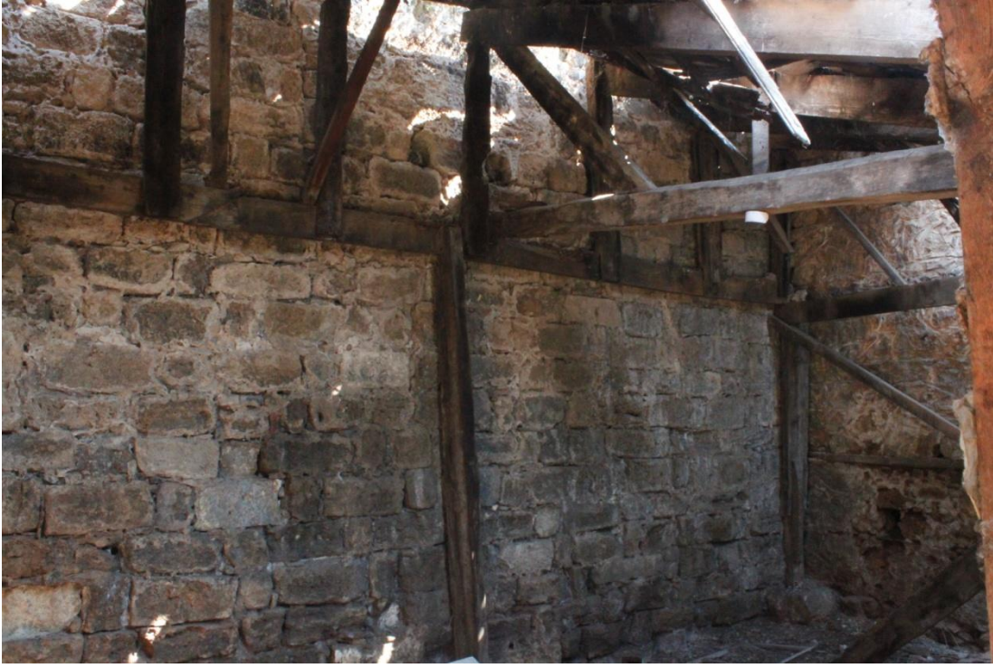
Şekil C 198. Servis yapısı 2'nin iç mekanı.
