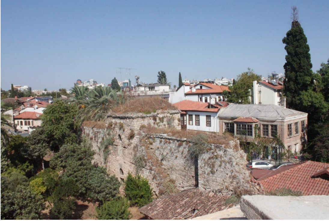
Şekil C 1. 115 ada 15 parseldeki sur duvarı ve burç.
