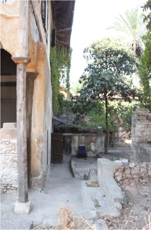
Şekil C 233. Güney cephesi / Muhdes duvar.
