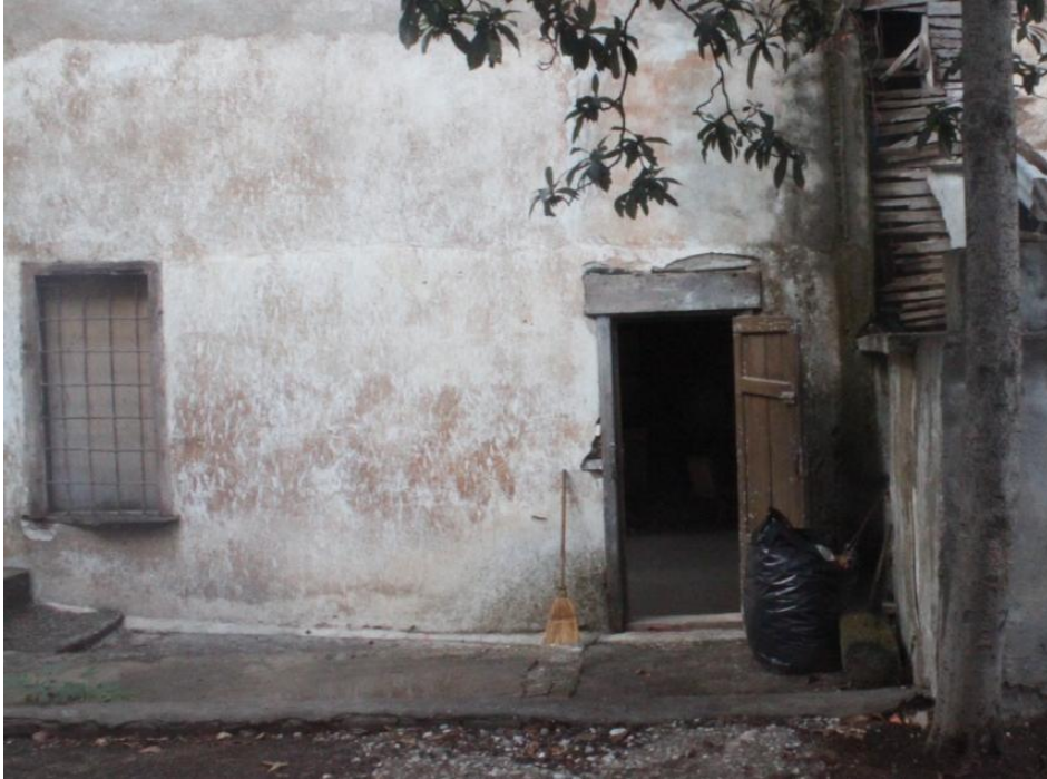
Şekil C 241. Doğu cephesi / Muhdes duvar üzerinde kapı ve pencere.
