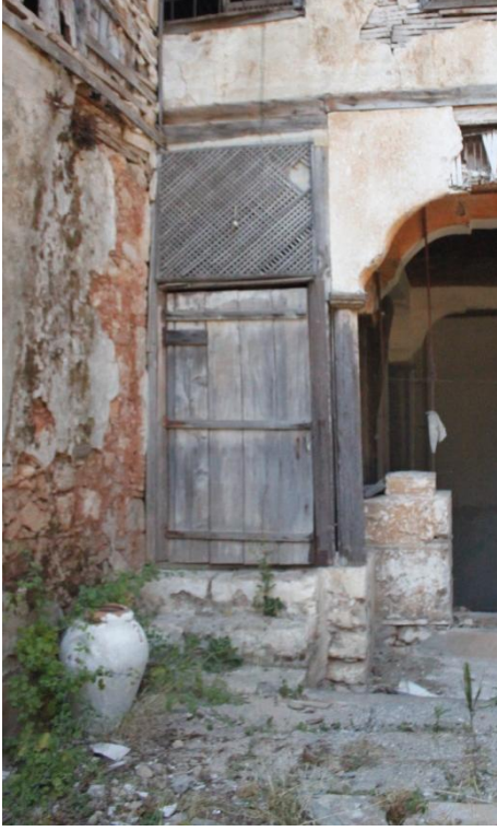
Şekil C 230. Güney cephesi / Taş sahanlıktan bahçeye çıkış.
