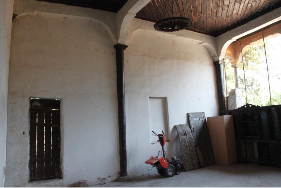
Şekil C 30. Z02 muhdes duvar.
