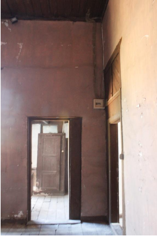
Şekil C 126. Ek binaya ve 1K08 mekanına geçiş.
