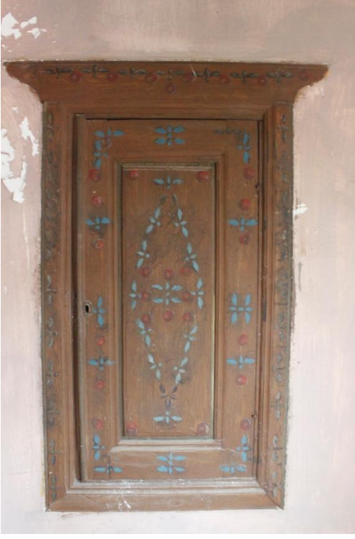
Şekil C 142. 1K06 güney duvarı gömme dolap.
