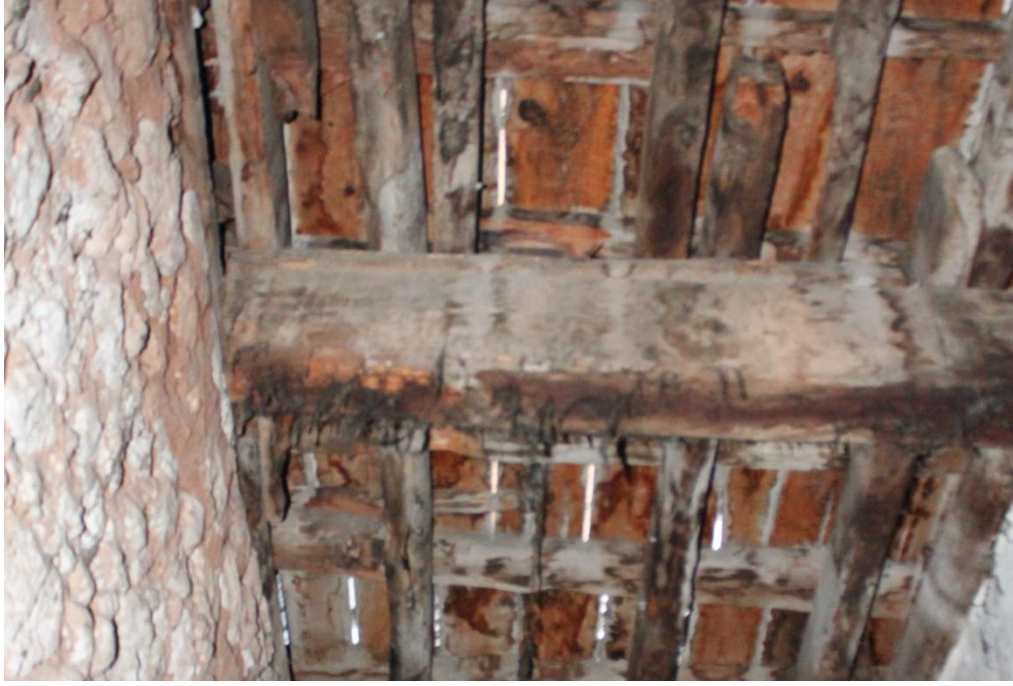
Şekil C 282. Restitüsyona göre hela mekanını taşıyan kiriş.
