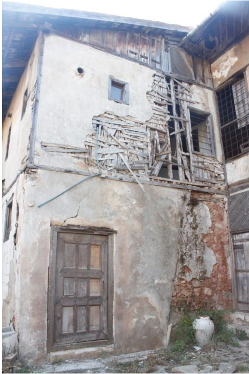
Şekil C 239. Doğu cephesi / Ek yapı.
