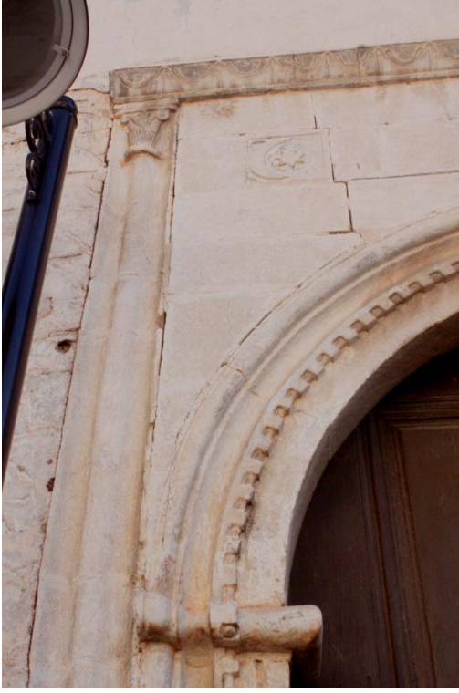
Şekil C 250. Ana kapı üzerinde bezemeler.
