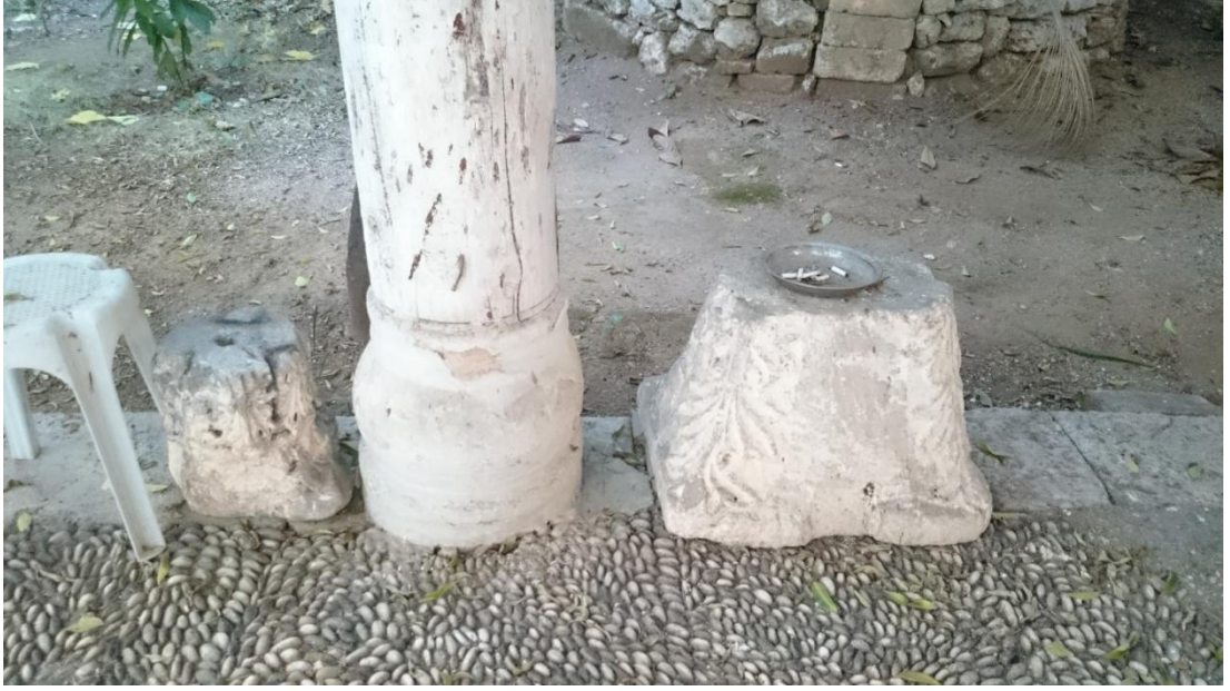
Şekil A 11. Taş kaideye oturan ahşap dikme / Müze Sokak, Paşa Konağı.
