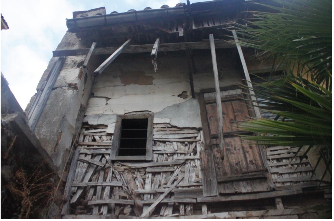
Şekil C 228. Güney cephesi / 1K09 kapı ve penceresi.
