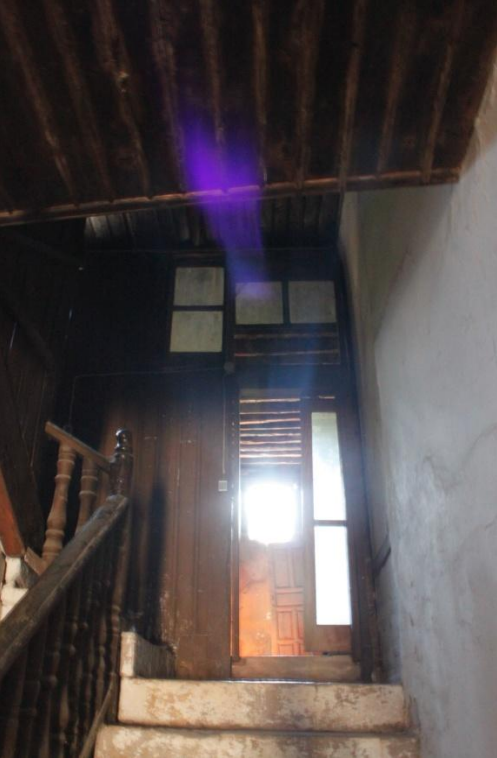
Şekil C 63. +2.07 kotundaki sahanlıktan ek kata geçiş.
