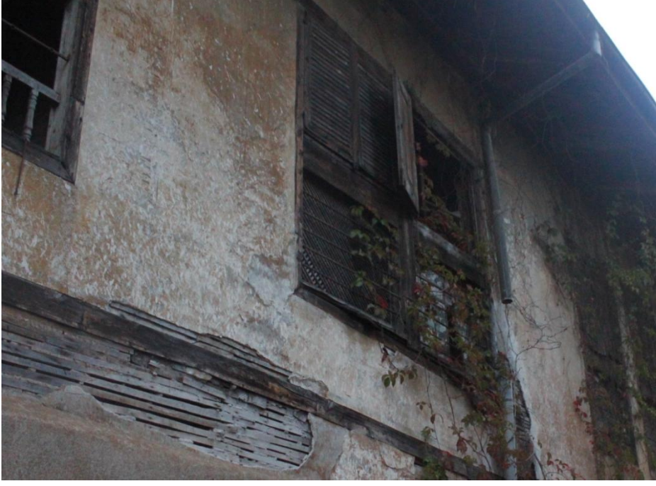
Şekil C 244. Doğu cephesi / 1K04 pencereleri.
