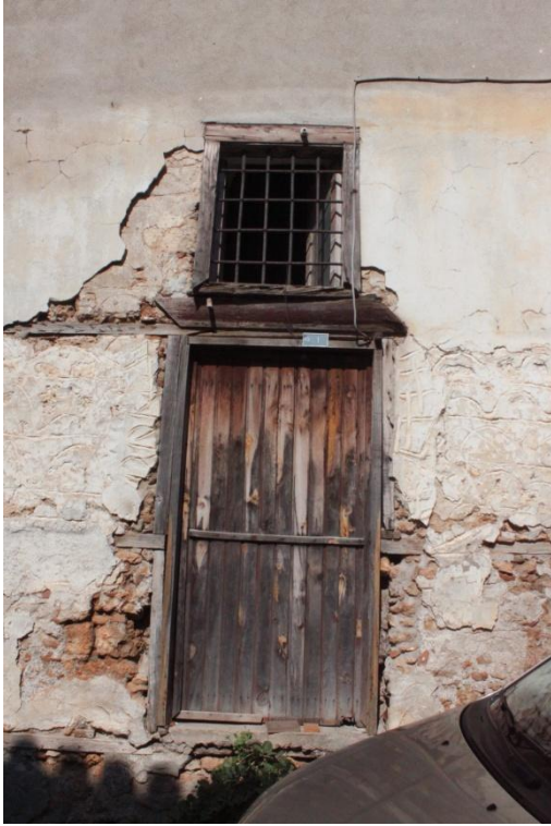
Şekil C 215. Batı cephesi / Z04 mekanından kapatılmış kapı ve tepe penceresi.
