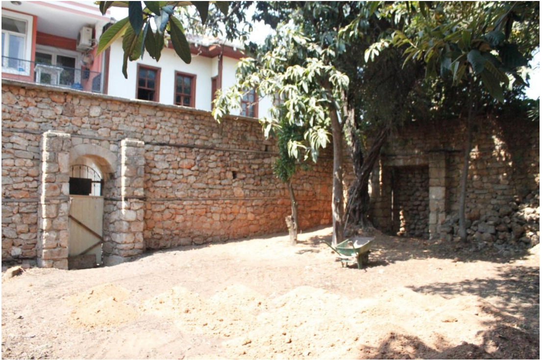
Şekil C 185. Taş bahçe duvarı.
