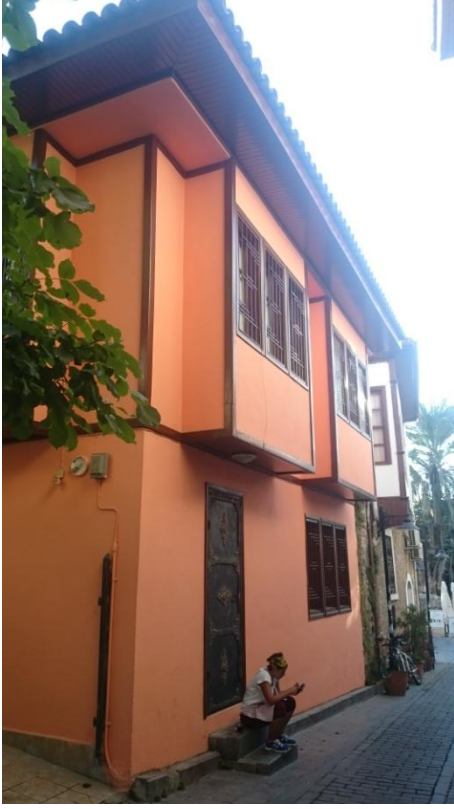
Şekil A 16. Betonarme yapı.
