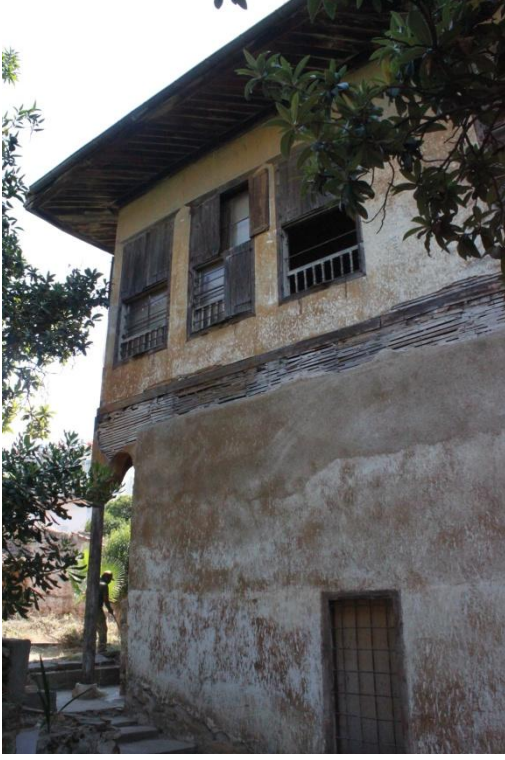
Şekil C 238. Doğu cephesi / Muhdes duvar.
