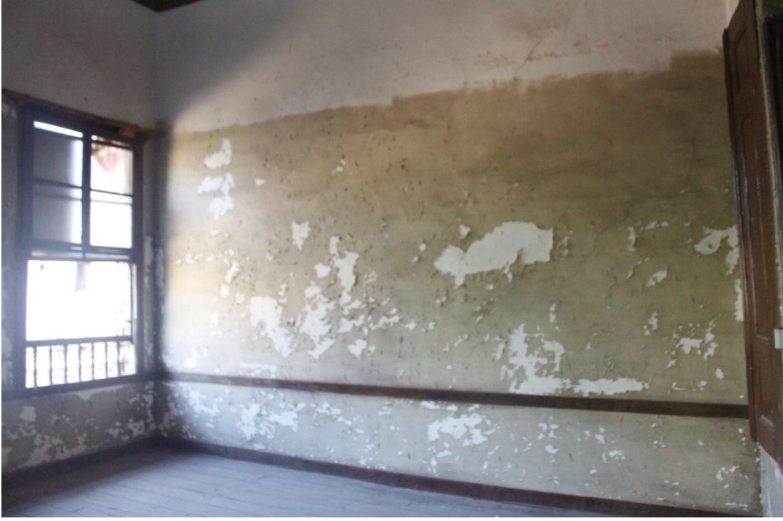
Şekil C 134. 1K05 batı duvarı.
