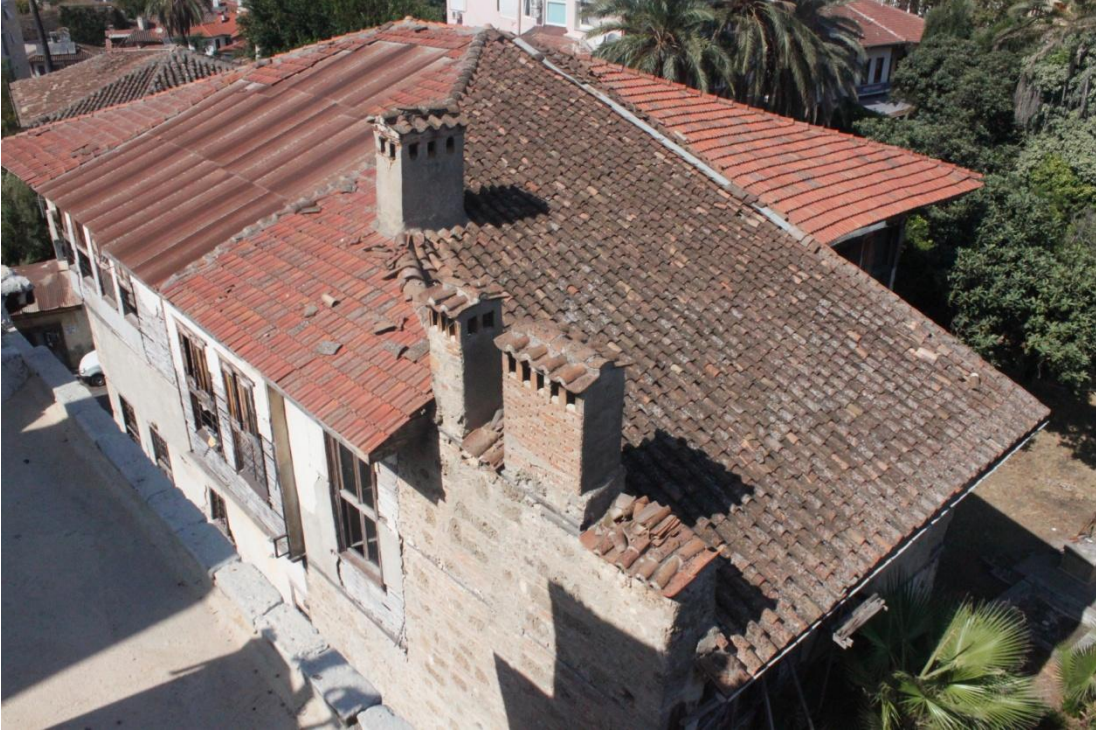
Şekil C 234. Güney cephesi / Çatı ve bacalar.
