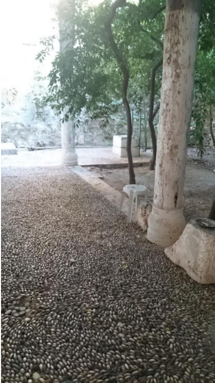
Şekil A 25. Çakıl taşı kaplama taşlık döşemesi / Müze Sokak Paşa Konağı.
