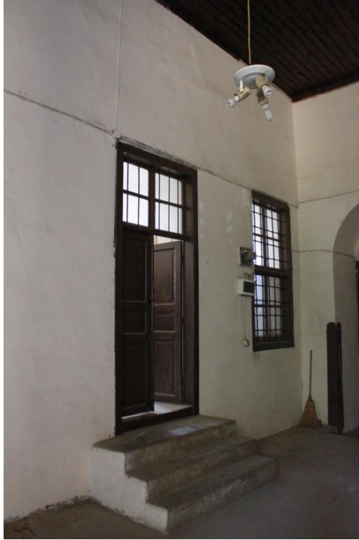
Şekil C 41. Z03 mekanı girişi.
