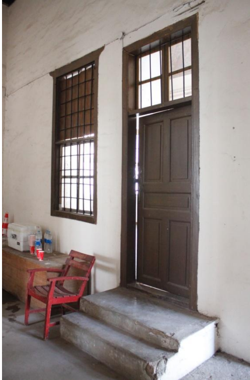
Şekil C 17. Z01 mekanı girişi.
