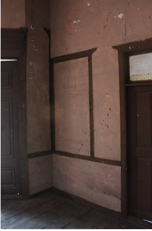
Şekil C 284. 1K02 mekanı doğu ve batı duvarındaki ahşap çerçevelerin 1K04 mekanında devamı.
