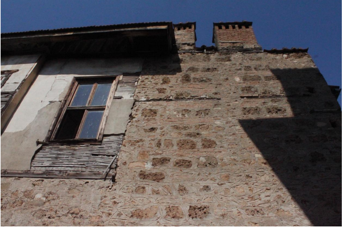
Şekil C 220. Batı cephesi / Taş duvar ve bacalar.
