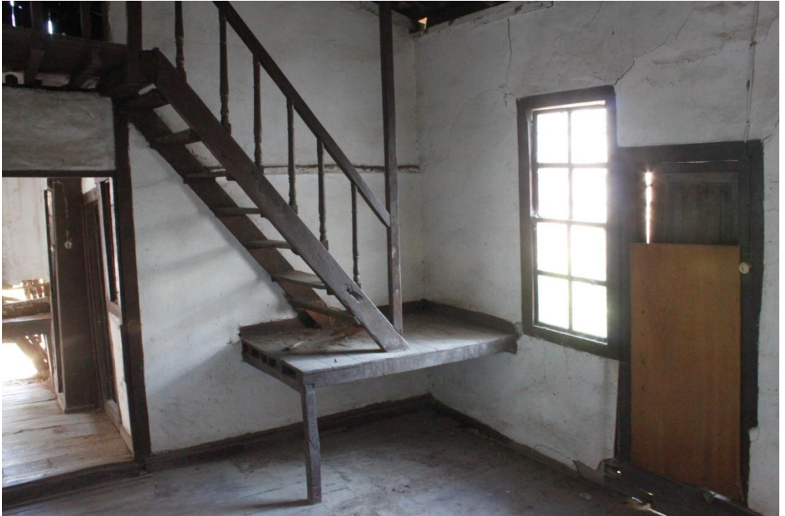
Şekil C 156. 1K09 batı duvarı merdiven platformu.
