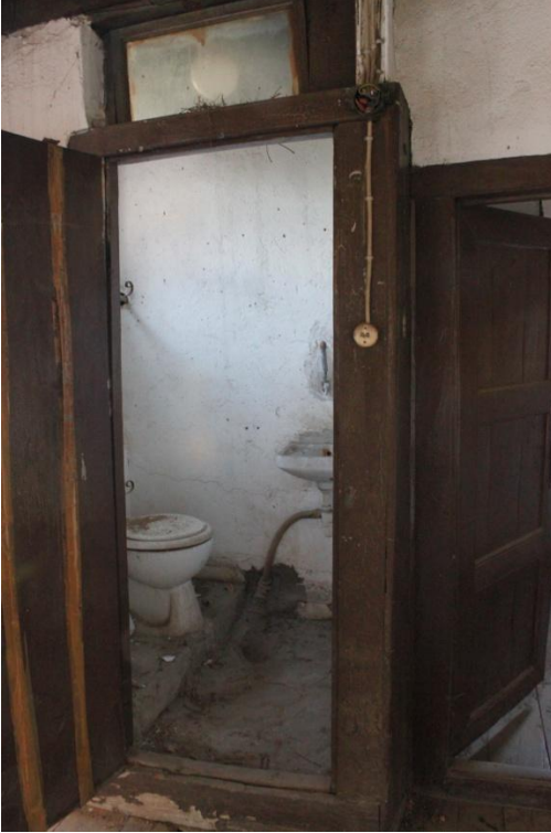
Şekil C 177. 1K10'dan 1K13 mekanına geçiş.
