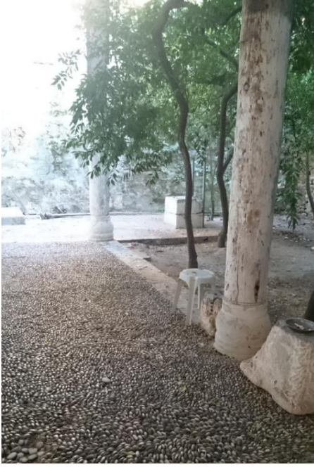
Şekil A 13. Taş kaideye oturan ahşap dikmeler / Müze Sokak, Paşa Konağı.
