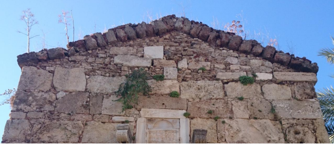
Şekil C 5. Nöbethane burcunun onarım görmüş bölümü ve taş saçakları.
