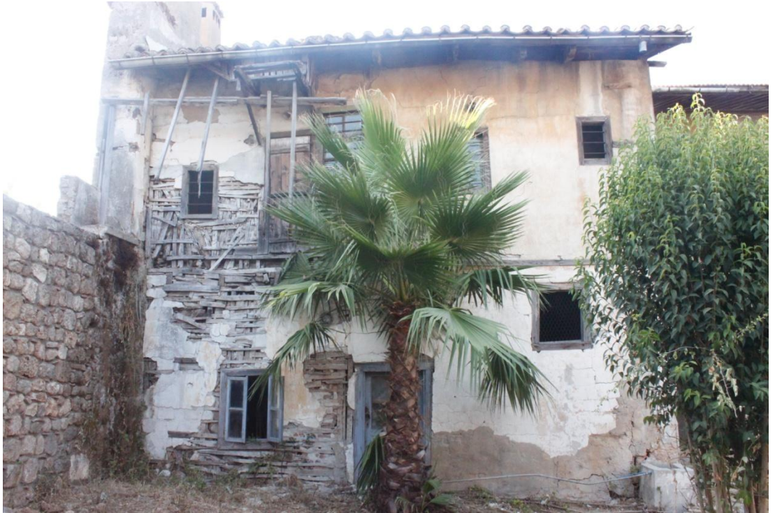
Şekil C 225. Güney cephesi / Ek yapı.
