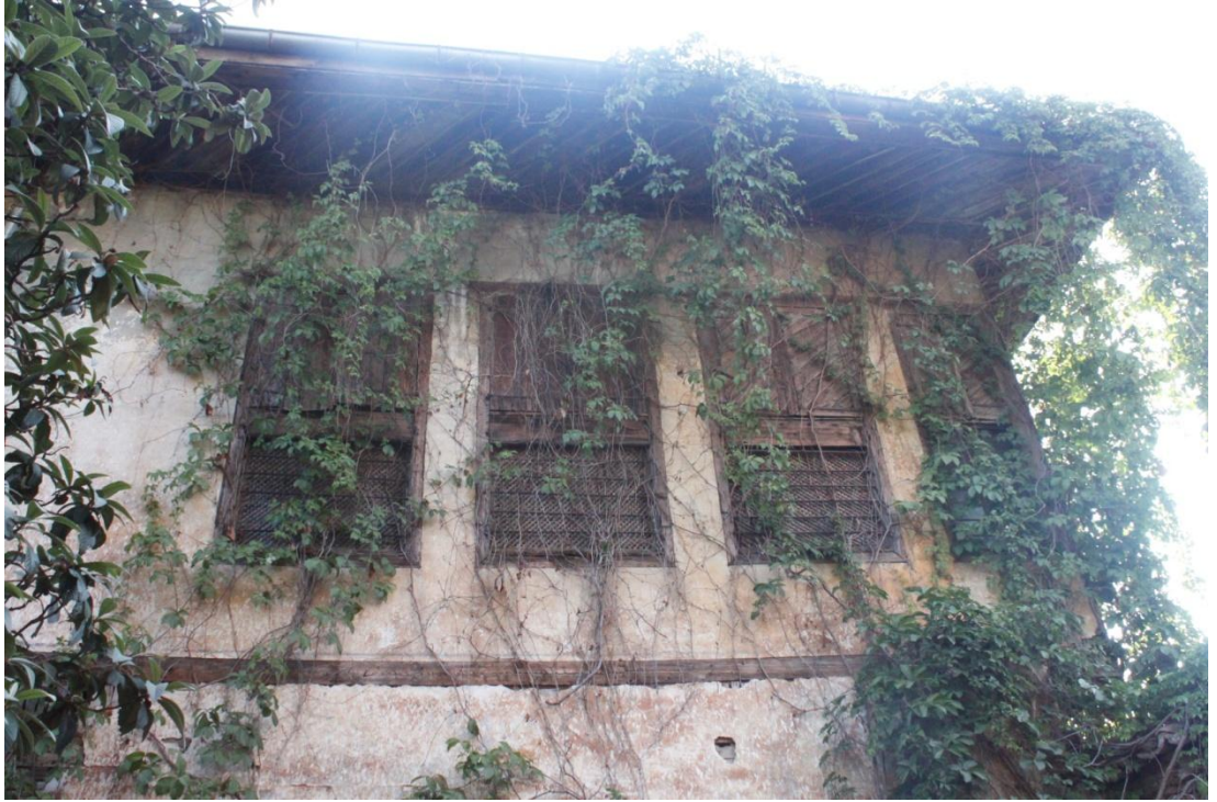
Şekil C 245. Doğu cephesi / 1K03 pencereleri.
