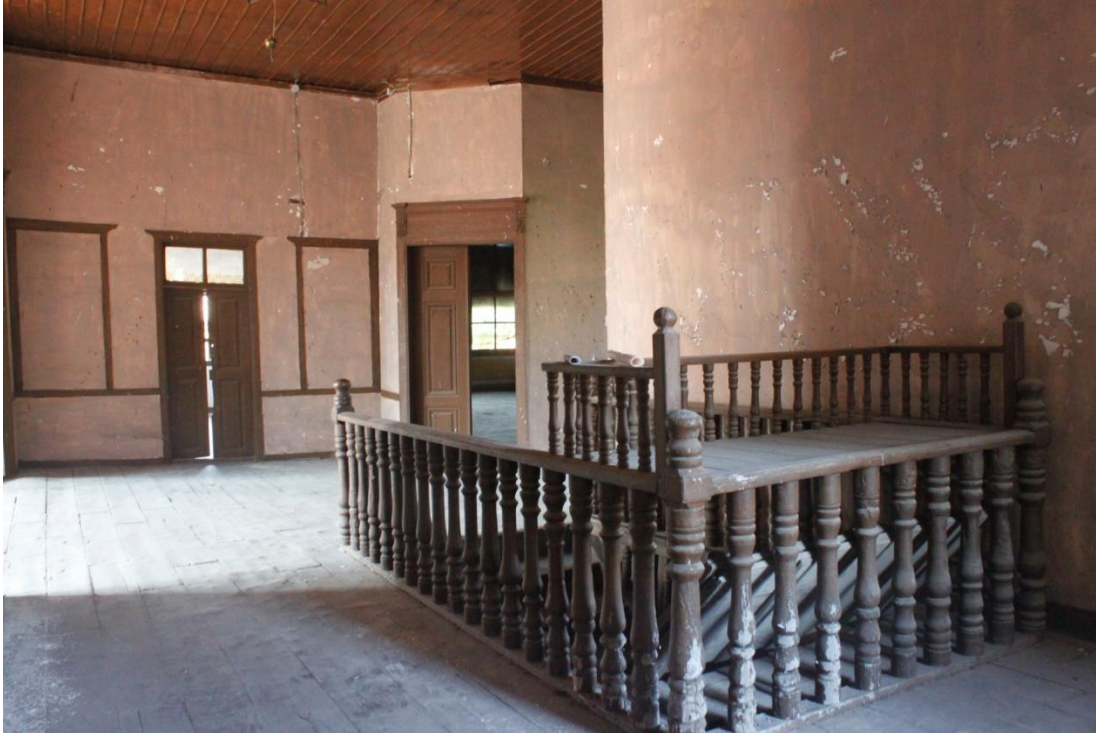
Şekil C 117. 1K04 mekanına çıkan akşam merdiven.
