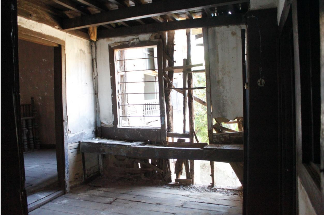
Şekil C 162. 1K10 mekanı giriş kapısı ve doğu duvarı.
