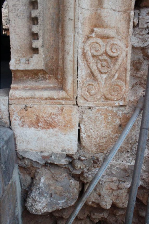
Şekil C 202. Kuzey cephe / Giriş kapısı kabartma ve dişli frizler.
