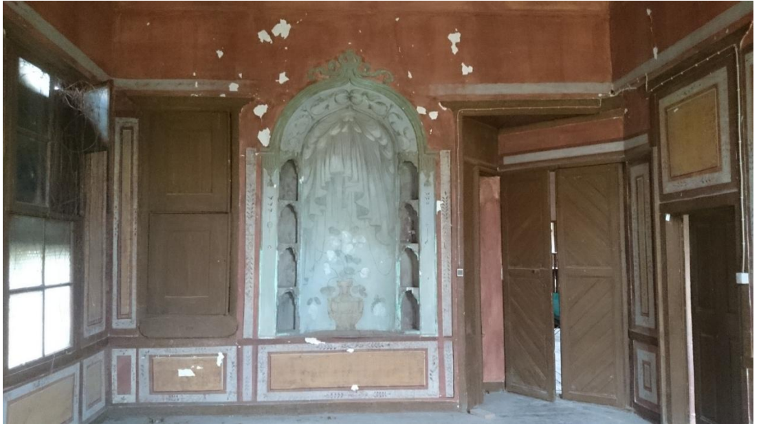
Şekil C 109. 1K03 girişı ve nişli duvar.
