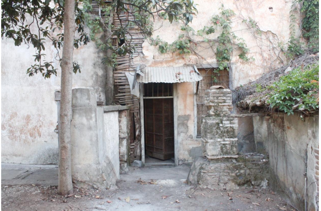
Şekil C 237. Doğu cephesi / Z01 kapı ve penceresi.
