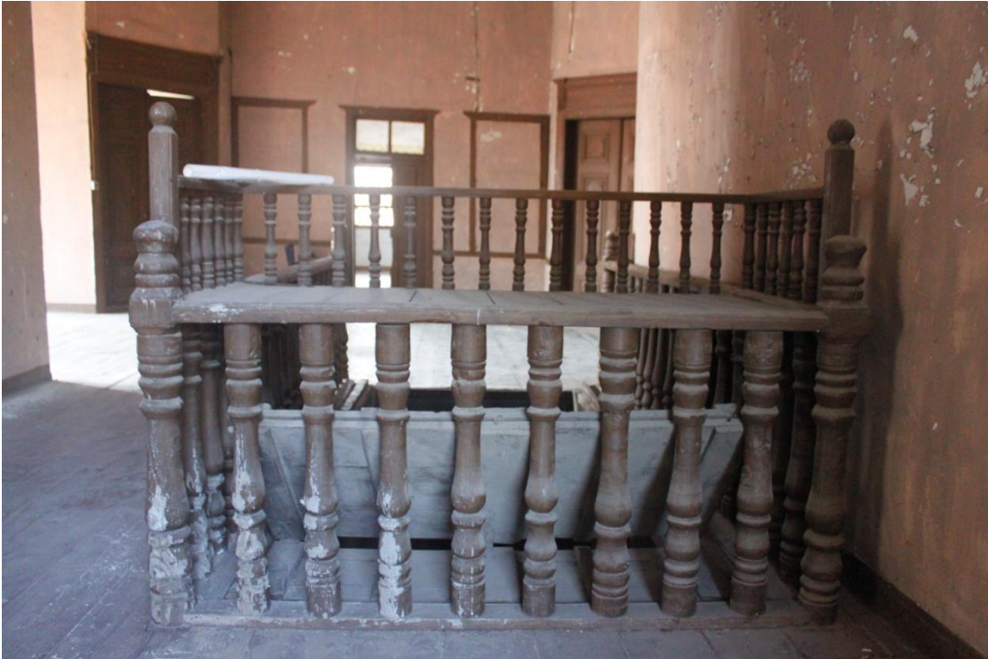
Şekil C 123. 1K04 ahşap merdiven platformu.
