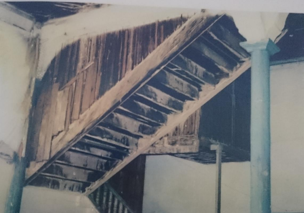
Şekil C 290. 1989 yılı rölövesi / ahşap merdiven altı ZO2 mekanı.
