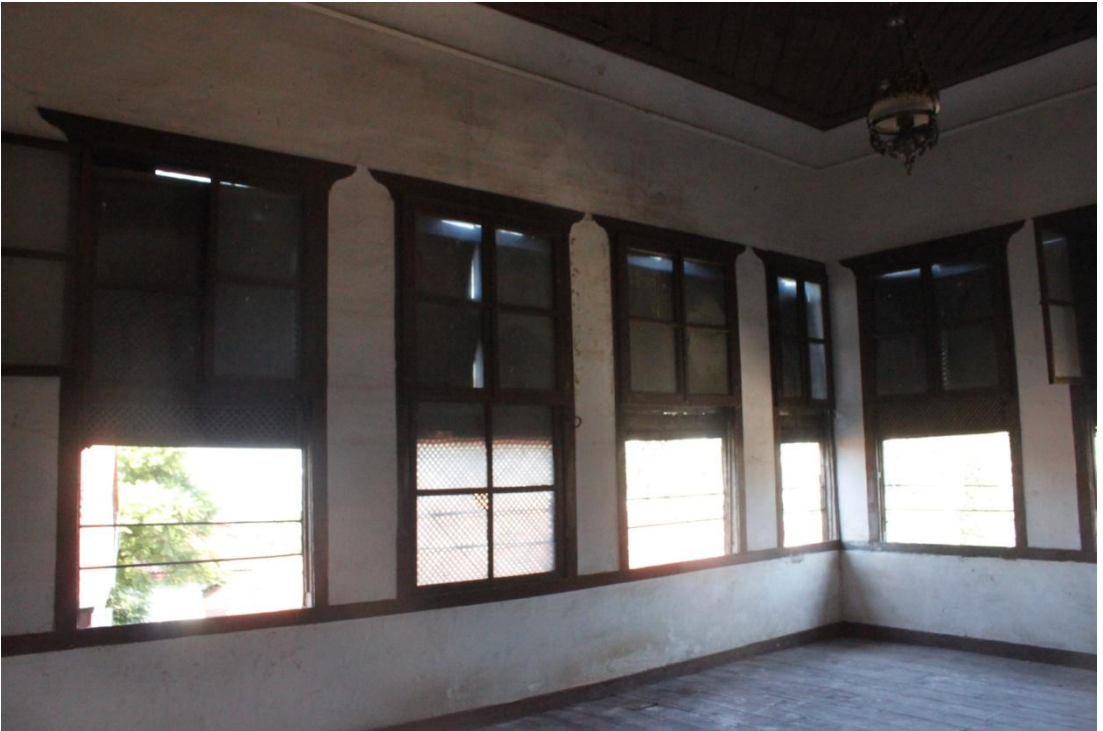
Şekil C 96. 1K01 batı duvarı üzerinde pencereler.
