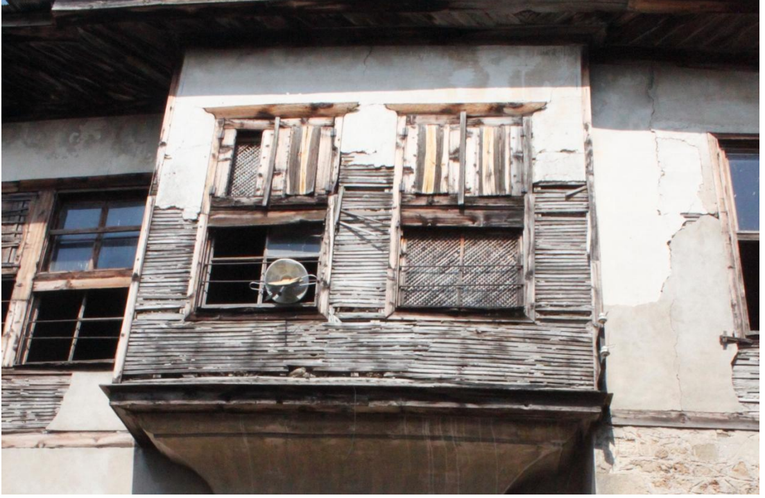
Şekil C 281. Sıva dökülmesi.
