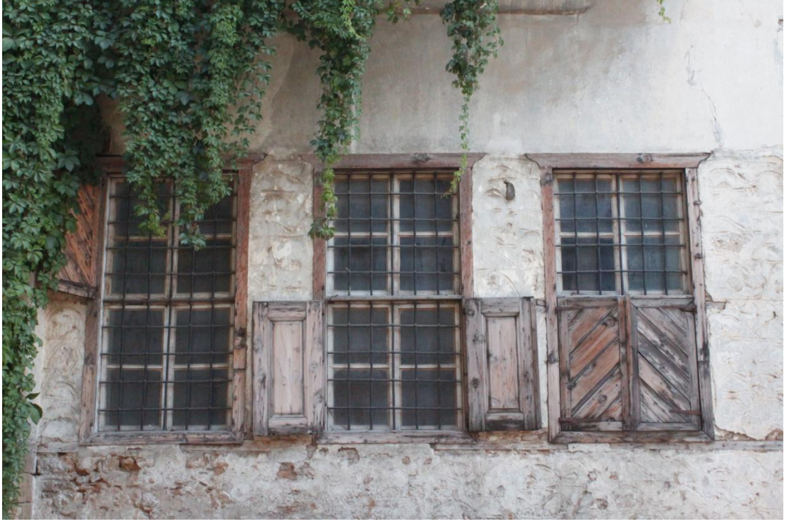
Şekil C 204. Kuzey cephe / Z01 mekanı pencereleri.
