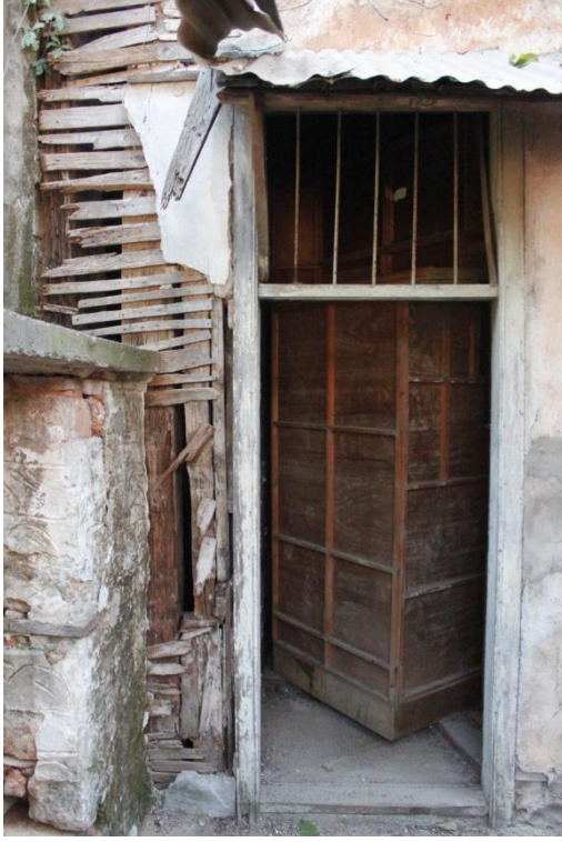
Şekil C 240. Doğu cephesi / Z01 bahçeye geçiş kapısı.
