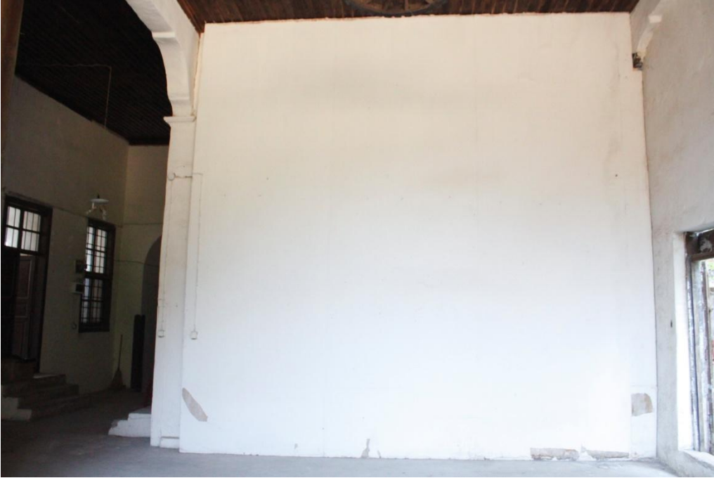
Şekil C 39. Z01 ile Z02(taşlık) arasındaki duvar önünde kontraplak kaplama.
