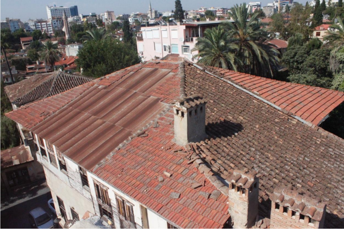
Şekil C 223. Batı cephesi / Çatı.
