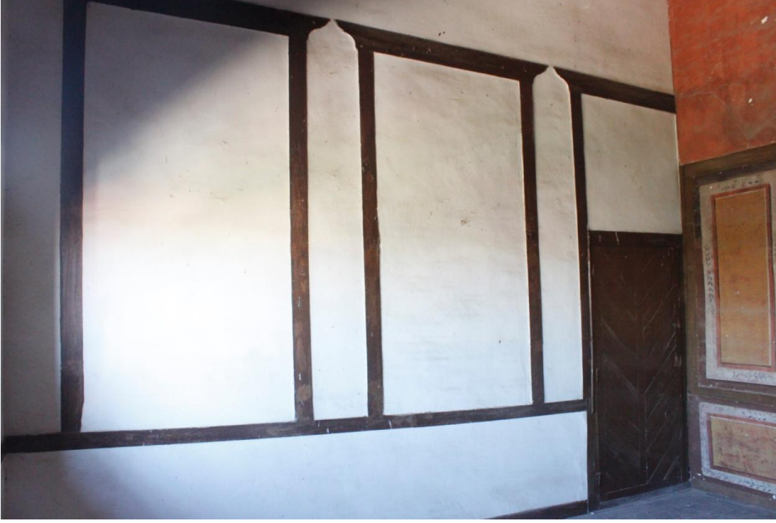
Şekil C 102. 1K02 mekanı doğu duvarı üzeri ahşap çerçeveler ve 1K03'e geçiş kapısı.
