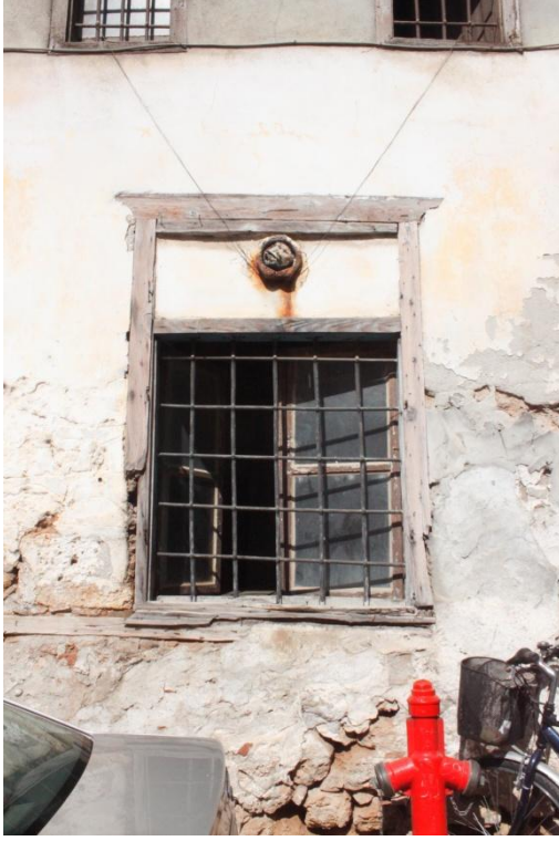
Şekil C 216. Batı cephesi / Z05 penceresi.
