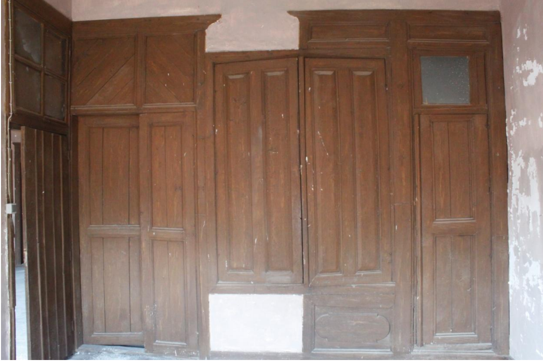
Şekil C 138. 1K06 doğu duvarı.
