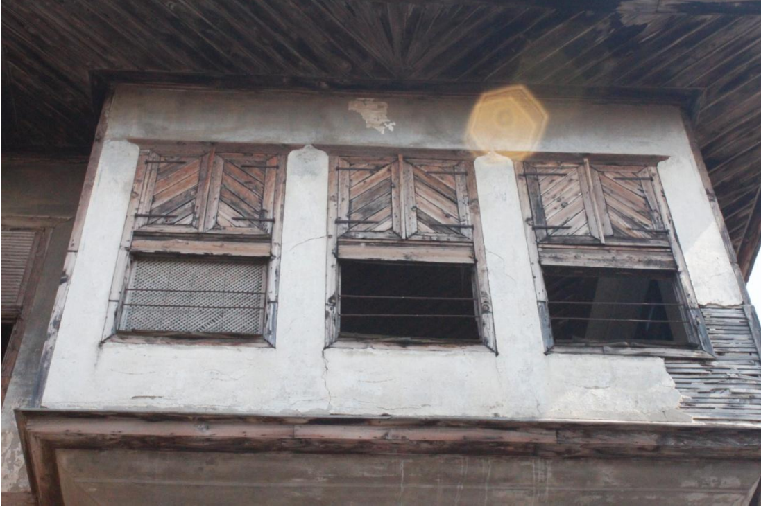
Şekil C 207. Kuzey cephe / batı cumbası.
