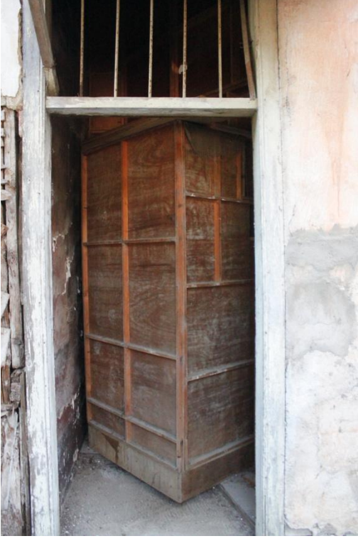
Şekil C 22. Z01 bahçeye açılan kapı.
