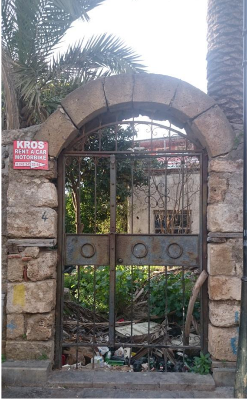
Şekil C 186. Civelek Sokak girişi.
