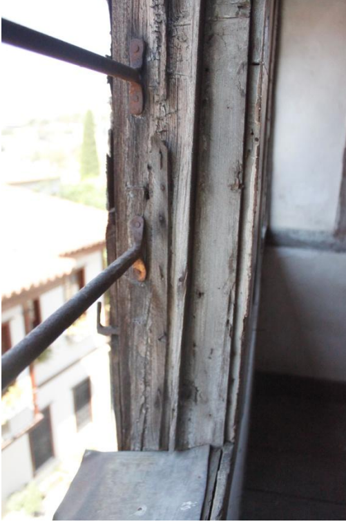
Şekil C 98. Demir korkuluklar ve denizlik üzeri sac levha.
