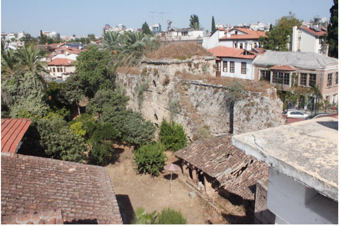
Şekil C 188. Sur duvarı ve burç.
