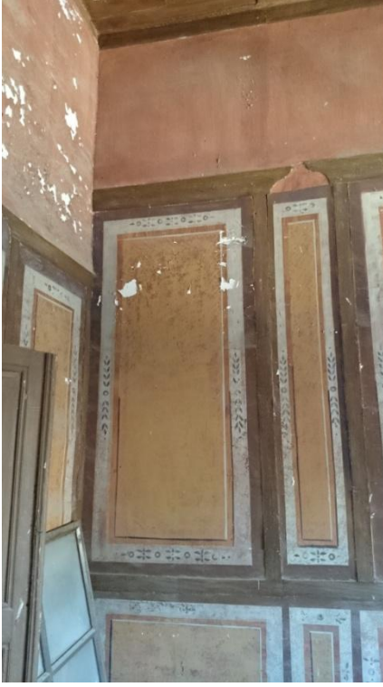
Şekil C 104. 1K02 güney ve batı duvarı üzerinde farklı boyutlarda ahşap çerçeveler.
