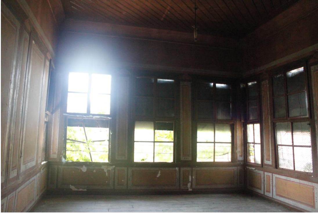
Şekil C 111. 1K03 kuzey duvarı pencereleri.
