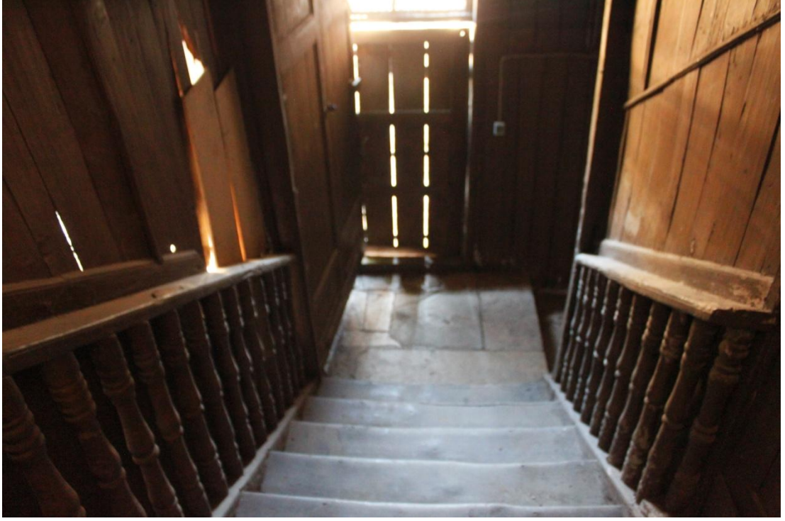
Şekil C 68. Ahşap merdiven trabzanları ve ahşap panel duvar.
