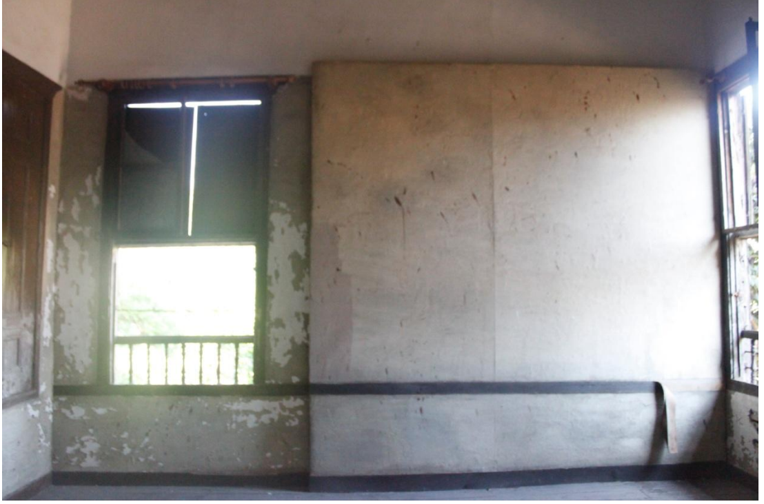
Şekil C 133. 1K05 doğu duvarı.
