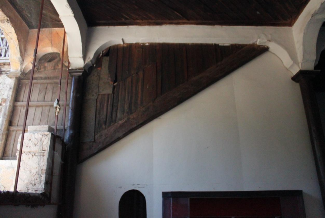
Şekil C 67. Ahşap merdiveni taşıyan ahşap kiriş.
