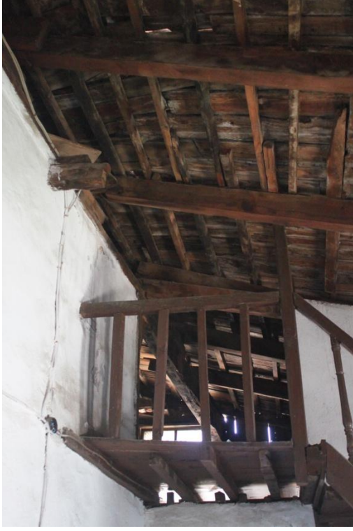
Şekil C 158. 1K09 merdivenle çatıya çıkış.
