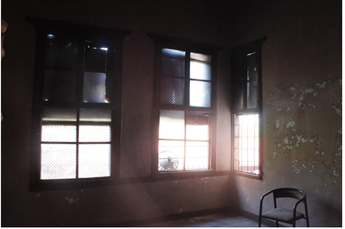
Şekil C 140. 1K06 batı duvarı.
