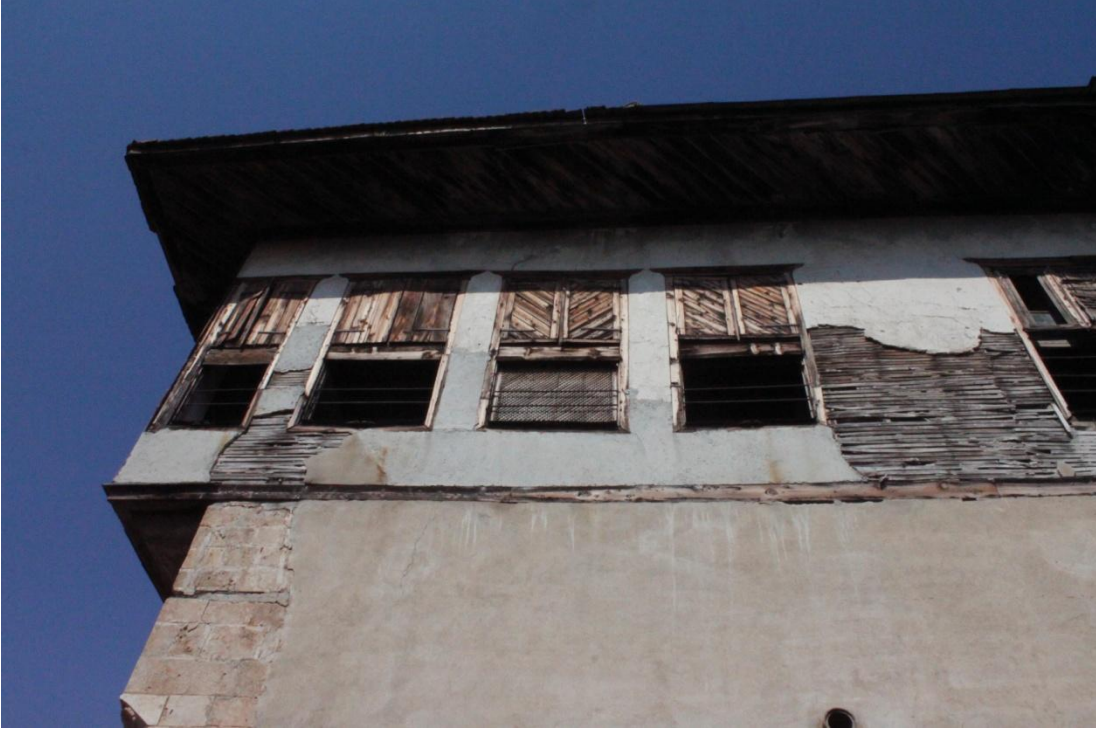
Şekil C 218. Batı cephesi / 1K01 pencereleri.
