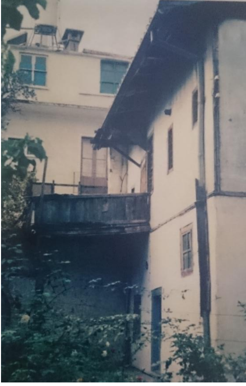
Şekil C 291. 1989 yılı rölövesi / Ek yapı güney cephesi.
