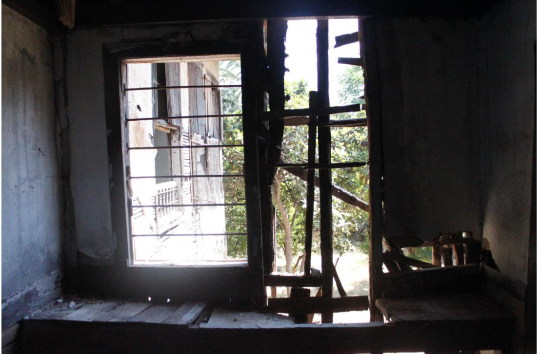
Şekil C 165. 1K10 doğu duvarı.
