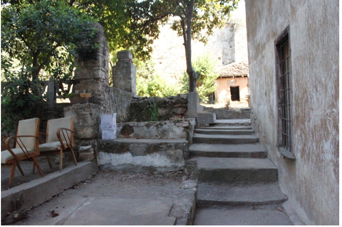
Şekil C 192. Üst bahçeye çıkan beton merdiven.
