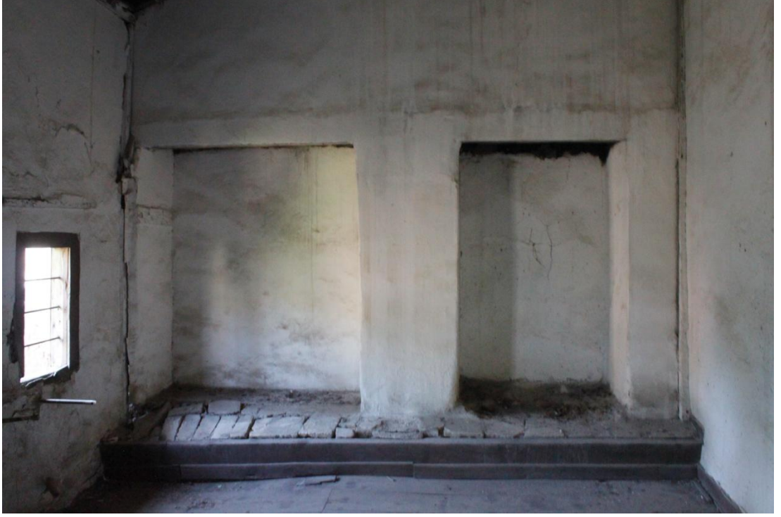
Şekil C 157. 1K09 mekanı batı duvarı.
