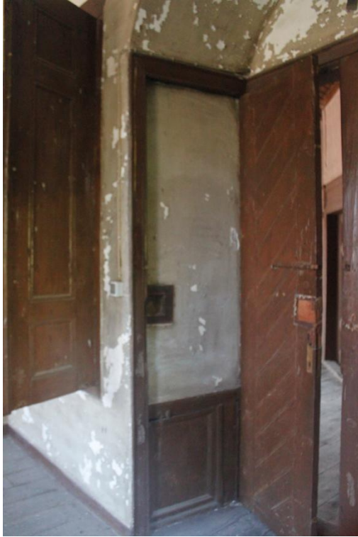
Şekil C 135. 1K05 giriş kapısının oturduğu bölüm.
