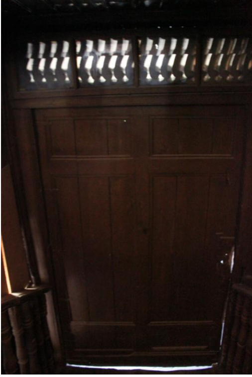
Şekil C 254. Ahşap merdiven giriş kapısı.
