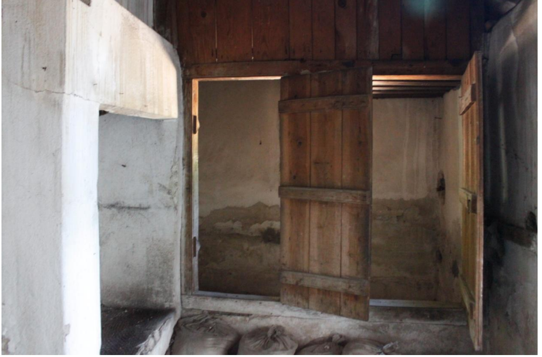
Şekil C 197. Servis yapısı 1'in iç mekanı.
