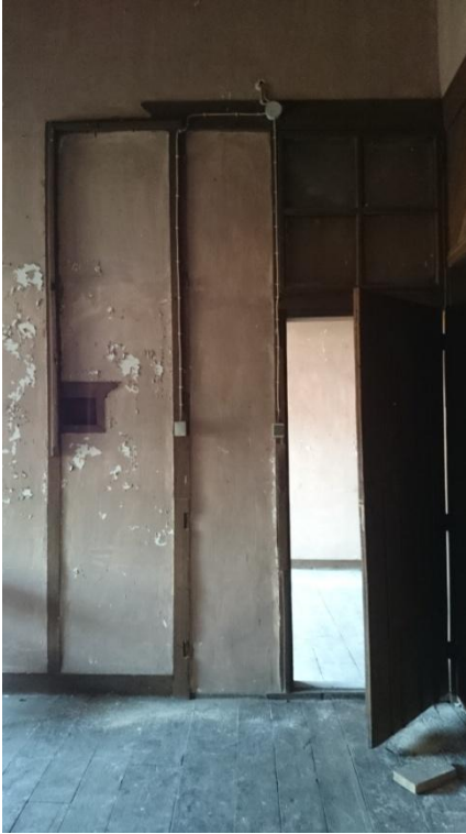
Şekil C 139. 1K06 kuzey duvarı giriş kapısı.
