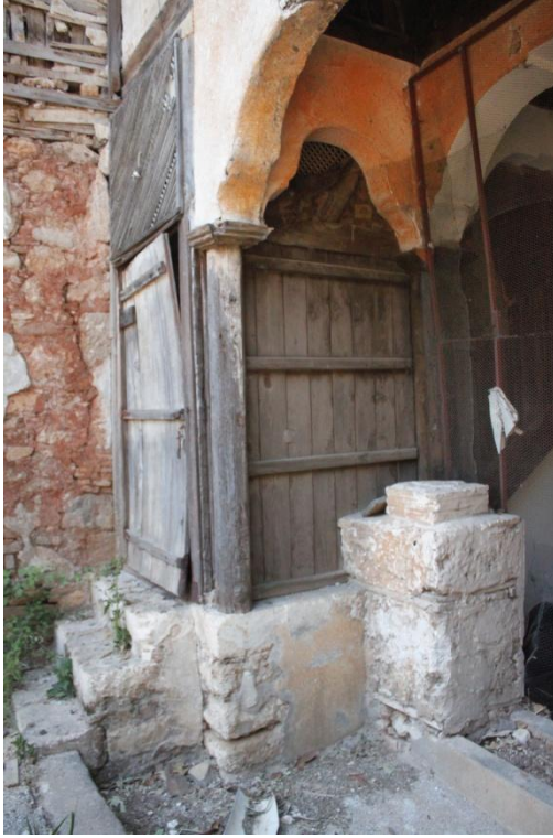
Şekil C 65. Taş sahanlığa oturan sekizgen ahşap dikme.
