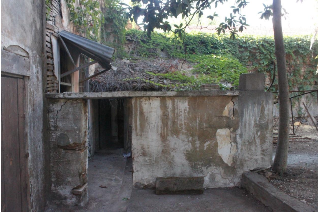
Şekil C 195. Servis yapısı avlu girişi.
