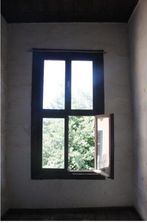
Şekil C 153. 1K08 batı duvarı.
