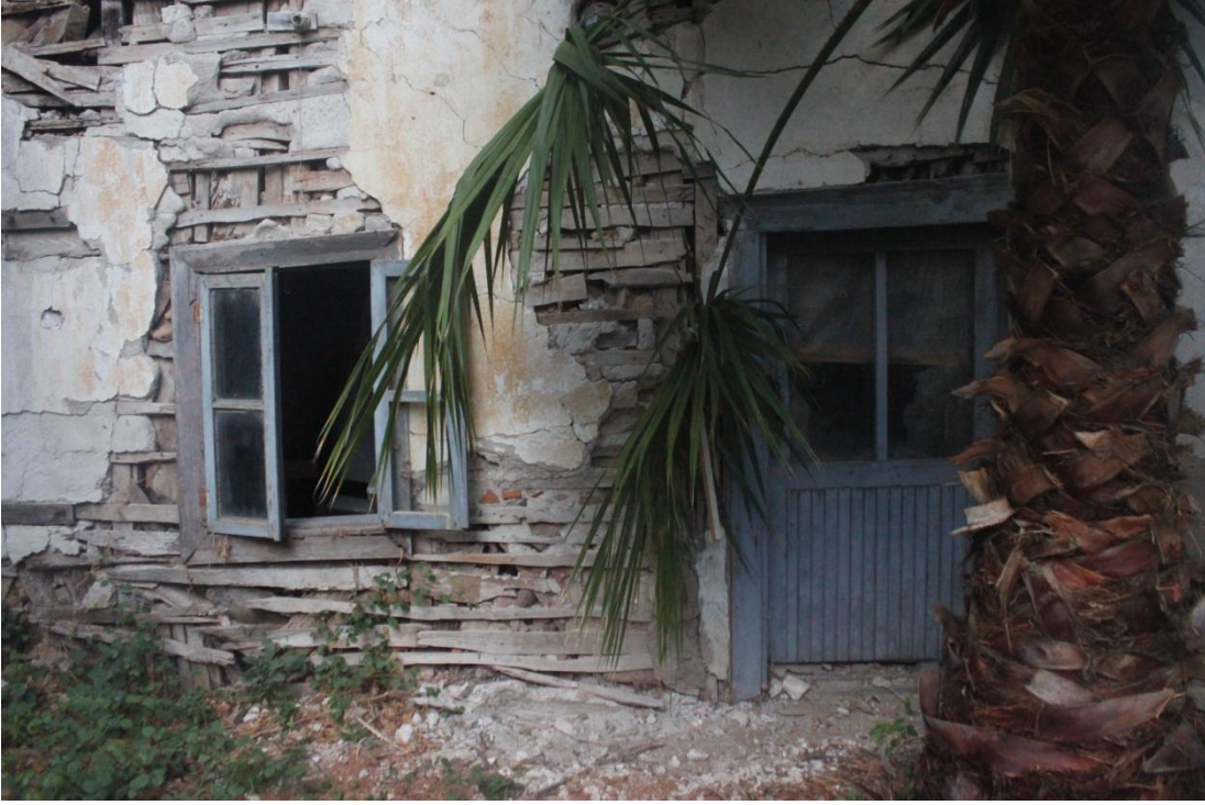
Şekil C 226. Güney cephesi / EK02 kapı ve penceresi.
