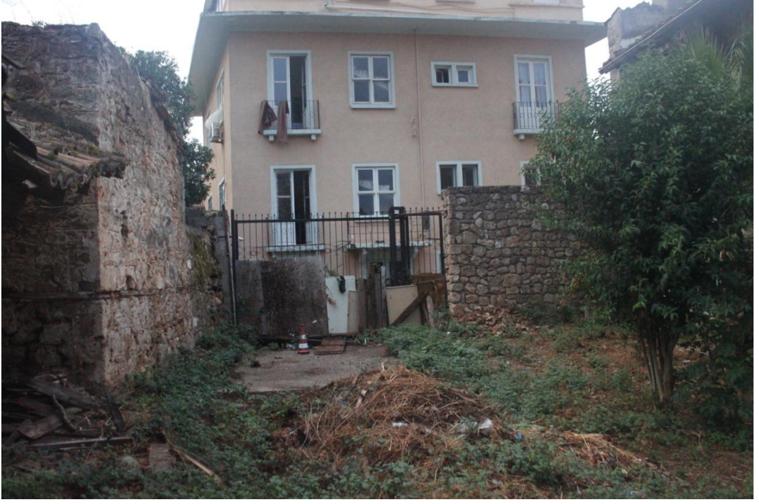
Şekil C 248. Doğu cephesi / Demir kapılı bahçe girişi.
