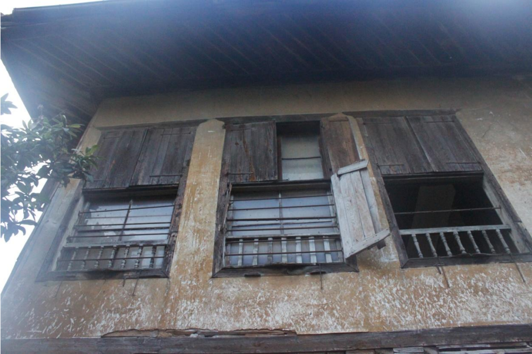
Şekil C 242. Doğu cephesi / 1K05 pencereleri.
