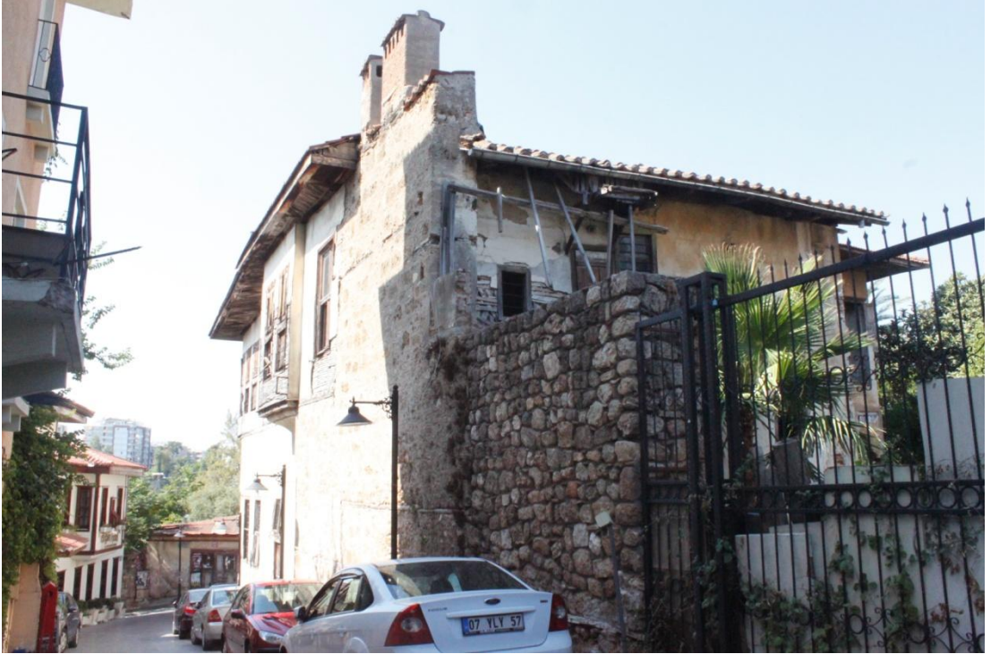
Şekil C 221. Batı cephesi / demir bahçe kapısı.
