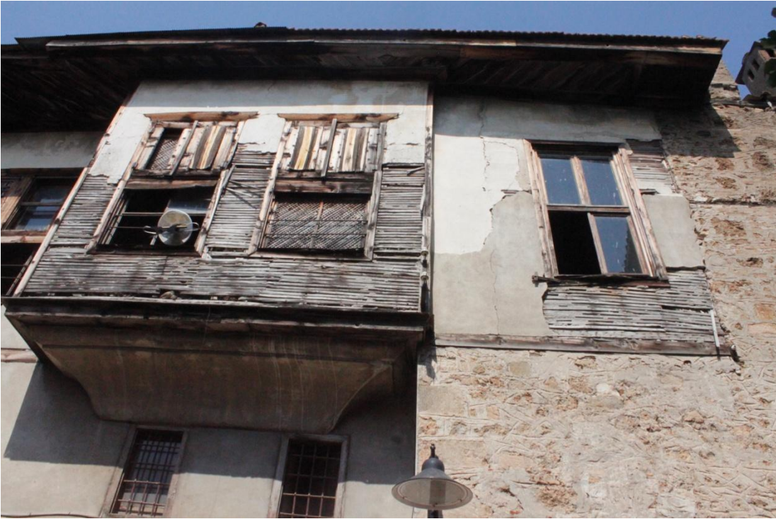
Şekil C 219. Batı cephesi / Cumba ve 1K08 penceresi.
