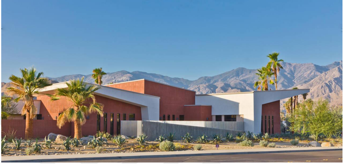
Şekil 21. Palm Springs Animal Care Facility Genel Görünüm
