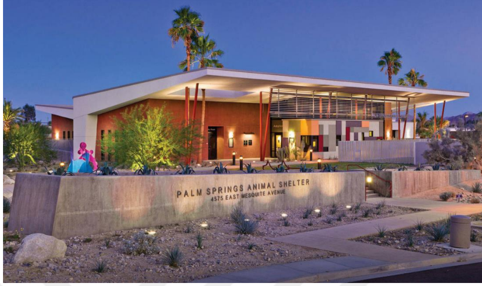
Şekil 22. Palm Springs Animal Care Facility giriş genel görünüm
