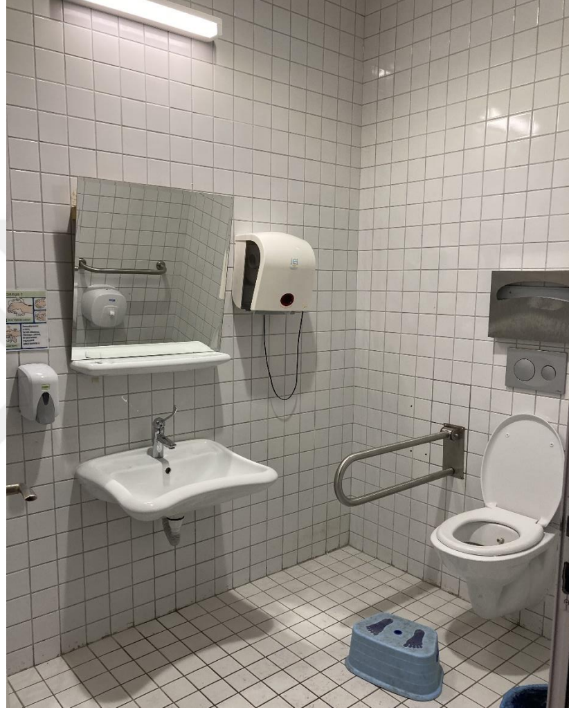
Şekil 67. Engelli tuvaleti genel görünüm
