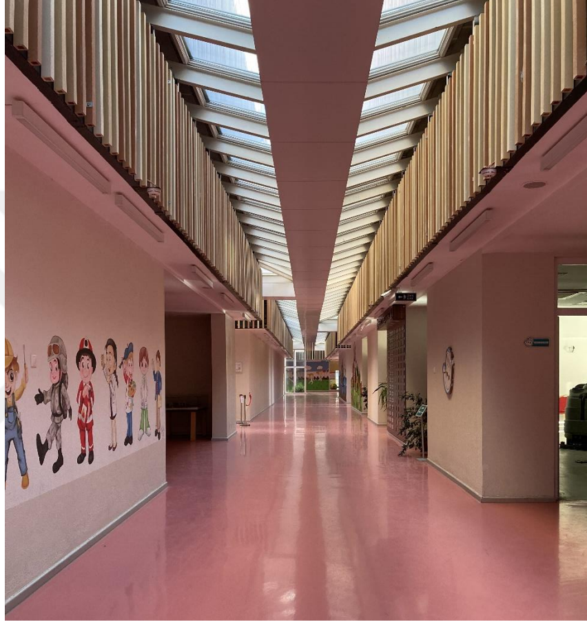
Şekil 62. Koridorlarda doğal aydınlatma kullanımı
